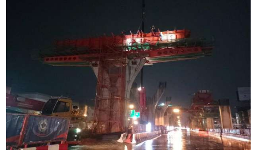
MLP04-13 งานติดตั้ง Formwork Side For Crossbeam Type Y-1
