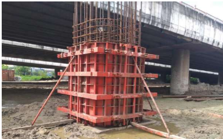
MLP03-04L งานติดตั้ง Formwork Column และผูกเหล็กเสริม Column Type PT-44A Step 1
