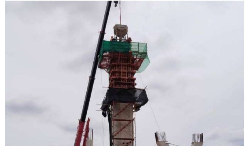
MLP04-04L เทศอนกรีต Column Type IYI-4 Step 3
