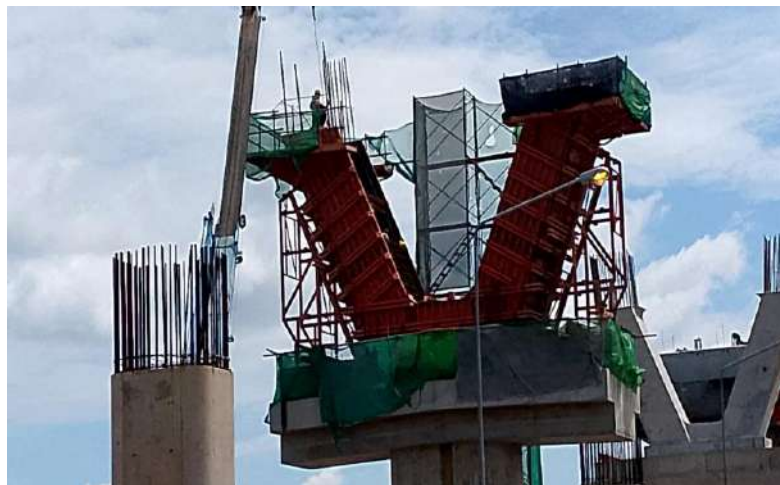
MLP01-11C งานผูกเหล็กเสริม และติดตั้ง Formwork Column Type YT-1 Step Y
