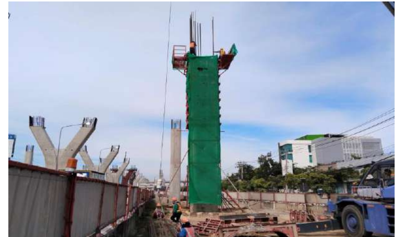
MLP04-01L งานผูกเหล็กเสริม Column Type IYI-4 Step 2
