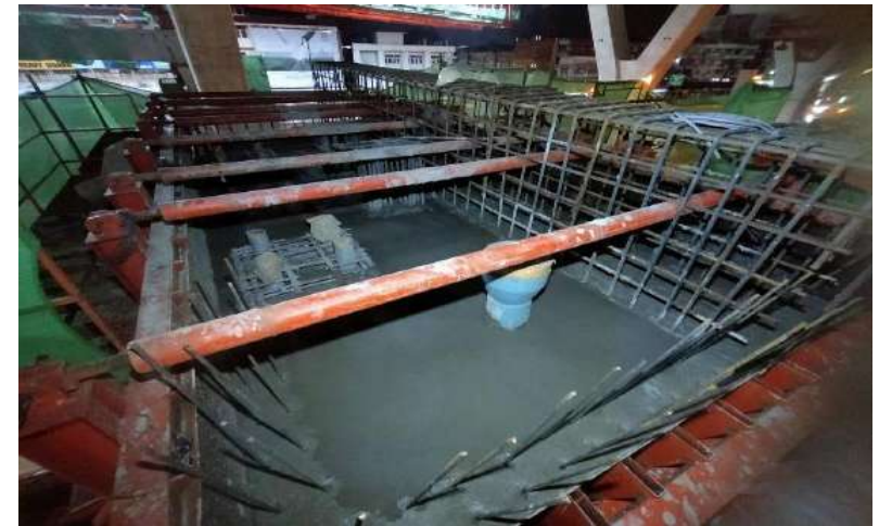
RON2-21R งานเทคอนกรีต Cross Beam Type T-4
