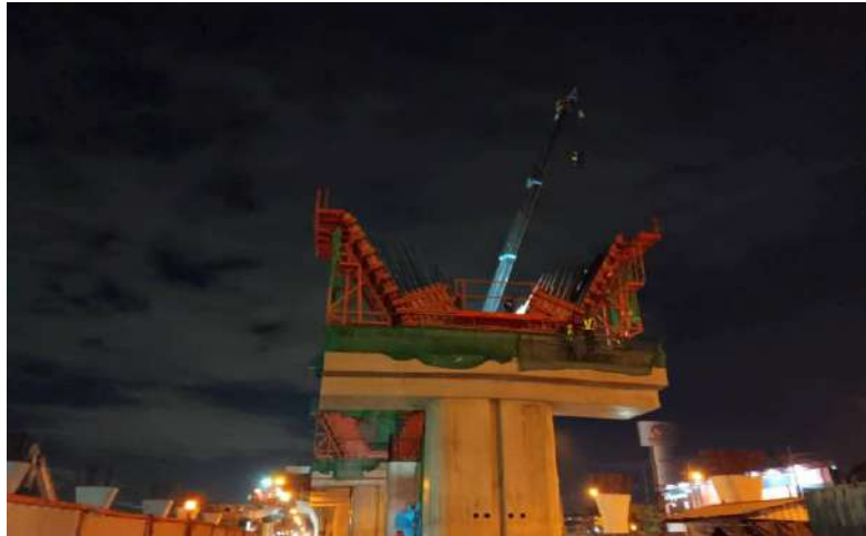
MLP01-09C งานติดตั้ง Formwork Column Type YT-1 Step Y
