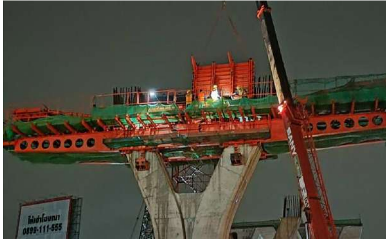
MLP04-13 งานติดตั้ง Formwork Side For Crossbeam Type Y-1
