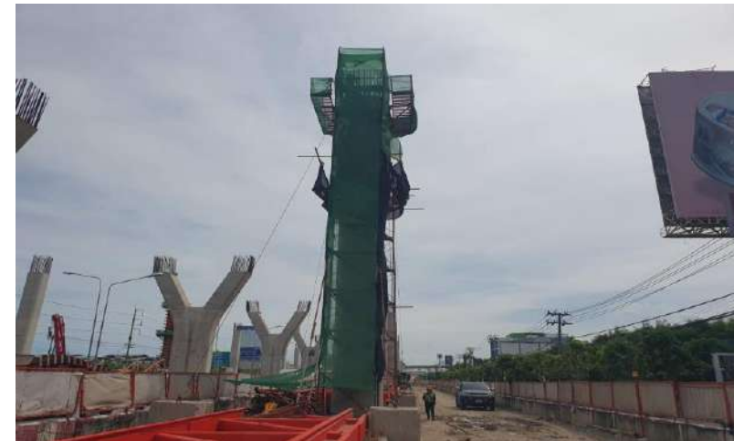
MLP04-04L งานติดตั้ง Formwork Column Type IYI-4 Step 3
