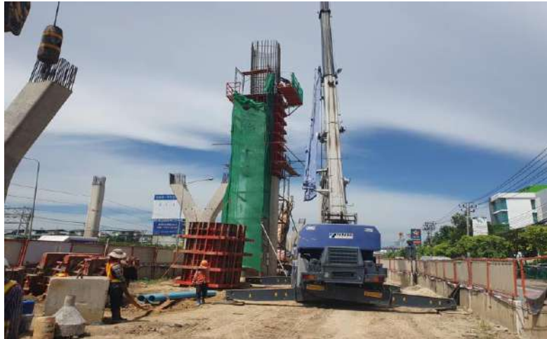
MLP04-01L งานผูกเหล็กเสริม Column Type IYI-4 Step 2
