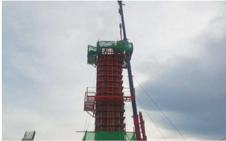
MLP04-02L งานเทคอนกรีต Column Type IYI-4 Step 2
