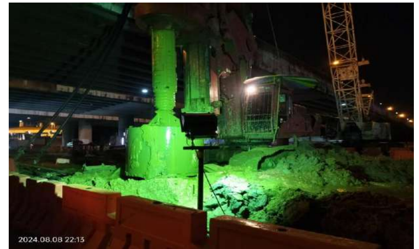
MLP03-07/2L งานเจาะ Bored Pile 1.80 m.
