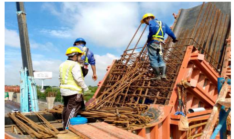
MLP01-11C งานผูกเหล็กเสริม และติดตั้ง Formwork Column Type YT-1 Step Y
