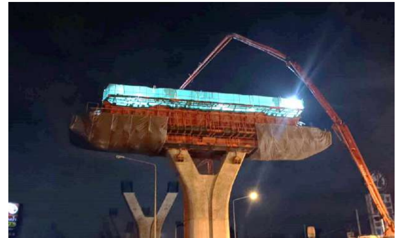
MLP02-10C งานเทคอนกรีต Crossbeam Type Y-1
