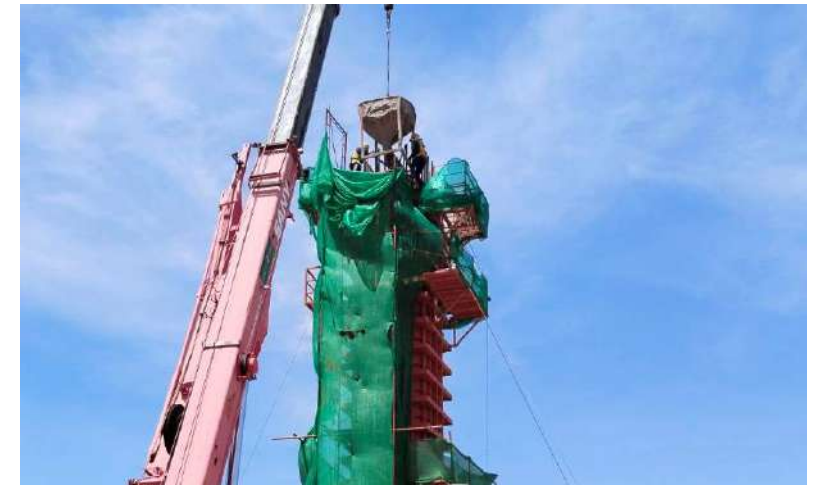
MLP04-01L งานเทคอนกรีต Column Type IYI-4 Step 2-3
