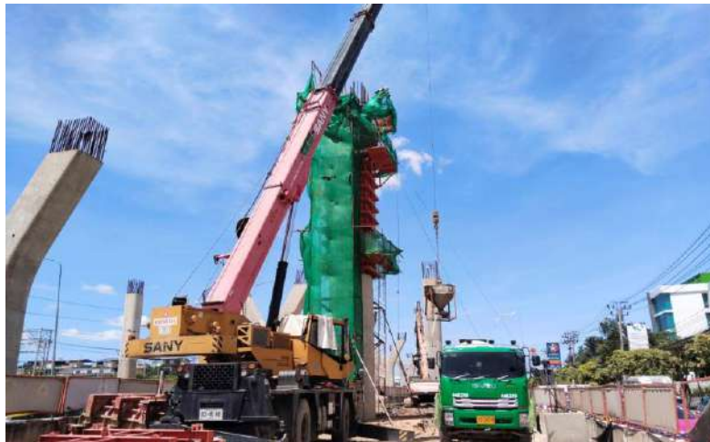
MLP04-01L งานเทคอนกรีต Column Type IYI-4 Step 2-3
