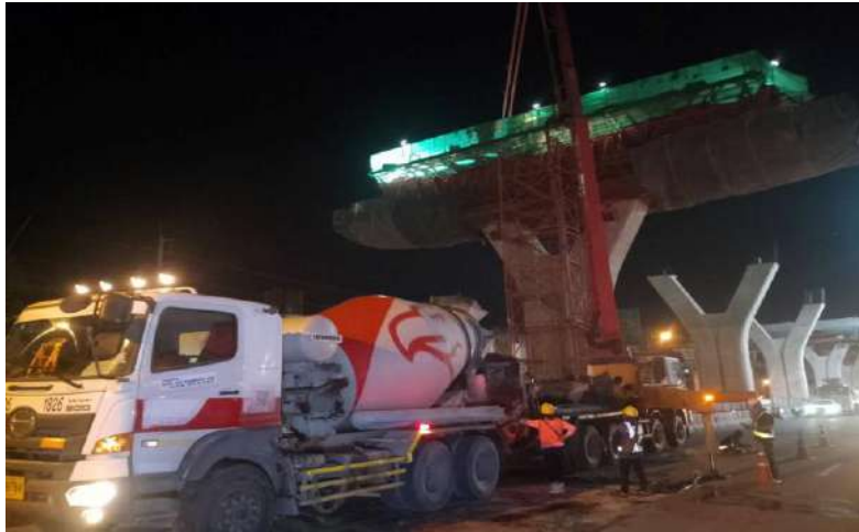
MLP04-13 งานเทคอนกรีต Crossbeam Type Y-1
