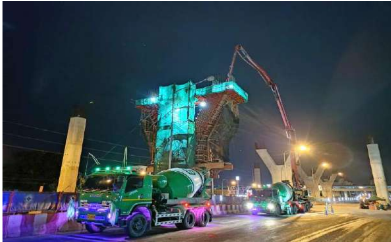
MLP03-25C งานเทคอนกรีต Column Type YI-2 Step Y
