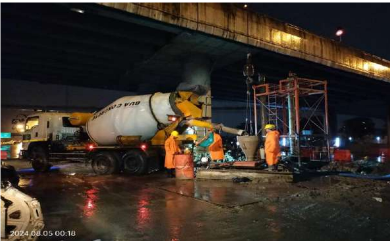
MLP03-08/1L เทศคอนกรีต Bored Pile 1.80 m.
