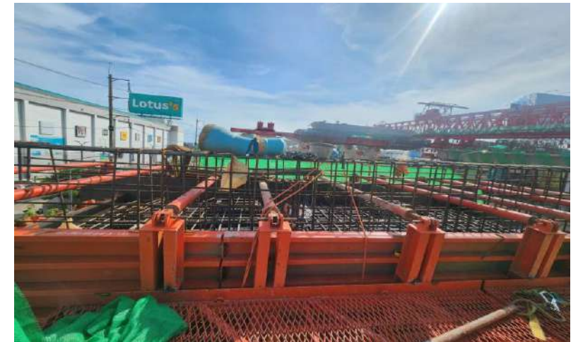
RON2-21R งานผูกเหล็กเสริม Cross Beam Type T-4
