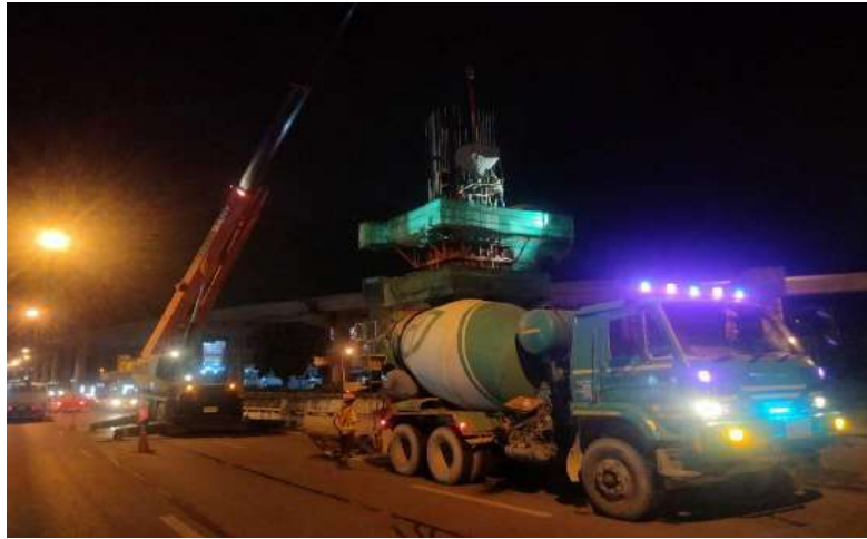
MLP03-02L งานเทคอนกรีต Column Type PT-44A Step 3
