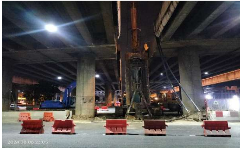
MLP03-09/2C งานเจาะ Barrette Pile 2.80x0.80 m.
