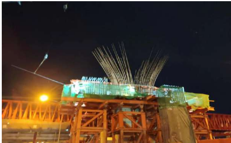
MLP01-05C งานผูกเหล็กเสริม Lower Crossbeam Type YT-1
