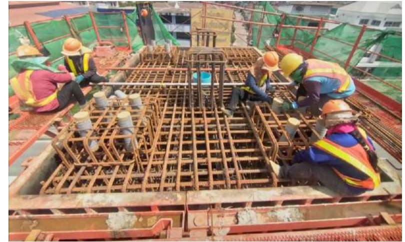
ROF2-02L งานผูกเหล็กเสริม Column Type S-4 Step 3-4
