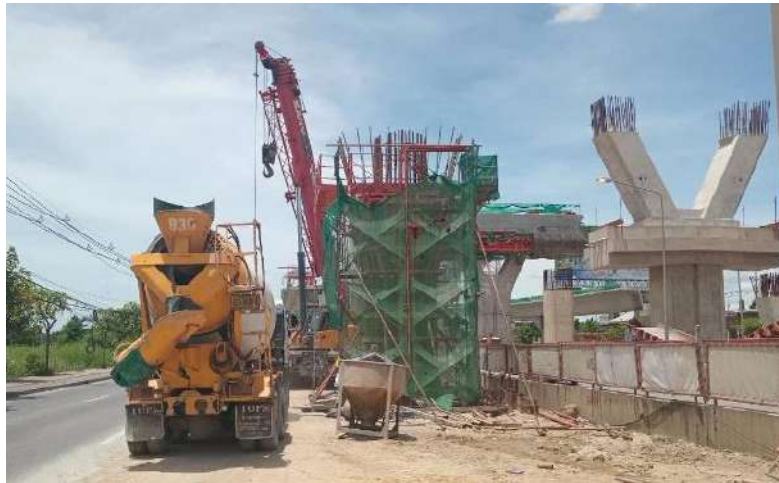
MLP01-12L งานเทคอนกรีต Column Head Type PTT-1
