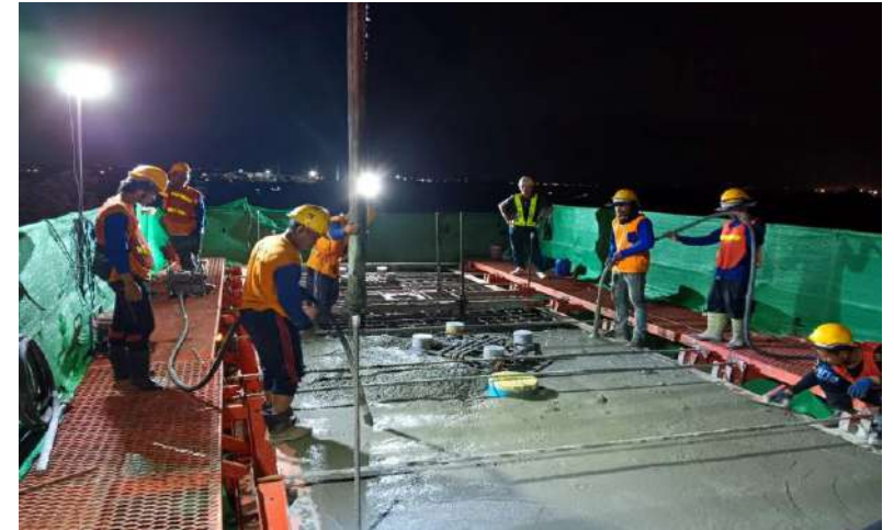
MLP02-09 งานเทคอนกรีต Crossbeam Type Y-1
