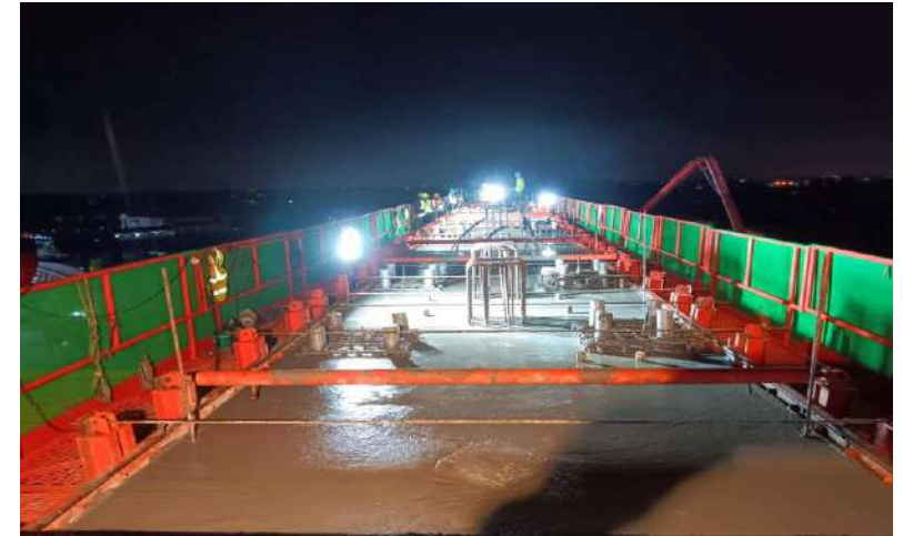
MLP01-24 งานเทคอนกรีต Crossbeam Type IYI-4
