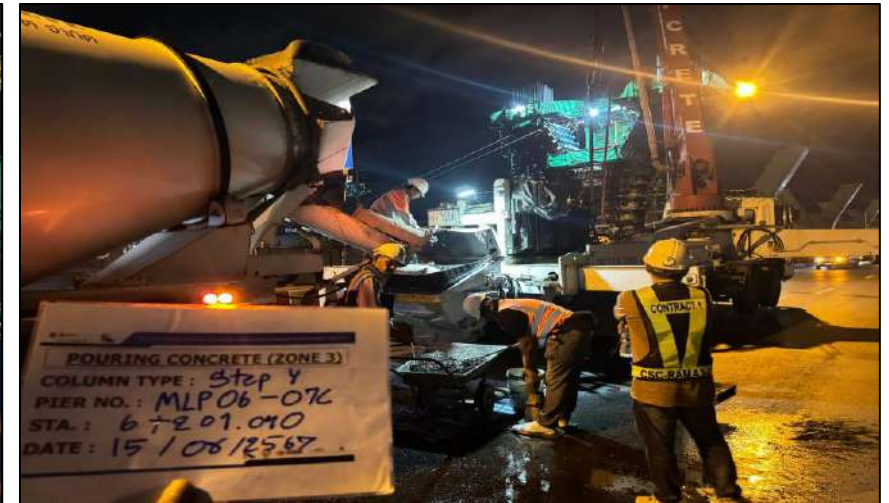
Pouring Concrete Column Pier Type Y-5 Step Y MLP06-07C
