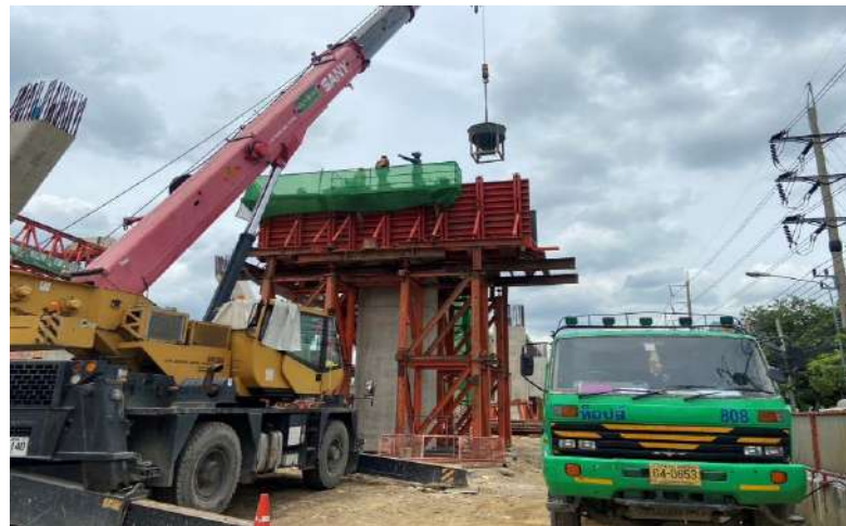
RON2-21R งานเทคอนกรีต Cross Beam Type T-4
