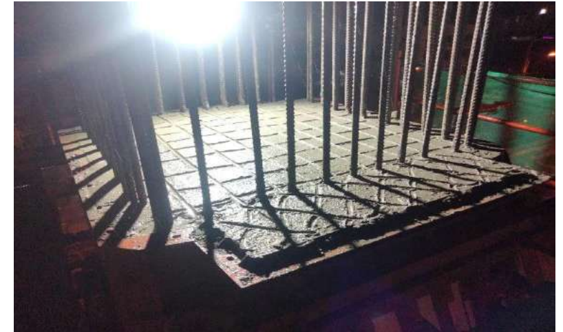
MLP03-25C งานเทคอนกรีต Column Type YI-2 Step Y
