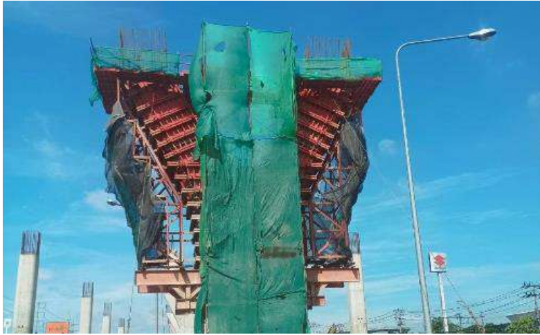
MLP03-25C งานผูกเหล็กเสริม Column Type YI-2 Step Y
