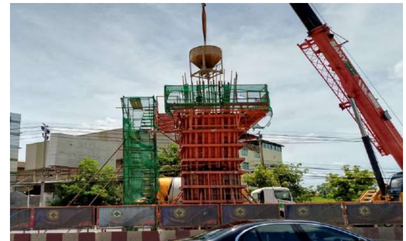
MLP01-12L งานเทคอนกรีต Column Head Type PTT-1
