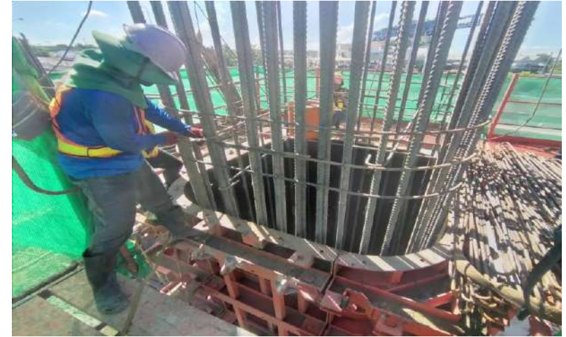
MLP03-02L งานติดตั้ง Formwork Column และผูกเหล็กเสริม Column Type PT-44A Step 1
