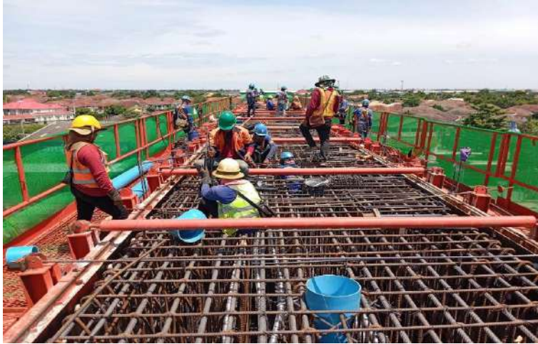
MLP01-24 งานผูกเหล็กเสริม Crossbeam Type IYI-4
