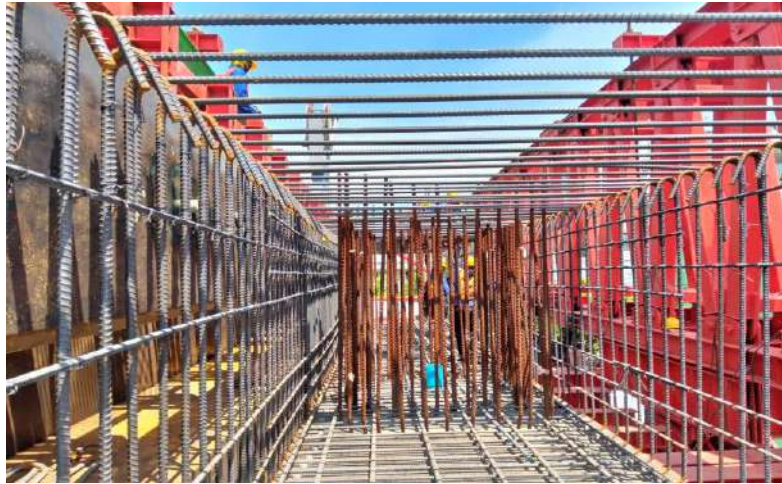
MLP01-04 งานผูกเหล็กเสริม Crossbeam Type PTT-1
