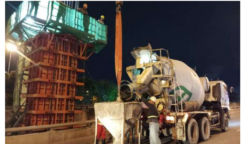
MLP03-02L งานเทคอนกรีต Column Type PT-44A Step 1-2
