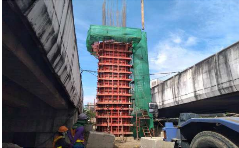
MLP03-02L งานติดตั้ง Formwork Column และผูกเหล็กเสริม Column Type PT-44A Step 1
