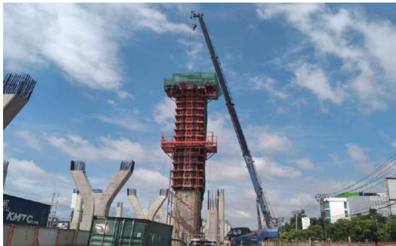
MLP04-02L งานผูกเหล็กเสริม Column Type IYI-4 Step 2
