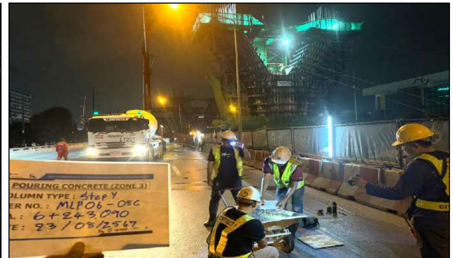
Pouring Concrete Column Pier Type Y-5 Step Y MLP06-08C
