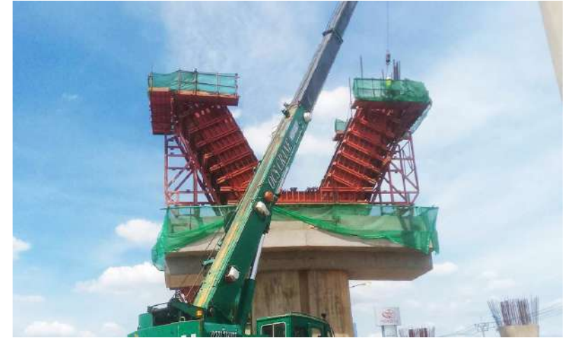
MLP01-07C งานผูกเหล็กเสริม Column Type YT-1 Step Y
