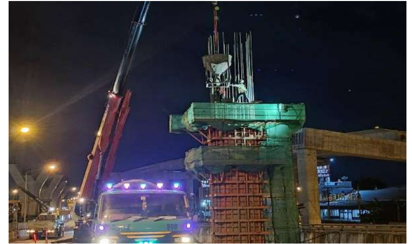
MLP03-02L งานเทคอนกรีต Column Type PT-44A Step 3
