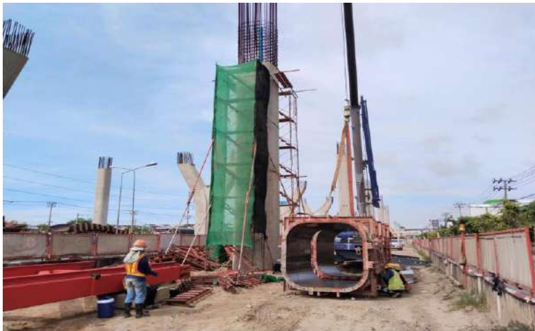
MLP04-04L งานติดตั้ง Formwork Column Type IYI-4 Step 3
