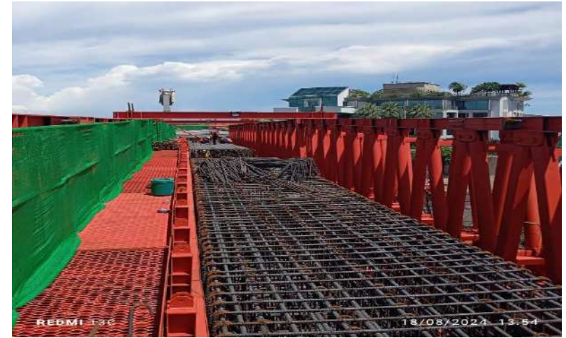
MLP01-04 งานผูกเหล็กเสริม Crossbeam Type PTT-1
