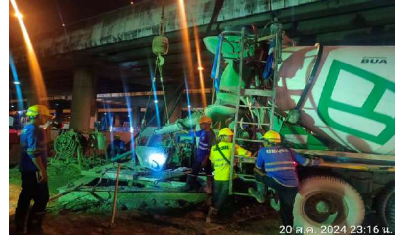
MLP03-07/1L งานเจาะ Bored Pile 1.80 m.
