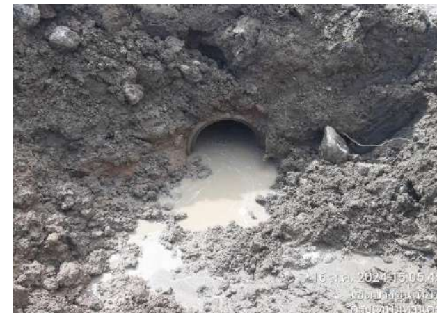
ดำเนินการจัดทำร่องระบายน้ำและเปิดท่อระบายน้ำ
