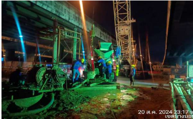
MLP03-07/1L งานเจาะ Bored Pile 1.80 m.
