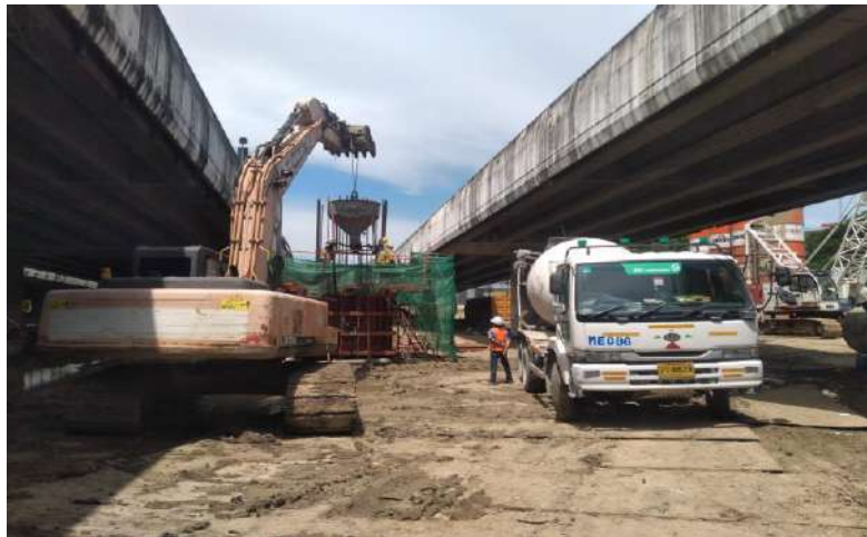
MLP03-04L เทคอนกรีต Column Type PT-44A Step 1
