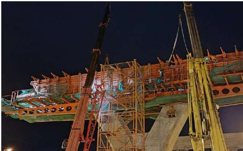
MLP02-07 งานติดตั้ง Formwork Side For Crossbeam Type Y-1
