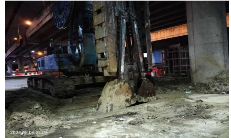
MLP03-09/2C งานเจาะ Barrette Pile 2.80x0.80 m.
