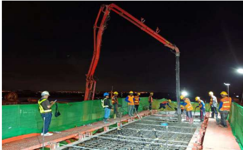
MLP02-09 งานเทคอนกรีต Crossbeam Type Y-1
