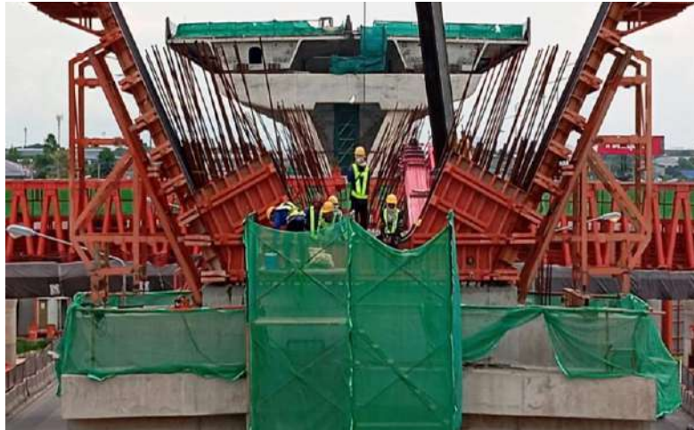
MLP01-07C งานผูกเหล็กเสริม Column Type YT-1 Step Y
