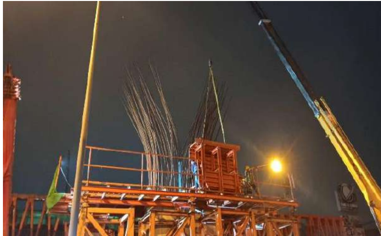
MLP01-03C งานติดตั้ง Formwork Lower Crossbeam Type YT-1
