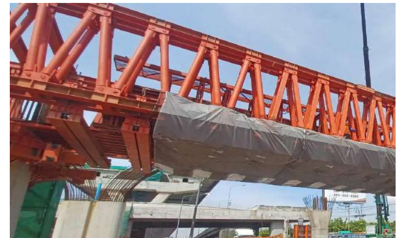
MLP01-04 งานติดตั้ง Formwork Crossbeam Type PTT-1
