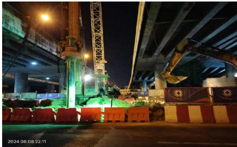
MLP03-07/2L งานเจาะ Bored Pile 1.80 m.
