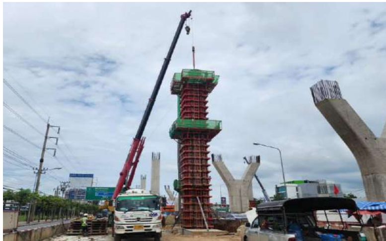
MLP04-02R เทคอนกรีต Column Type IYI-4 Step 2
