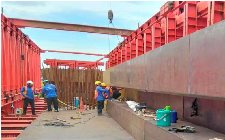
MLP01-04 งานติดตั้ง Formwork Crossbeam Type PTT-1
