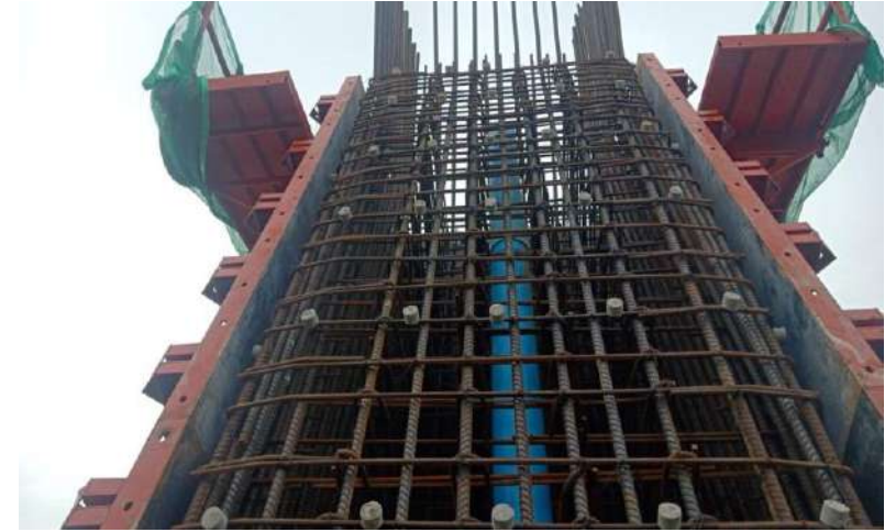
MLP03-25C งานผูกเหล็กเสริม Column Type YI-2 Step Y
