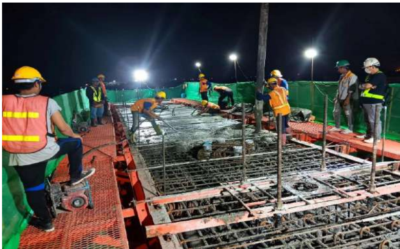
MLP02-10C งานเทคอนกรีต Crossbeam Type Y-1
