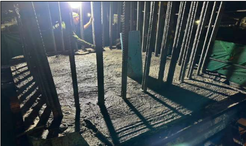
Pouring Concrete Column Pier Type Y-5 Step Y MLP06-07C
