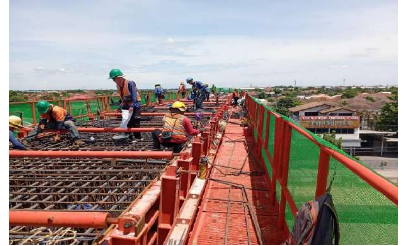
MLP01-24 งานผูกเหล็กเสริม Crossbeam Type IYI-4
