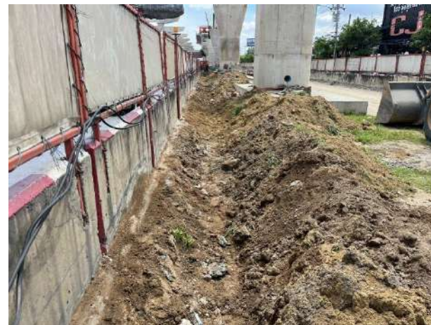
ดำเนินการจัดทำร่องระบายน้ำและเปิดท่อระบายน้ำ
