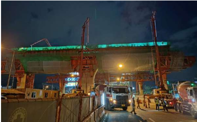
MLP01-24 งานเทคอนกรีต Crossbeam Type IYI-4
