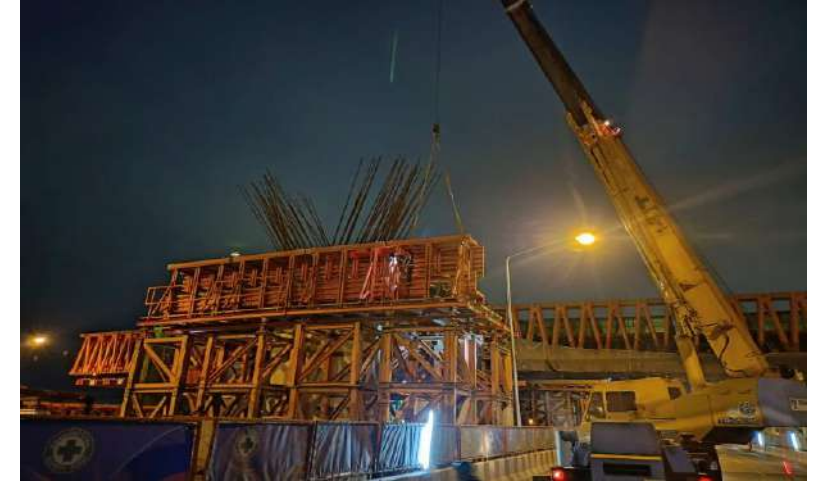
MLP01-03C งานติดตั้ง Formwork Lower Crossbeam Type YT-1
