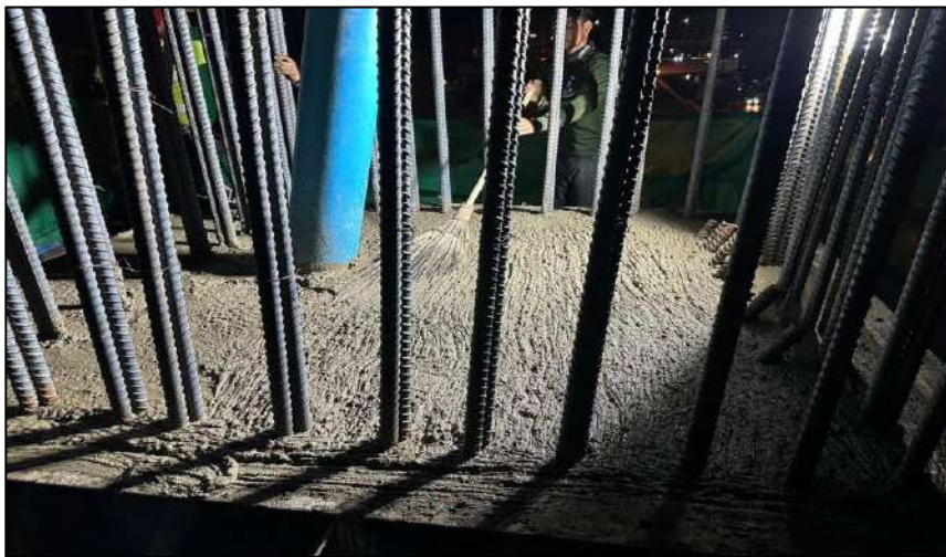
Pouring Concrete Column Pier Type Y-5 Step Y MLP06-08C
