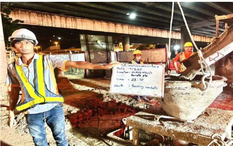
MLP03-08/1C งานเทศคอนกรีต Barrette Pile 1.80 m.
