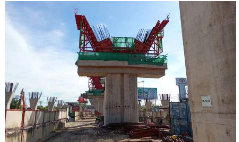
MLP01-09C งานติดตั้ง Formwork Column Type YT-1 Step Y
