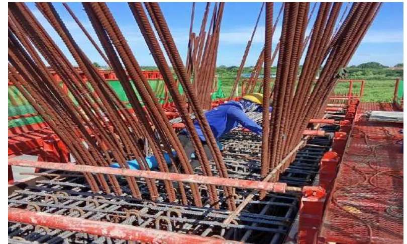
MLP01-05C งานผูกเหล็กเสริม Lower Crossbeam Type YT-1
