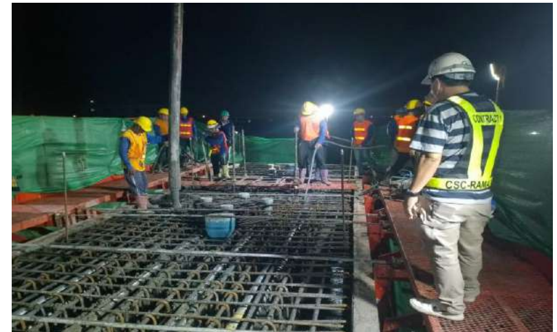
MLP04-13 งานเทคอนกรีต Crossbeam Type Y-1
