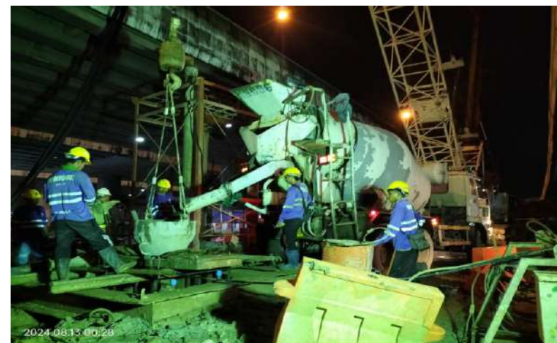
MLP03-07/2L งานเทคอนกรีต Bored Pile 1.80 m.
