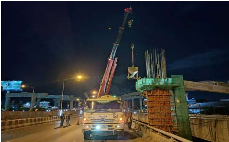
MLP03-02L งานเทคอนกรีต Column Type PT-44A Step 1-2
