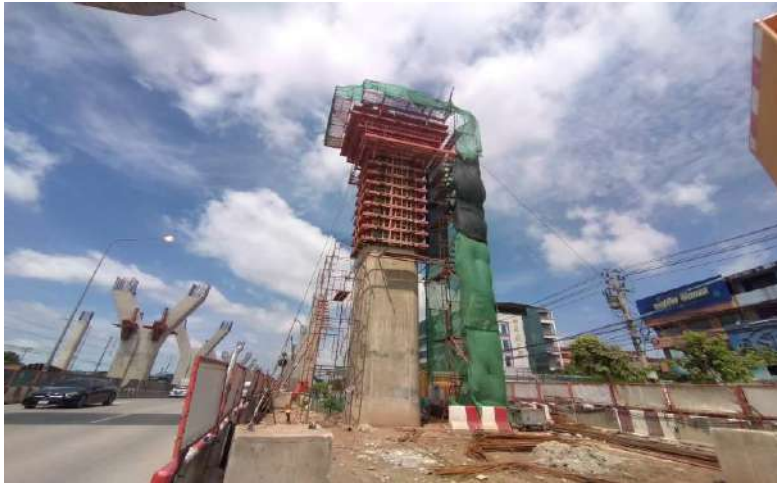
ROF2-02L งานผูกเหล็กเสริม Column Type S-4 Step 3-4
