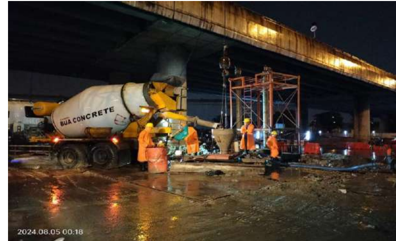
MLP03-08/1L เทศคอนกรีต Bored Pile 1.80 m.
