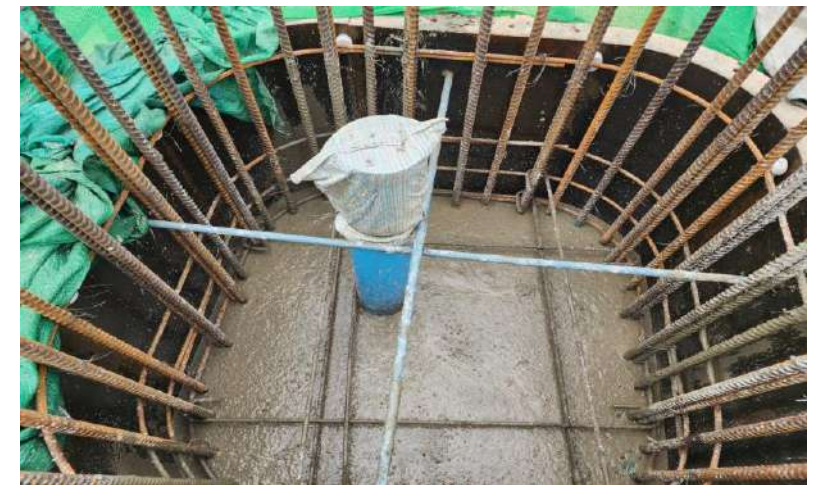
MLP04-02R เทคอนกรีต Column Type IYI-4 Step 2
