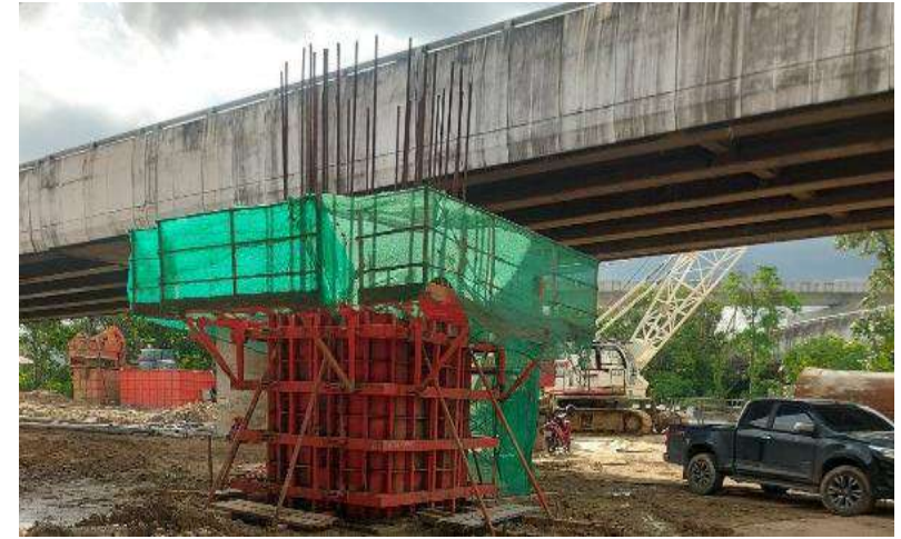
MLP03-04L งานติดตั้ง Formwork Column และผูกเหล็กเสริม Column Type PT-44A Step 1
