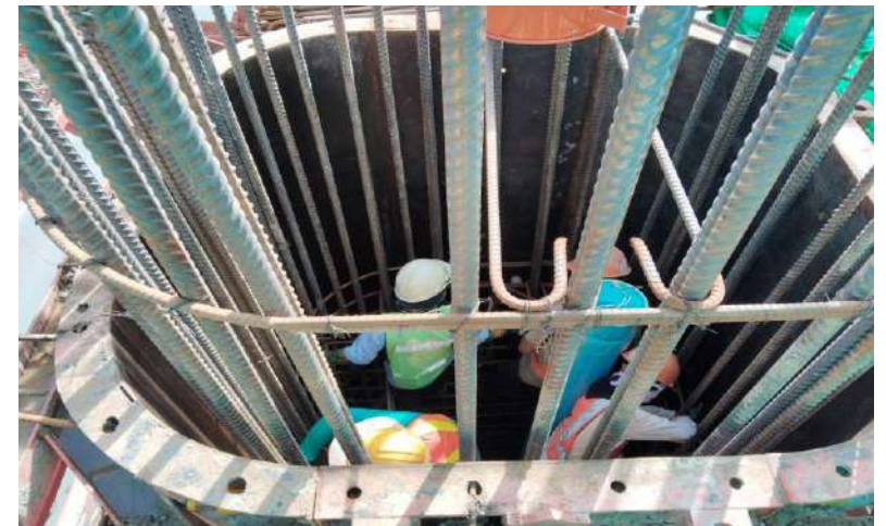
MLP04-02L งานผูกเหล็กเสริม Column Type IYI-4 Step 2
