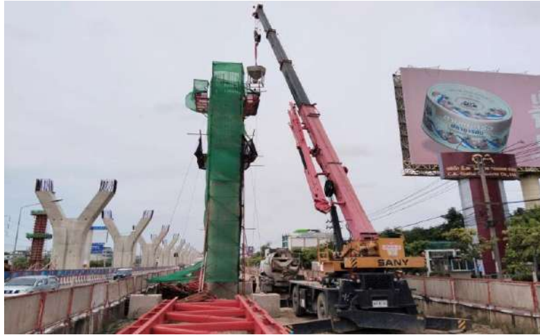
MLP04-04L เทศอนกรีต Column Type IYI-4 Step 3
