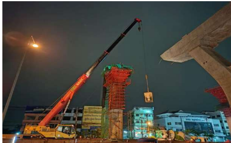
ROF2-02L เทศอนกรีต Column Head Type S-4
