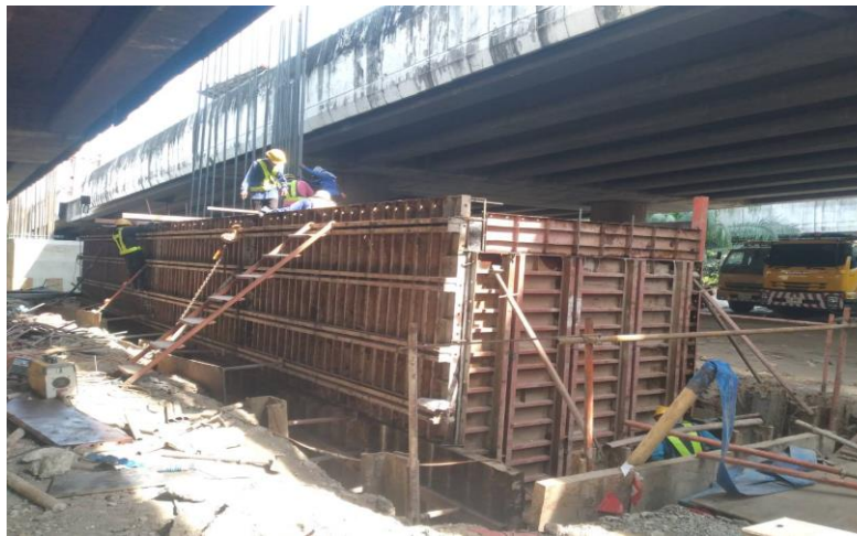
MLP03-13C งานติดตั้งตรวจสอบ Footing
