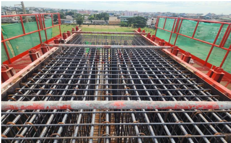
MLP03-27 งานผูกเหล็กเสริม Crossbeam Type YI-2
