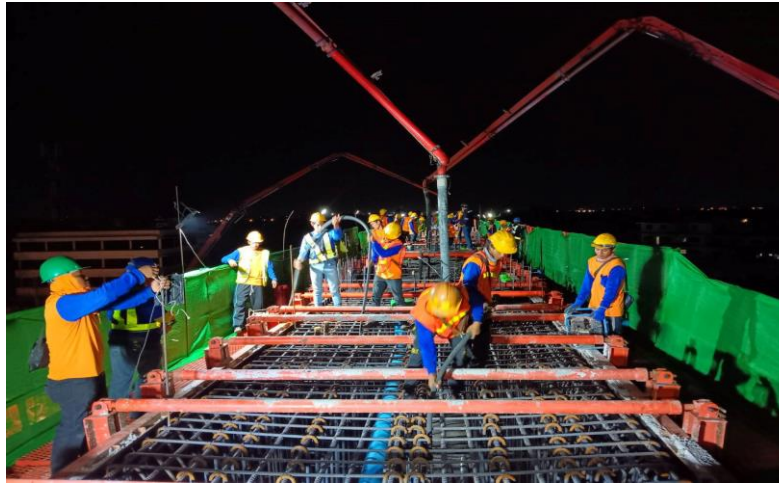
MLP02-13 งานเทคอนกรีต Crossbeam Type IYI-2
