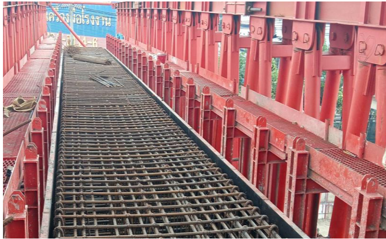
MLP01-05 งานผูกเหล็กเสริม Crossbeam Type YT-1
