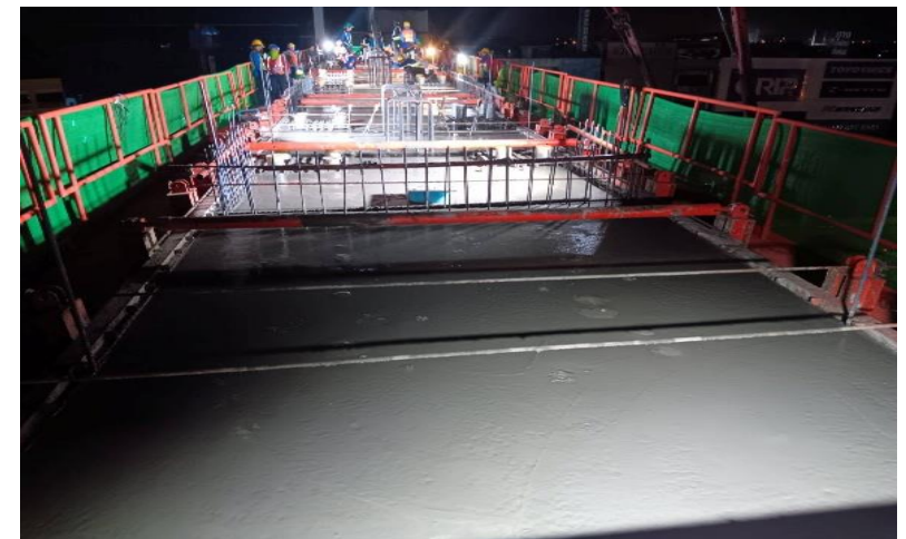
MLP01-27 งานเทคอนกรีต Crossbeam Type IYI-4
