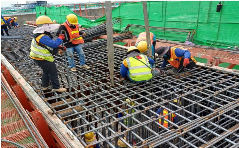
MLP02-26 งานผูกเหล็กเสริม Crossbeam Type Y-3
