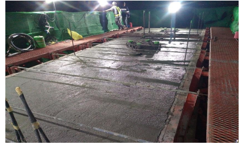
MLP01-07 งานเทคอนกรีต Crossbeam Type YT-1
