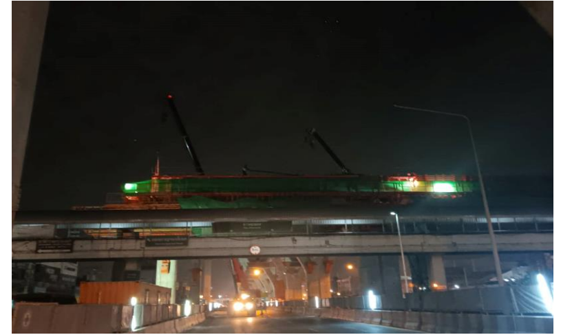
MLP01-27 งานติดตั้ง Formwork Crossbeam Type IYI-4
