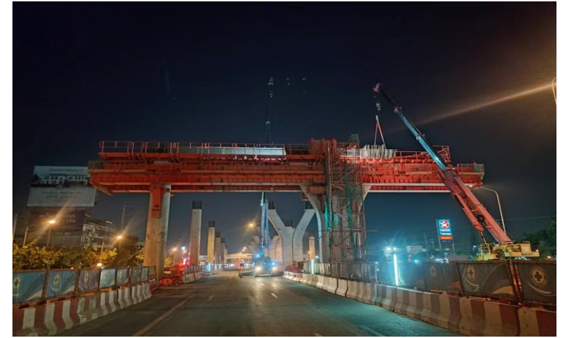
MLP03-27 งานติดตั้ง Formwork Crossbeam Type YI-2
