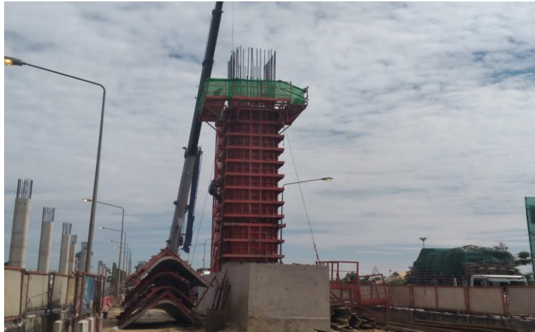
MLP02-27C งานผูกเหล็กเสริม Column Type PT-44A Step 1-2
