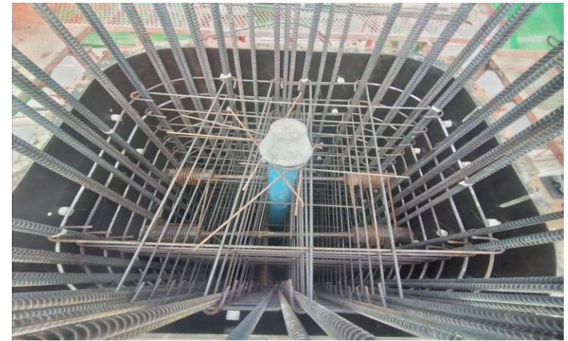
MLP03-07L งานผูกเหล็กเสริม Column Head Type PT-44 (Modified)
