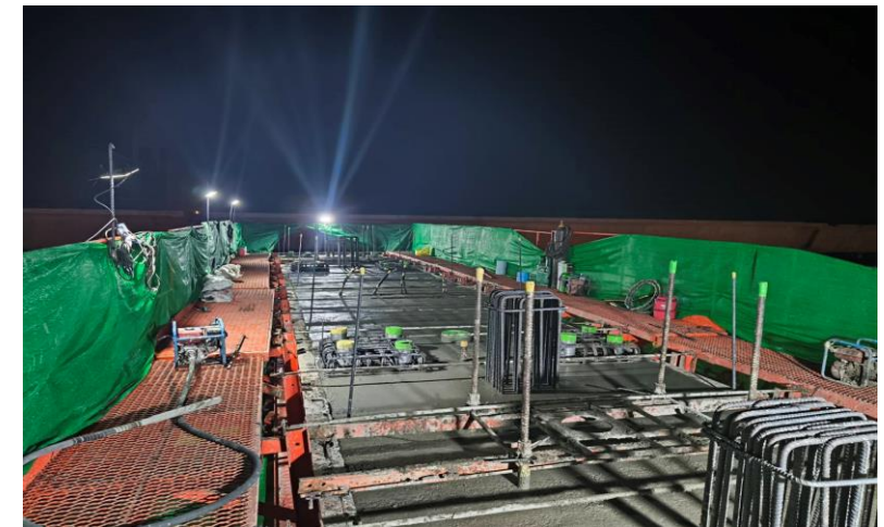
MLP02-25 งานเทคอนกรีต Crossbeam Type Y-1
