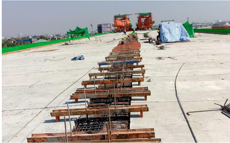
MLP02-02 to MLP02-05 งานผูกเหล็ก Connecting Slab
