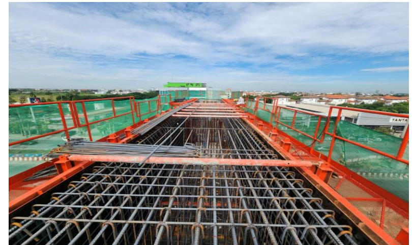
MLP03-27 งานผูกเหล็กเสริม Crossbeam Type YI-2
