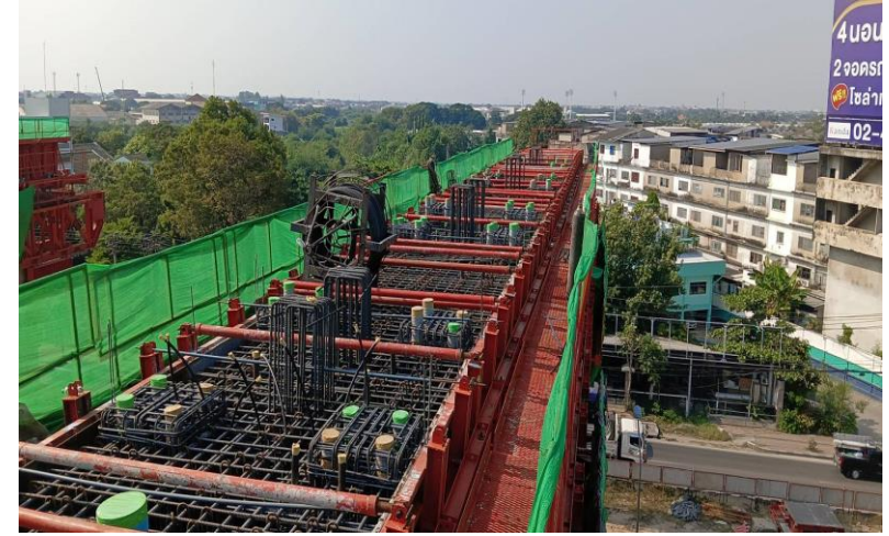
MLP02-14 งานผูกเหล็กเสริม Crossbeam Type YI-1
