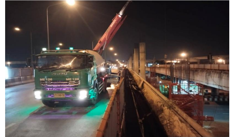
MLP03-08L งานเทคอนกรีต Column Type PT-44 (Modified) Step 1-2
