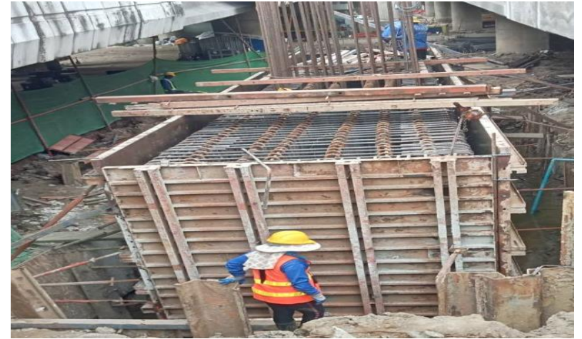
MLP03-14C งานผูกเหล็กเสริม Footing
