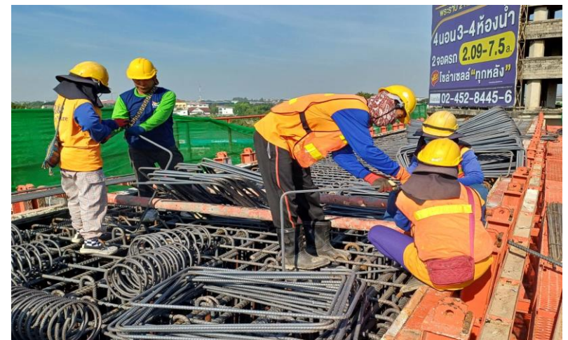
MLP02-15 งานผูกเหล็กเสริม Crossbeam Type YI-1
