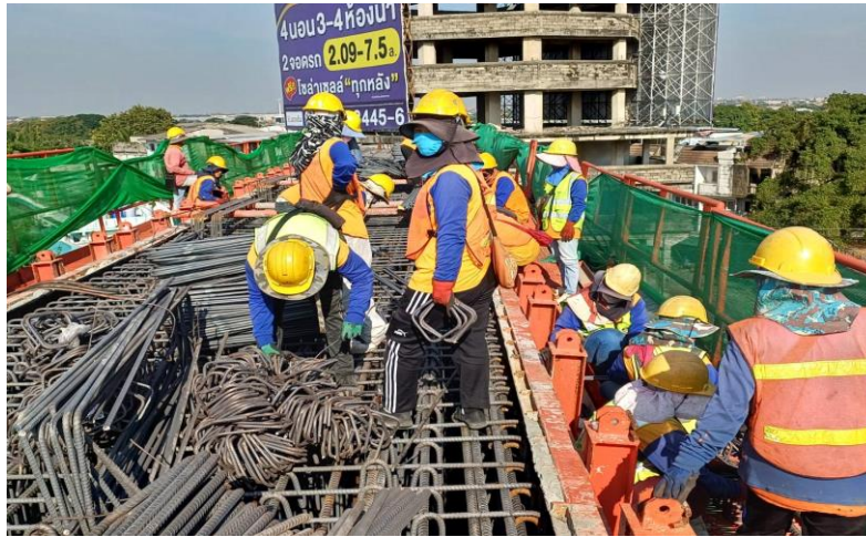
MLP02-15 งานผูกเหล็กเสริม Crossbeam Type YI-1
