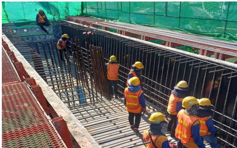
MLP01-07 งานผูกเหล็กเสริม Crossbeam Type YT-1
