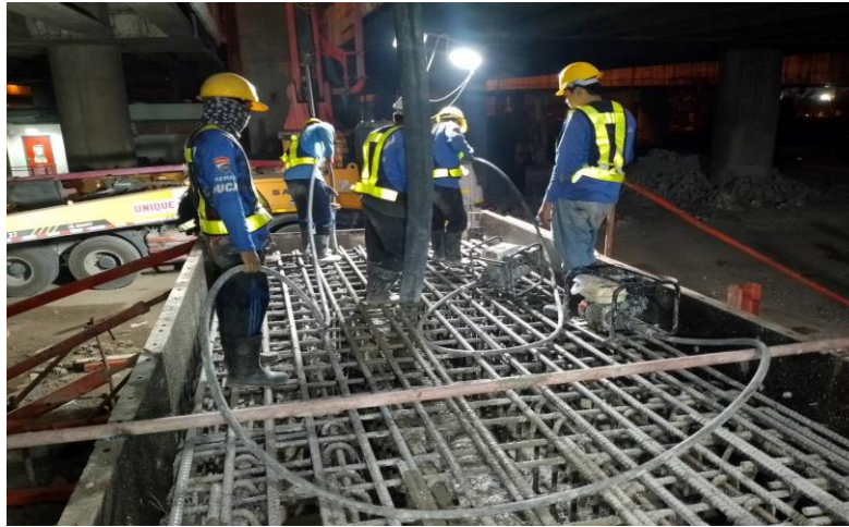
MLP03-13C งานเทคอนกรีต Footing
