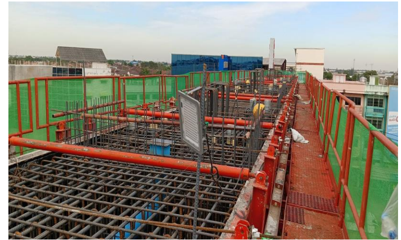
MLP01-27 งานผูกเหล็กเสริม Crossbeam Type IYI-4
