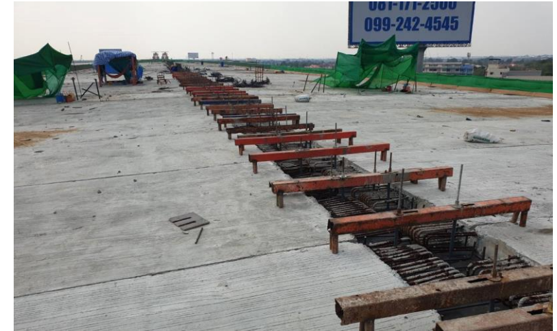
MLP02-02 to MLP02-05 งานผูกเหล็ก Connecting Slab
