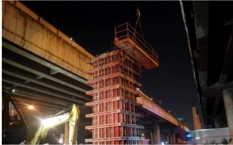
MLP03-07L งานติดตั้ง Formwork Column Type PT-44 (Modified) Step 1-2
