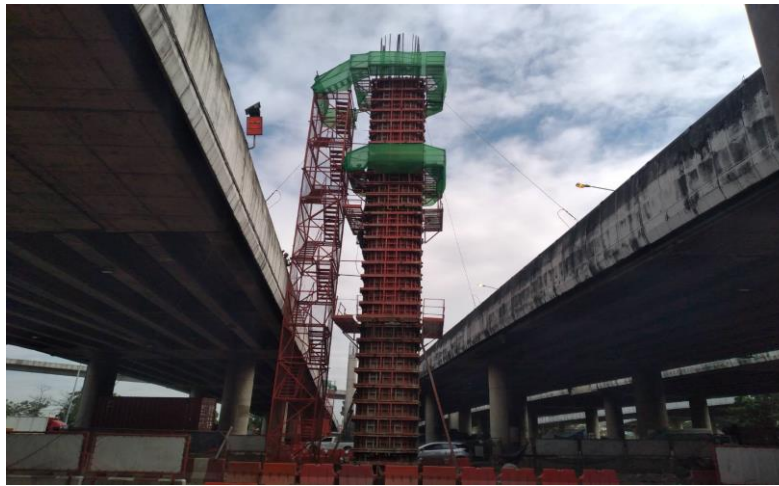
MLP03-07L งานผูกเหล็กเสริม Column Head Type PT-44 (Modified)
