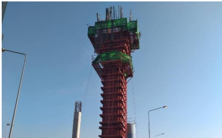
MLP02-27C งานผูกเหล็กเสริม Column Head Type PT-44A
