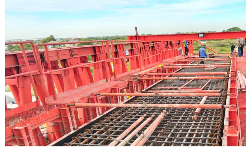
MLP01-05 งานผูกเหล็กเสริม Crossbeam Type YT-1
