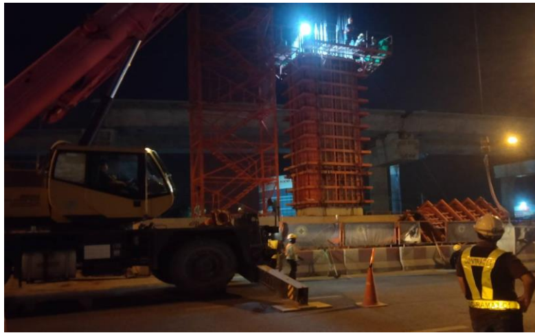
MLP02-27C งานเทคอนกรีต Column Type PT-44A Step 1-2
