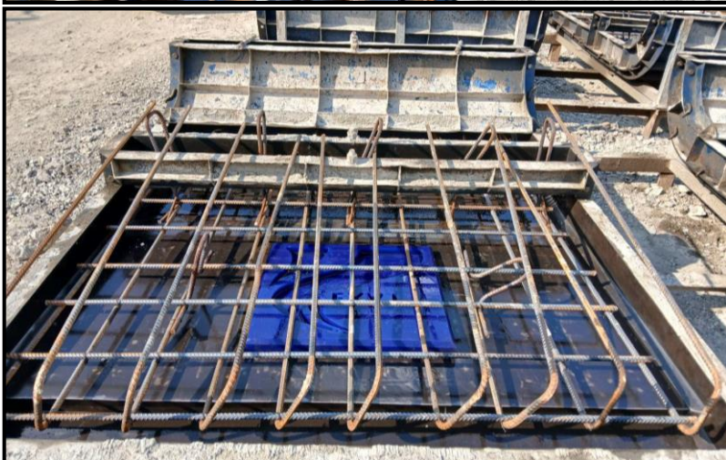
งานหล่อ Precast Parapet Zone 3
