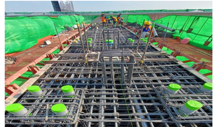
MLP02-25 งานผูกเหล็กเสริม Crossbeam Type Y-1
