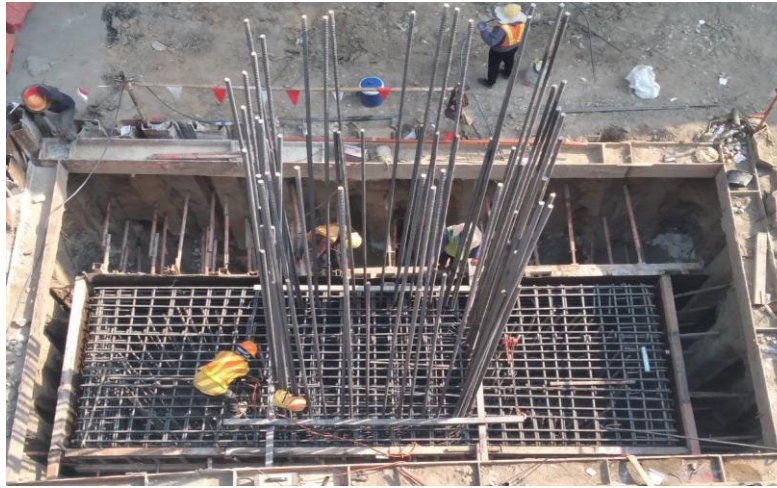
MLP03-09L งานติดตั้ง Formwork Footing
