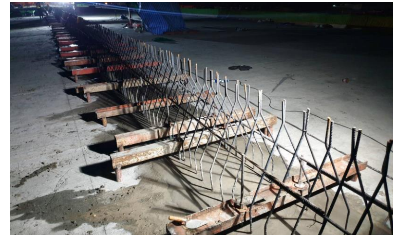
MLP02-02 to MLP02-05 งานเทคอนกรีต Connecting Slab
