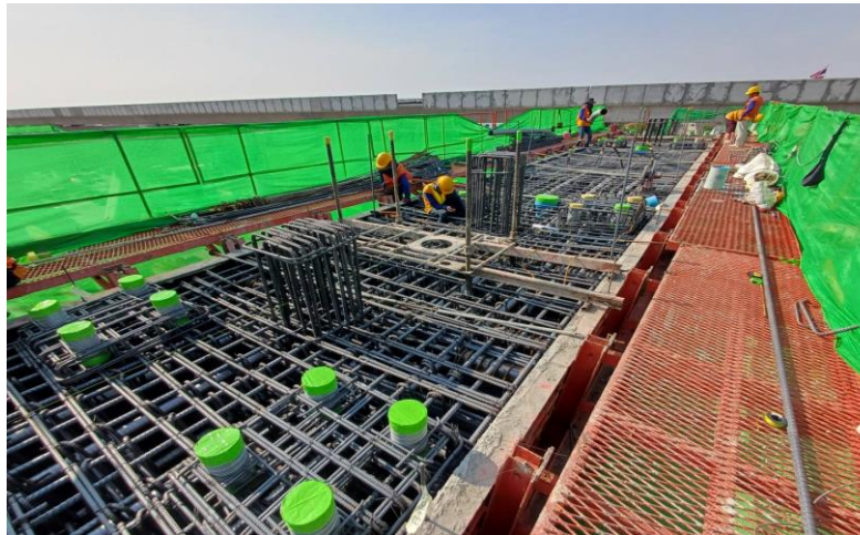
MLP02-25 งานผูกเหล็กเสริม Crossbeam Type Y-1
