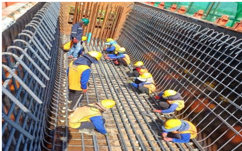
MLP02-13 งานผูกเหล็กเสริม Crossbeam Type IYI-2
