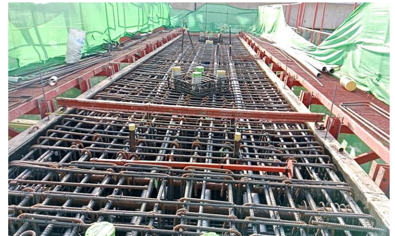
MLP01-07 งานผูกเหล็กเสริม Crossbeam Type YT-1
