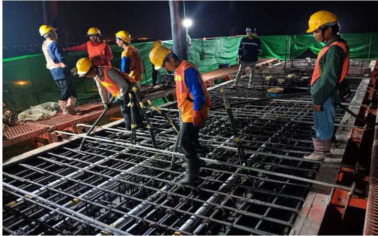
MLP01-05 งานเทคอนกรีต Crossbeam Type YT-1
