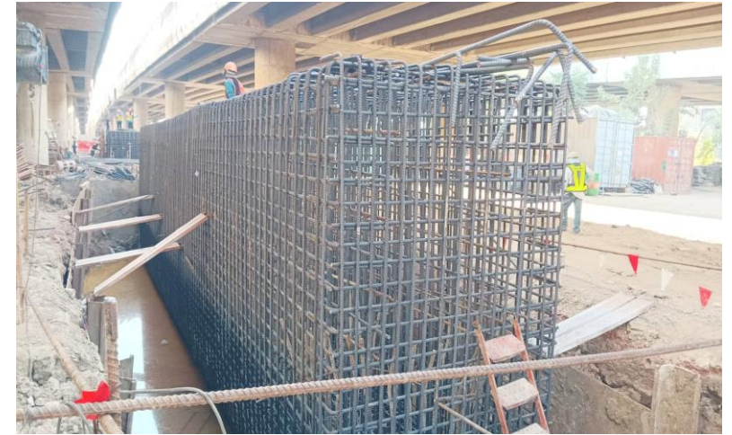
MLP03-04C งานผูกเหล็กเสริม Footing
