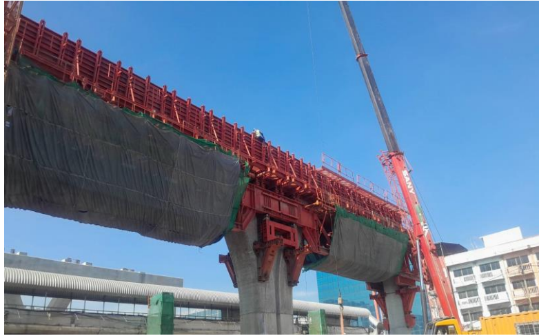
MLP01-27 งานติดตั้ง Formwork Crossbeam Type IYI-4
