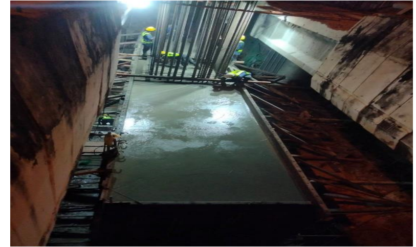
MLP03-14C งานเทคอนกรีต Footing
