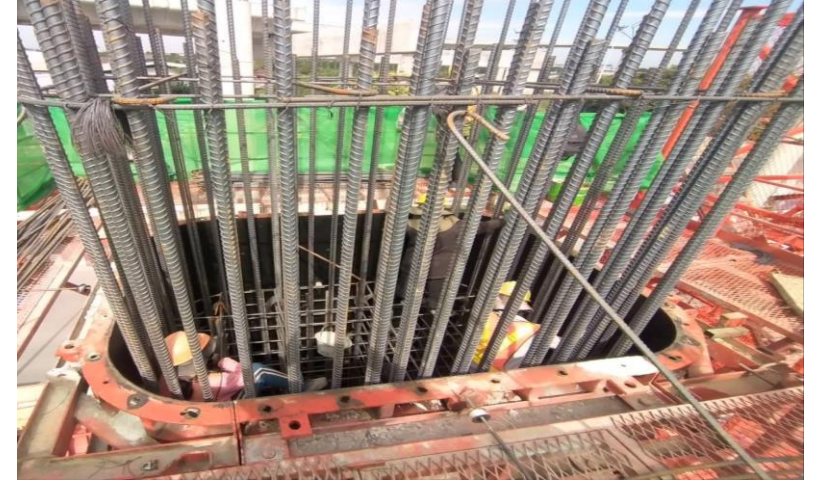
MLP02-27C งานผูกเหล็กเสริม Column Type PT-44A Step 1-2
