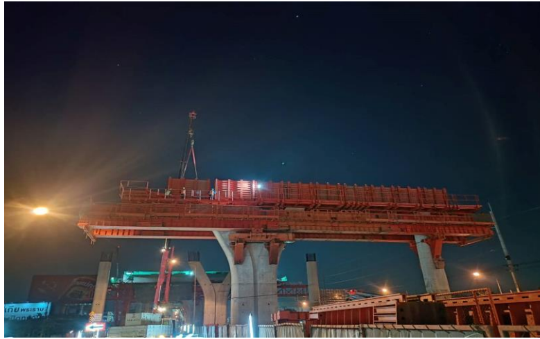
MLP03-27 งานติดตั้ง Formwork Crossbeam Type YI-2
