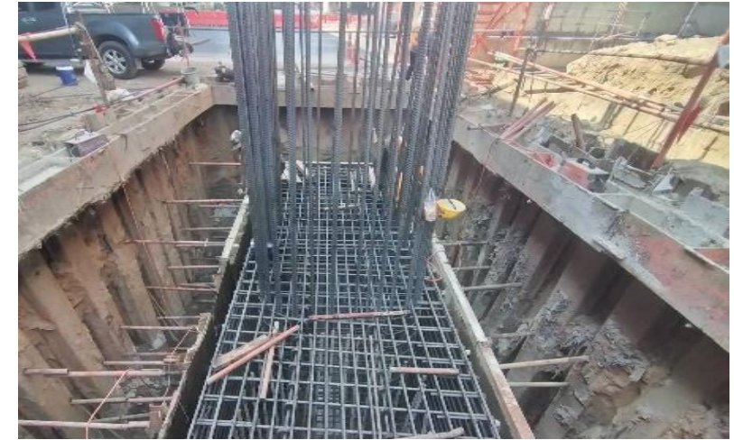
MLP03-09L งานติดตั้ง Formwork Footing
