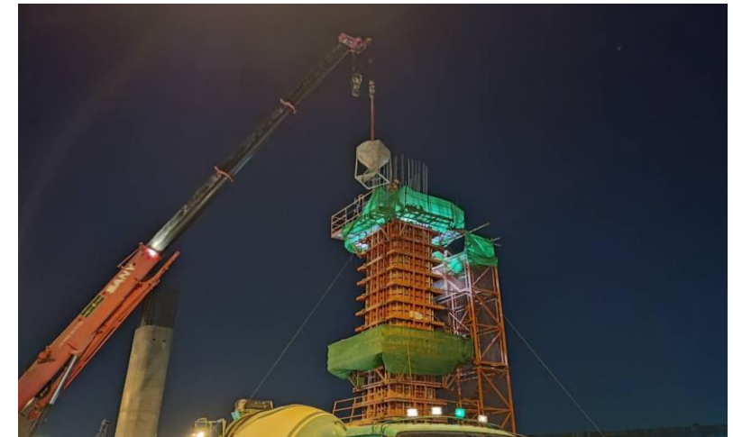
MLP03-07L งานเทคอนกรีต Column Head Type PT-44 (Modified)
