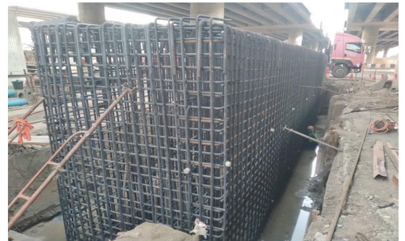
MLP03-05C งานผูกเหล็กเสริม Footing
