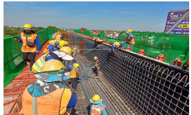
MLP02-13 งานผูกเหล็กเสริม Crossbeam Type IYI-2
