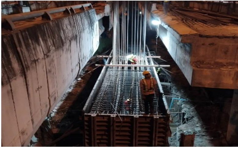
MLP03-14C งานผูกเหล็กเสริม Footing
