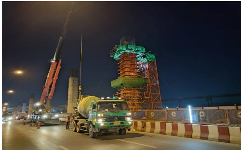
MLP03-07L งานเทคอนกรีต Column Head Type PT-44 (Modified)
