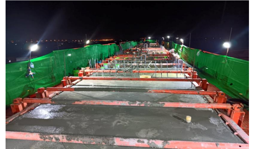
MLP02-13 งานเทคอนกรีต Crossbeam Type IYI-2
