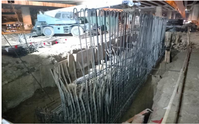
MLP03-04C งานผูกเหล็กเสริม Footing
