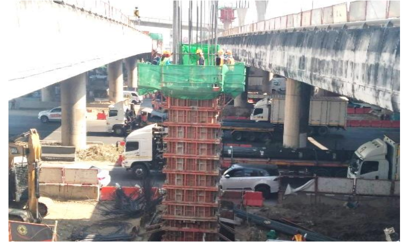
MLP03-07L งานติดตั้ง Formwork Column Type PT-44 (Modified) Step 1-2
