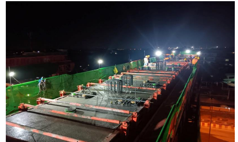
MLP02-14 งานเทคอนกรีต Crossbeam Type IYI-1
