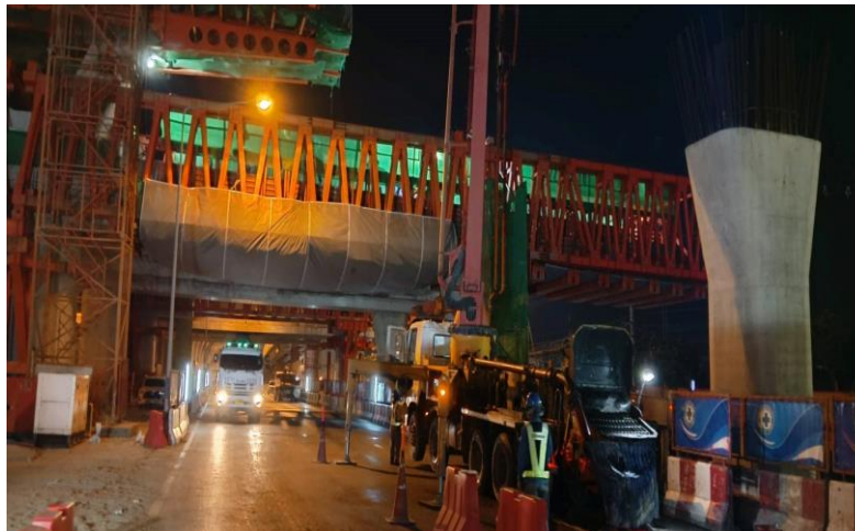
MLP01-05 งานเทคอนกรีต Lower Crossbeam Type YT-1
