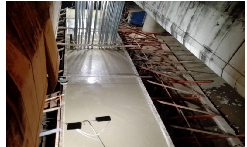
MLP03-13C งานเทคอนกรีต Footing
