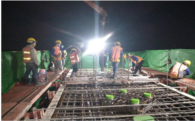
MLP01-07 งานเทคอนกรีต Crossbeam Type YT-1
