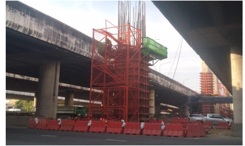
MLP03-08L งานผูกเหล็กเสริม Column Type PT-44 (Modified) Step 1-2
