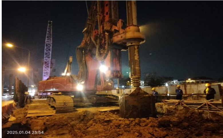
MLP03-15/1C งานเจาะ Bored Pile 1.80 m.
