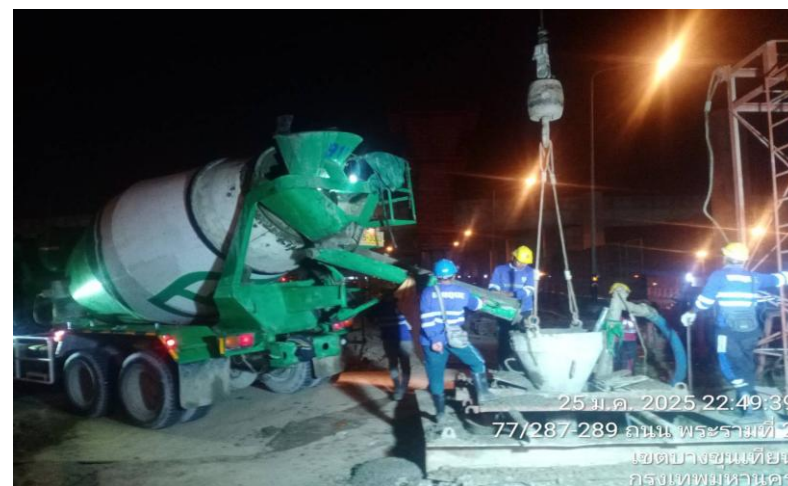
MLP03-15/4C งานเทคอนกรีต Bored Pile 1.80 m.
