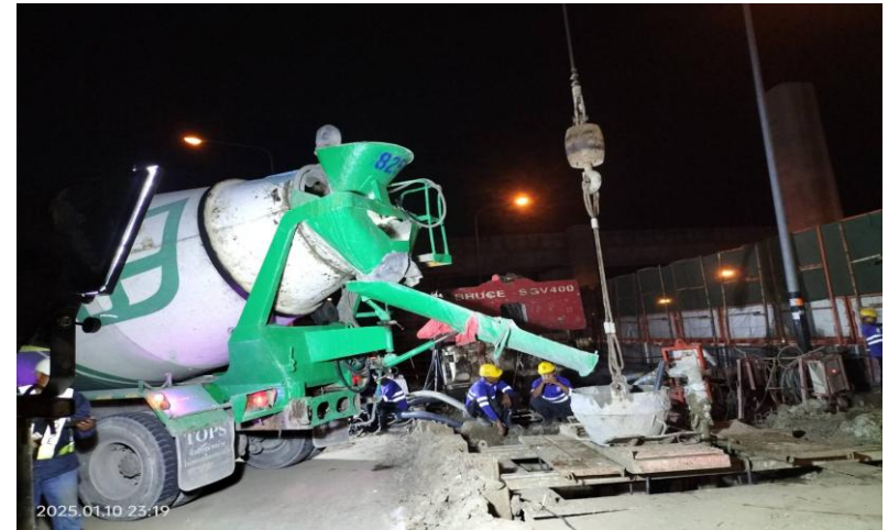
MLP03-15/1C งานเทคอนกรีต Bored Pile 1.80 m.
