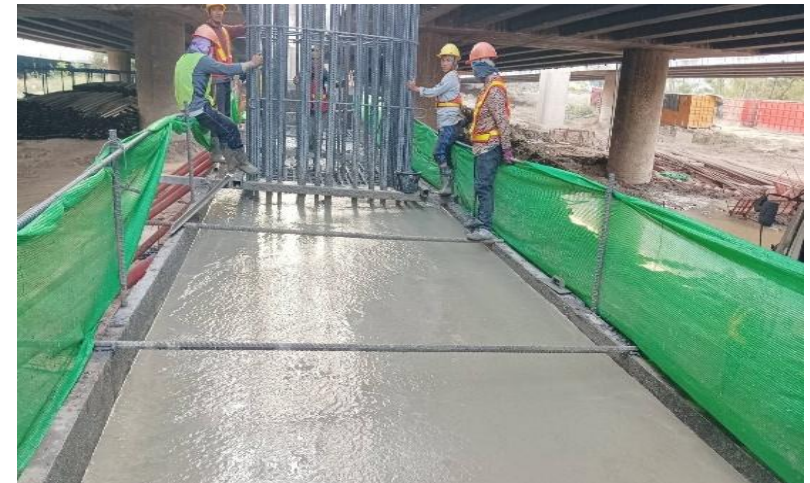
MLP03-04C งานเทคอนกรีต Footing
