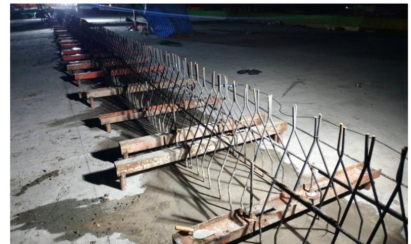
MLP02-02 to MLP02-08 งานเทคอนกรีต Connecting Slab
