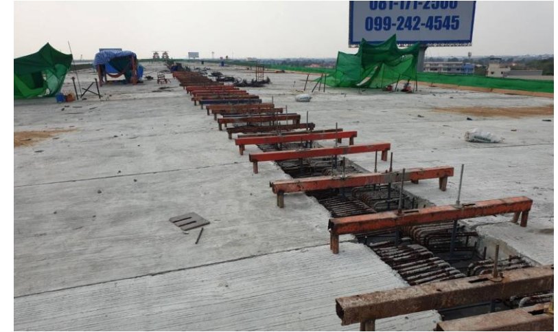
MLP02-02 to MLP02-08 งานผูกเหล็ก Connecting Slab
