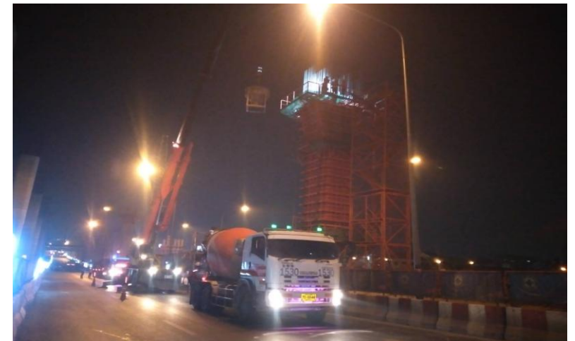
MLP03-14C เทคอนกรีต Column Head Type PT-44 (Modified)
