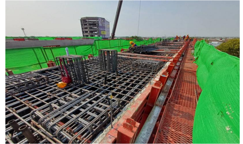
MLP02-17 งานผูกเหล็กเสริม Crossbeam Type IYI-1
