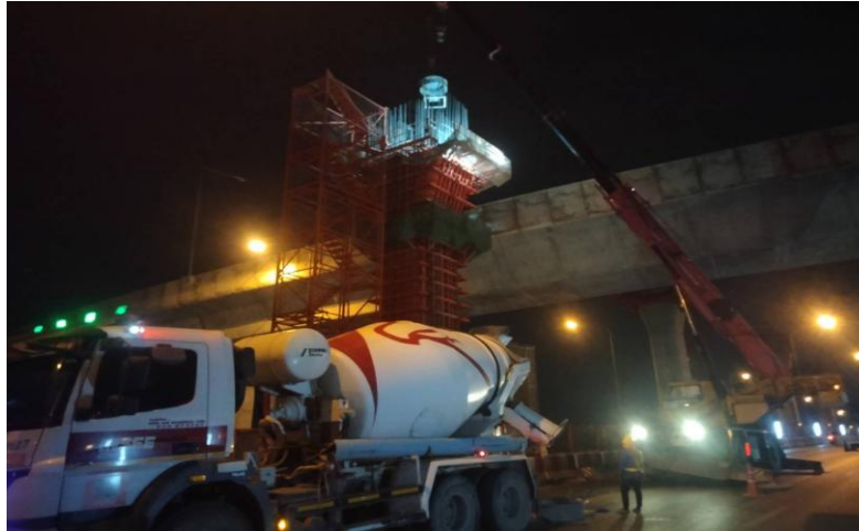
MLP03-13C งานเทคอนกรีต Column Head Type PT-44 (Modified)
