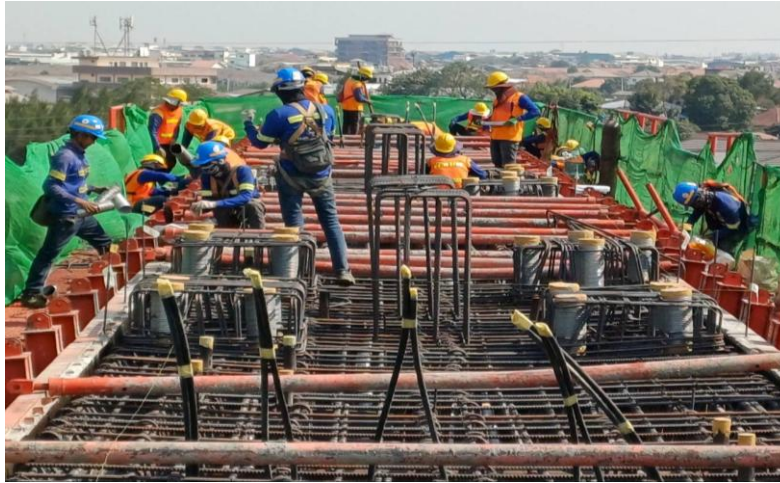
MLP02-17 งานผูกเหล็กเสริม Crossbeam Type IYI-1
