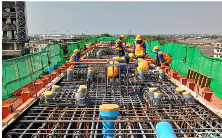
MLP02-16 งานผูกเหล็กเสริม Crossbeam Type IYI-1
