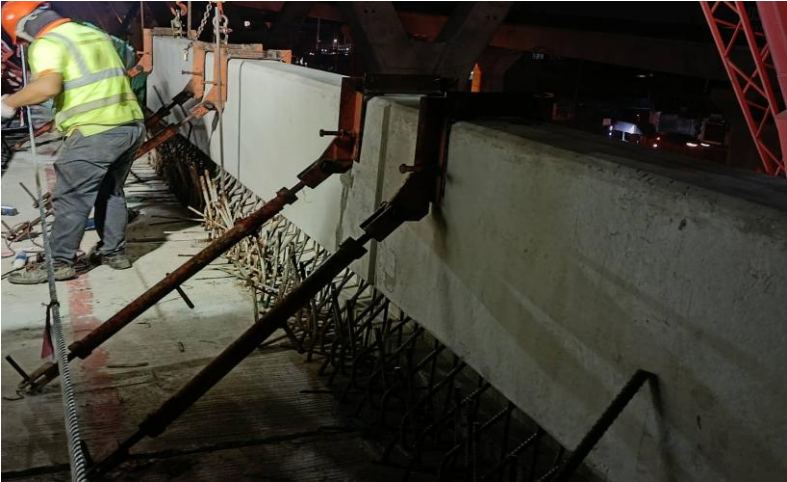
RON1-20 to RON1-21 งานติดตั้ง Parapet
