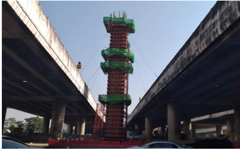
MLP03-08L งานติดตั้ง Formwork Column Head Type PT-44 (Modified)
