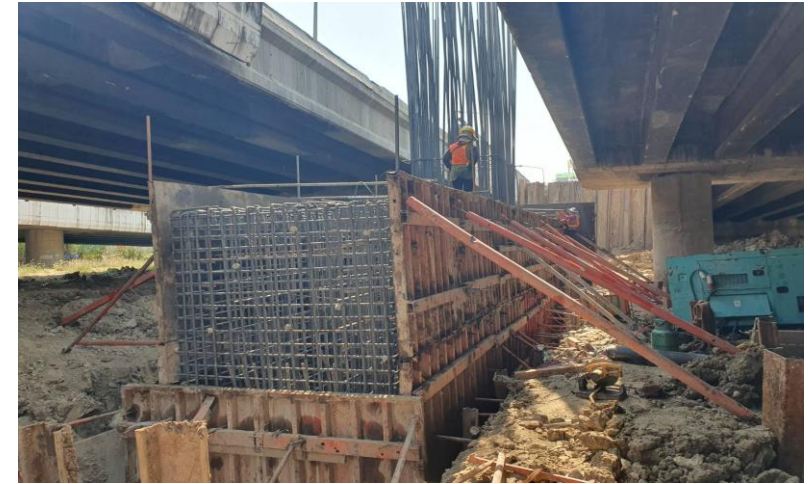
MLP03-03C งานติดตั้ง Formwork Footing
