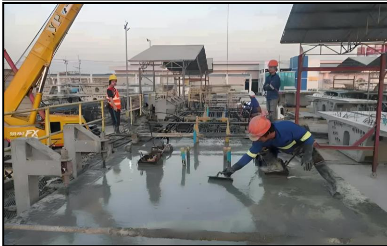
งานผลิตชิ้นงาน Box Segment ที่โรงหล่อ GEL
