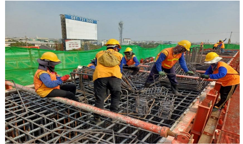
MLP02-16 งานผูกเหล็กเสริม Crossbeam Type IYI-1
