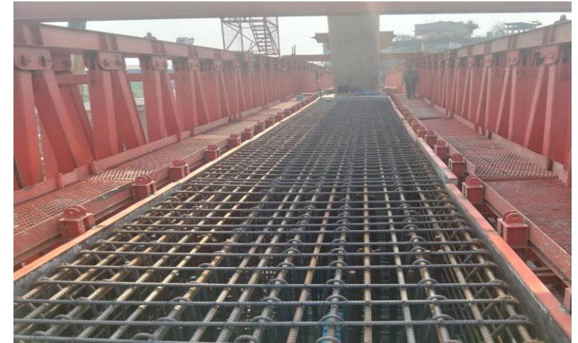
MLP01-03 งานผูกเหล็กเสริม Lower Crossbeam Type YT-1
