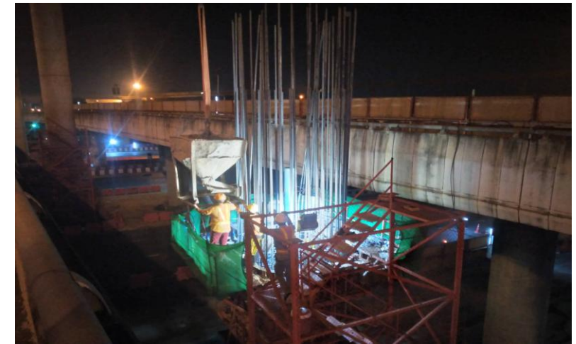
MLP03-09L งานเทคอนกรีต Column Type PT-44 (Modified) Step 1-2
