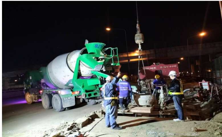
MLP03-15/1C งานเทคอนกรีต Bored Pile 1.80 m.
