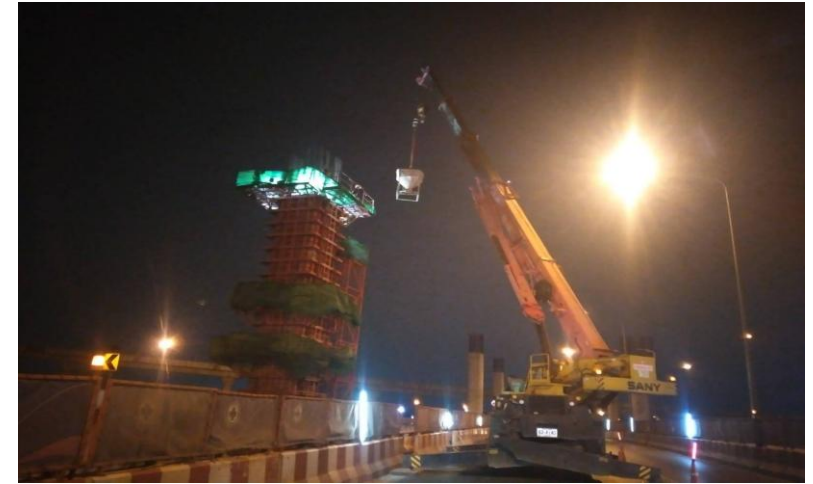
MLP03-08L งานเทคอนกรีต Column Head Type PT-44 (Modified)
