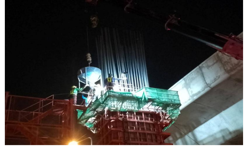
MLP03-13C เทคอนกรีต Column Type PT-44 (Modified) Step 3-4
