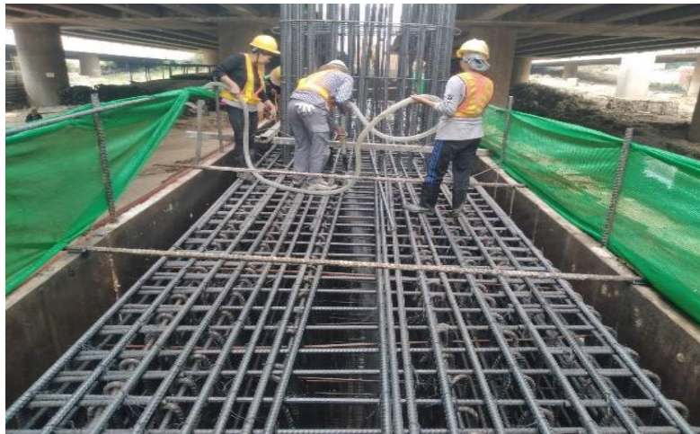
MLP03-04C งานเทคอนกรีต Footing
