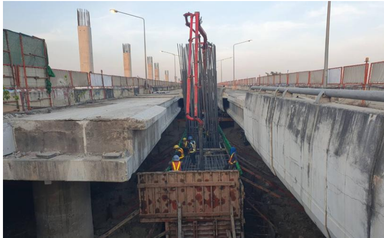
MLP03-03C งานเทคอนกรีต Footing
