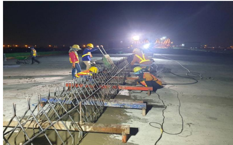
MLP02-02 to MLP02-08 งานเทคอนกรีต Connecting Slab
