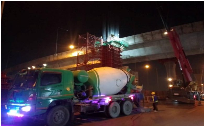
MLP03-13C เทคอนกรีต Column Type PT-44 (Modified) Step 3-4
