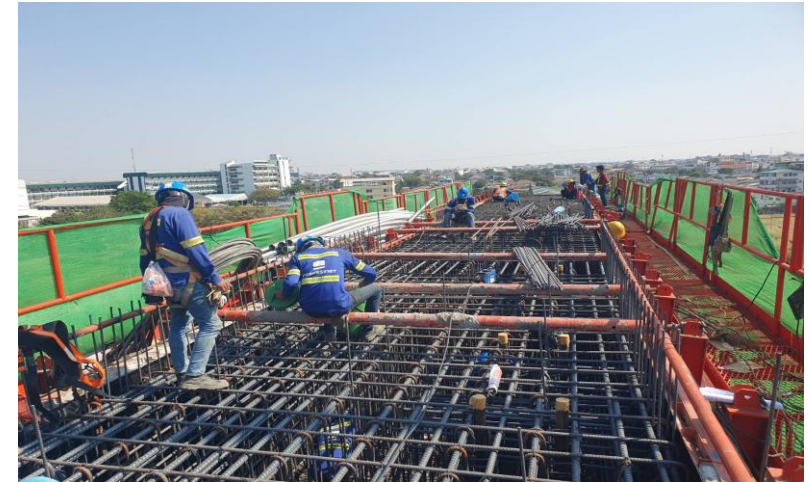
MLP04-04 งานผูกเหล็กเสริม Crossbeam Type IYI-4
