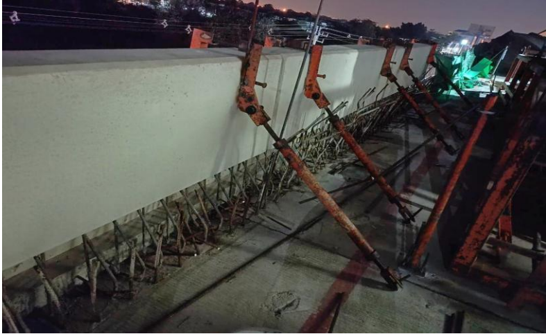
RON1-20 to RON1-21 งานติดตั้ง Parapet
