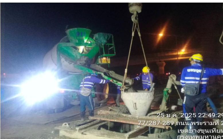
MLP03-15/4C งานเทคอนกรีต Bored Pile 1.80 m.
