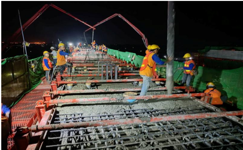
MLP02-16 งานเทคอนกรีต Crossbeam Type IYI-1
