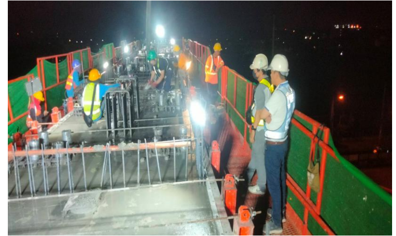
MLP04-04 งานเทคอนกรีต Crossbeam Type IYI-4
