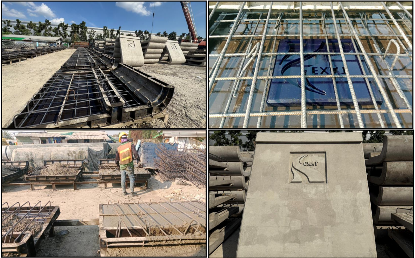
งานหล่อ Precast Parapet Zone 3
