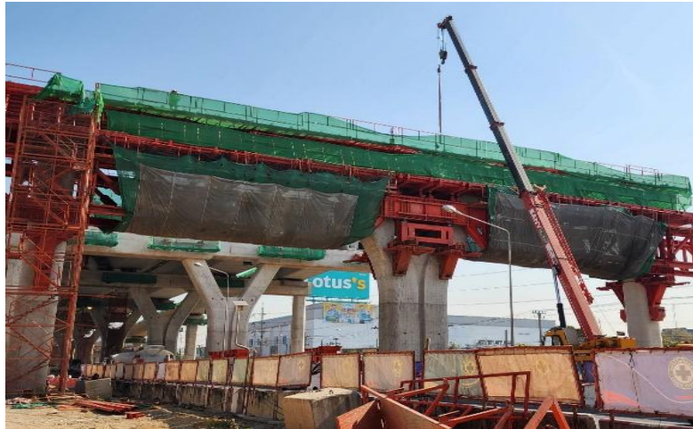
MLP04-04 งานผูกเหล็กเสริม Crossbeam Type IYI-4
