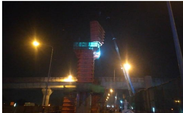
MLP03-14C งานติดตั้ง Formwork Column Head Type PT-44 (Modified)
