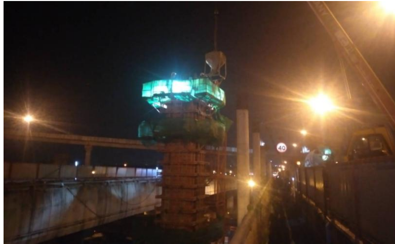
MLP03-09L งานเทคอนกรีต Column Type PT-44 (Modified) Step 3
