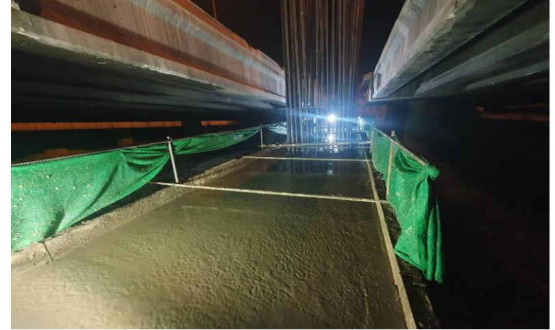
MLP03-03C งานเทคอนกรีต Footing
