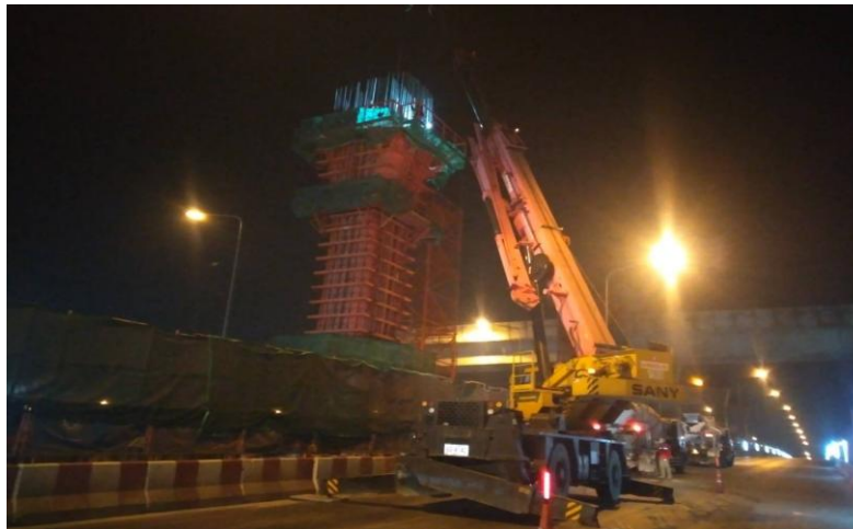
MLP03-14C เทคอนกรีต Column Head Type PT-44 (Modified)
