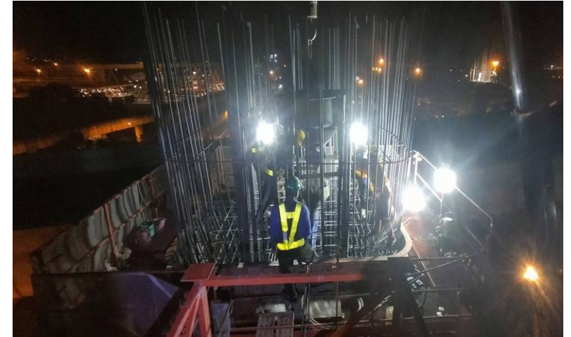
MLP03-13C งานเทคอนกรีต Column Head Type PT-44 (Modified)
