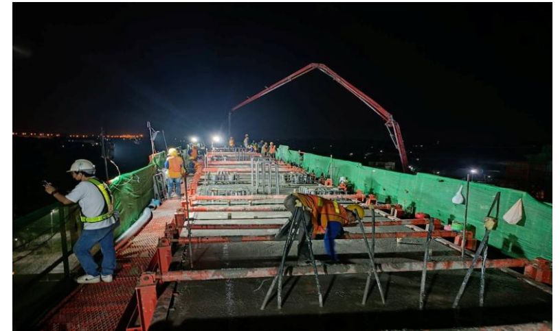
MLP02-16 งานเทคอนกรีต Crossbeam Type IYI-1
