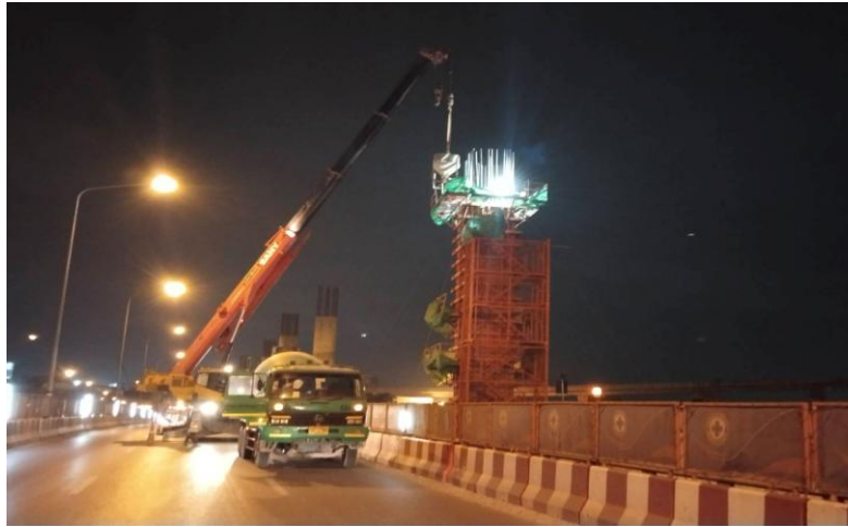
MLP03-08L งานเทคอนกรีต Column Head Type PT-44 (Modified)
