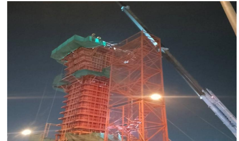
MLP03-14C งานติดตั้ง Formwork Column Head Type PT-44 (Modified)
