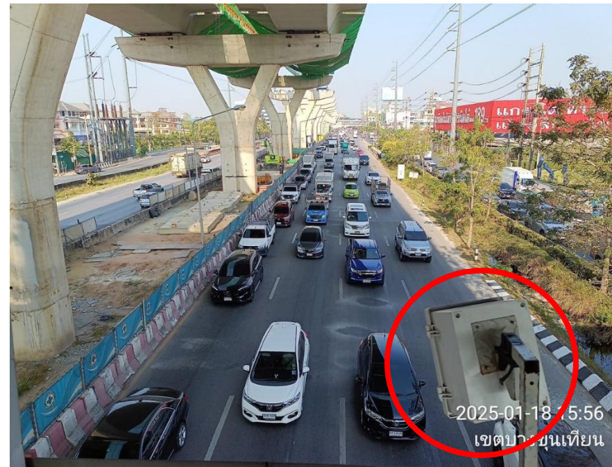
จุดที่ 2 ถนนพระรามที่ 2 บริเวณหน้าโครงการ Origins Rama 2 กม.7+737
