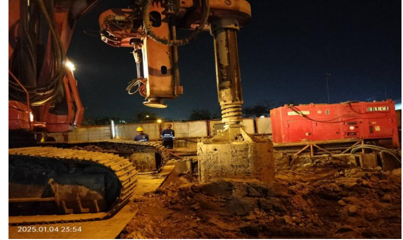
MLP03-15/1C งานเจาะ Bored Pile 1.80 m.
