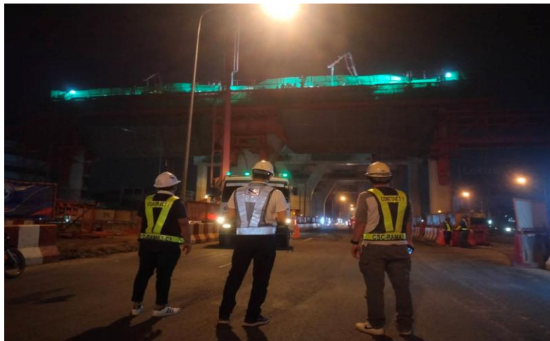
MLP04-04 งานเทคอนกรีต Crossbeam Type IYI-4
