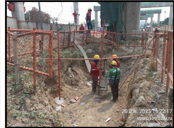
ดำเนินการติดตั้งเครื่องสูบน้ำในพื้นที่ก่อสร้าง
