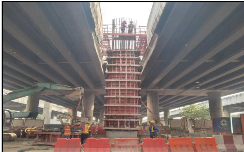
MLP03-07C งานผูกเหล็กเสริม Column Type PT-44 (Modified) Step 3-4
