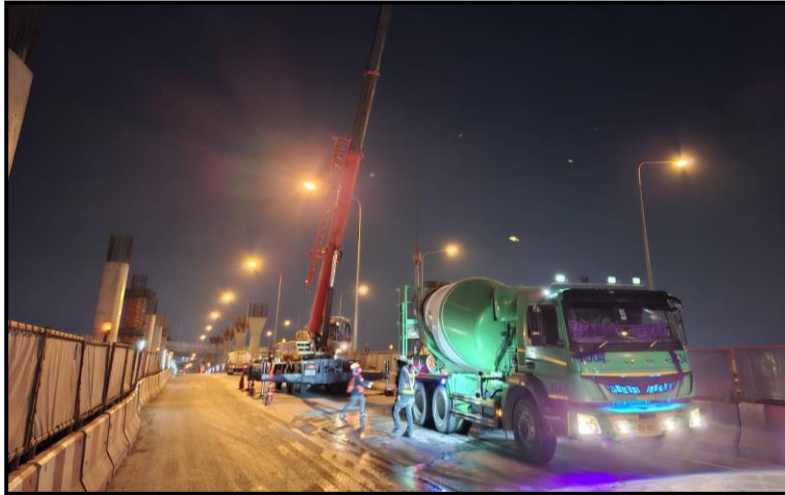
MLP03-07C งานเทคอนกรีต Column Type PT-44 (Modified) Step 1-2
