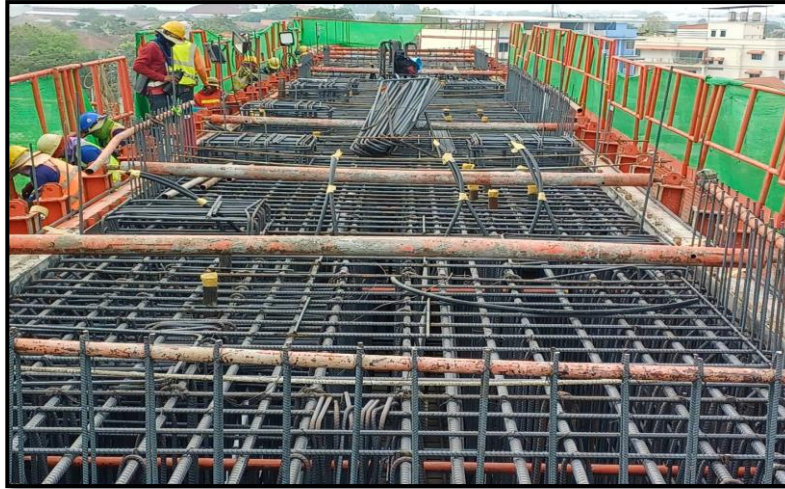
MLP01-29 งานผูกเหล็กเสริม Crossbeam Type IYI-2
