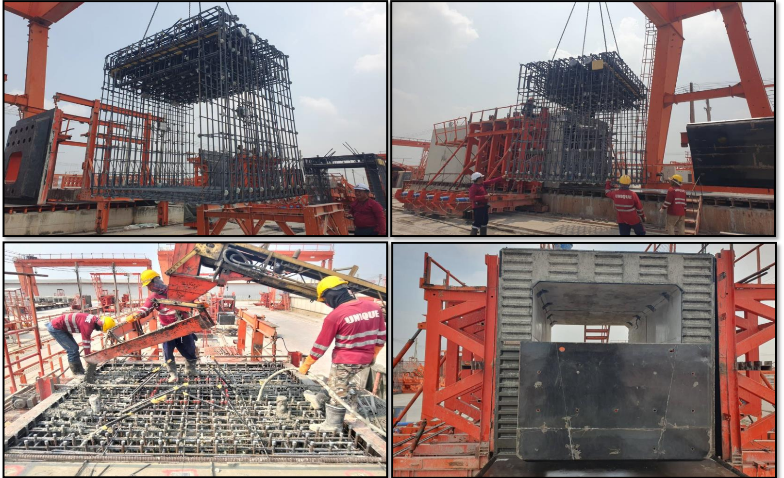
งานหล่อ Precast Crossbeam Type PT-44 ที่โรงหล่อสระบุรี
