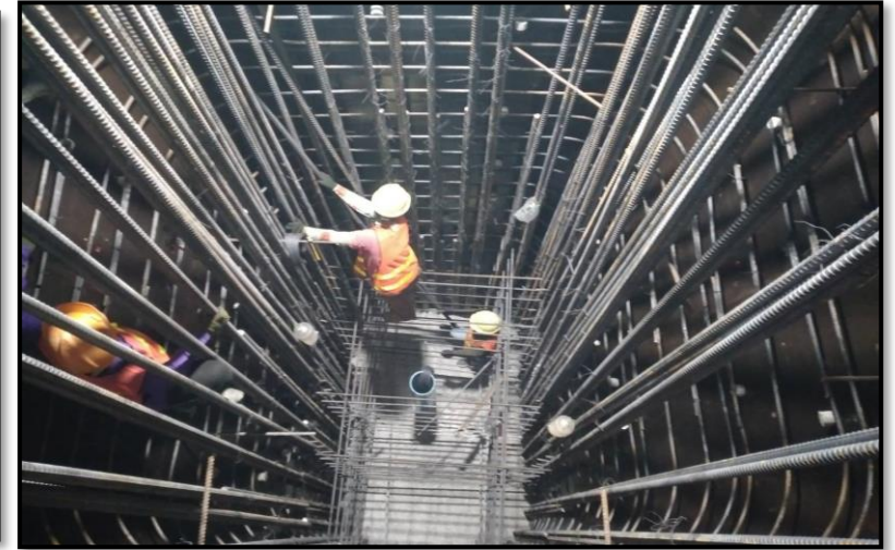
MLP03-03C งานผูกเหล็กเสริม Column Pier Head Type PT-44A
