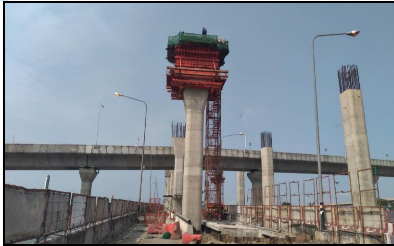
MLP03-14C งานผูกเหล็กเสริม Crossbeam Interface Type PT-44 (Modified)
