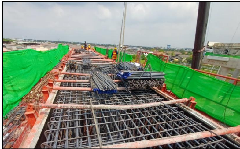
MLP02-20 งานผูกเหล็กเสริม Crossbeam Type IYI-4
