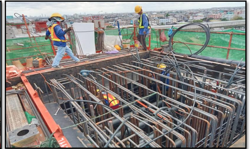
MLP03-14C งานผูกเหล็กเสริม Crossbeam Interface Type PT-44 (Modified)
