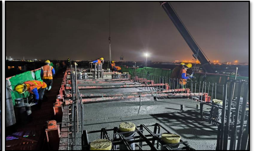
MLP01-19 งานเทคอนกรีต Crossbeam Type Y-1
