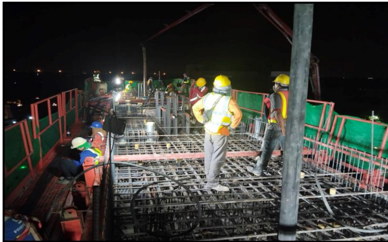
MLP03-26 งานเทคอนกรีต Crossbeam Type YI-2
