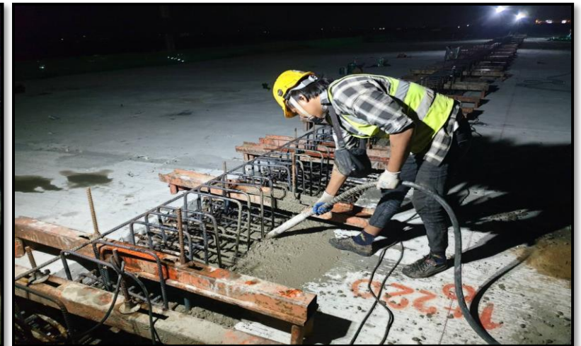
MLP01-10 to MLP01-12 งานเทคอนกรีต Connecting Slab
