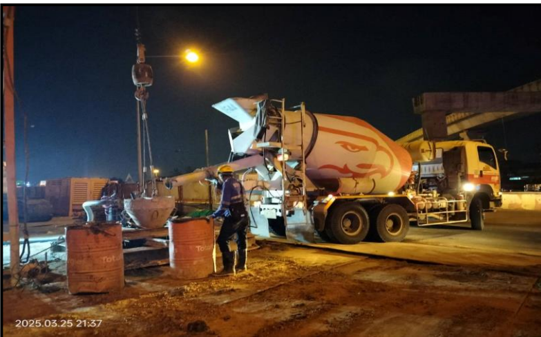
MLP03-01/3C งานเทคอนกรีต Bored Pile 1.80 m.
