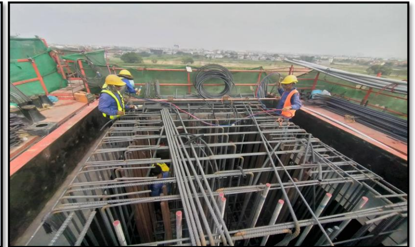
MLP03-14L งานผูกเหล็กเสริม Crossbeam Interface Type PT-44(Modified)
