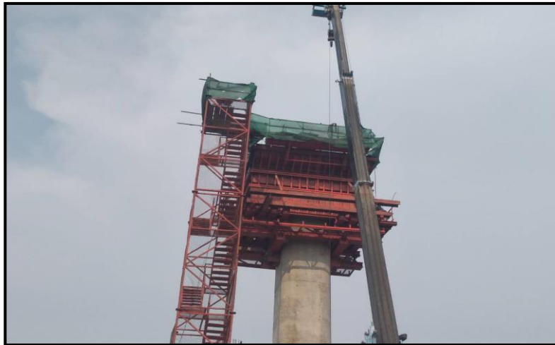
MLP03-14L งานผูกเหล็กเสริม Crossbeam Interface Type PT-44(Modified)
