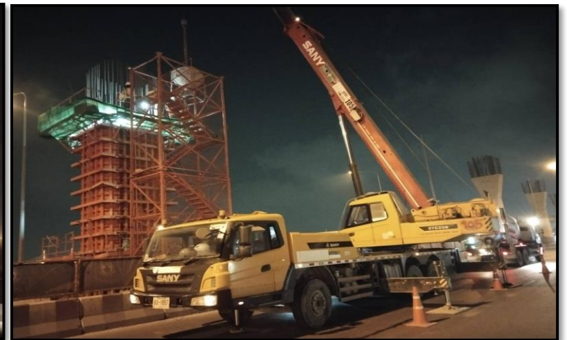
MLP03-07C งานเทคอนกรีต Column Type PT-44(Modified) Step 3-4
