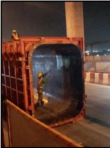
MLP03-09C งานติดตั้ง Formwork Column Type PT-44(Modified) Step 1-2
