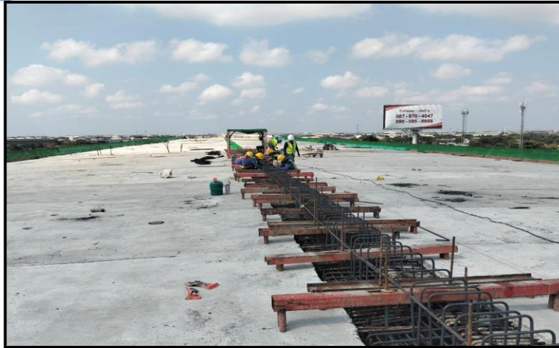
MLP01-10 to MLP01-12 งานผูกเหล็ก Connecting Slab
