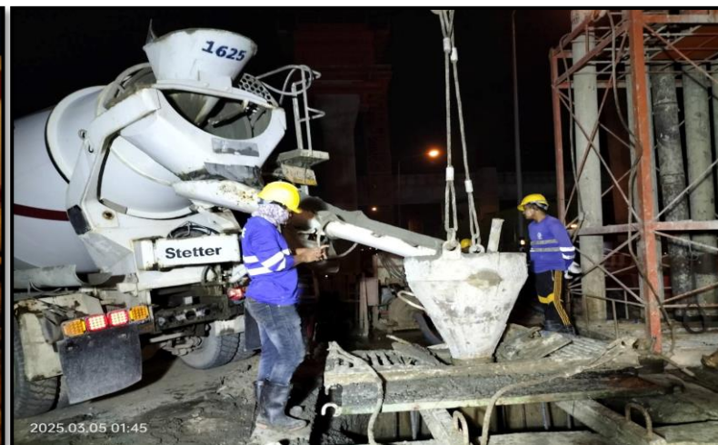
MLP03-15/3C งานเทคอนกรีต Bored Pile 1.80 m.
