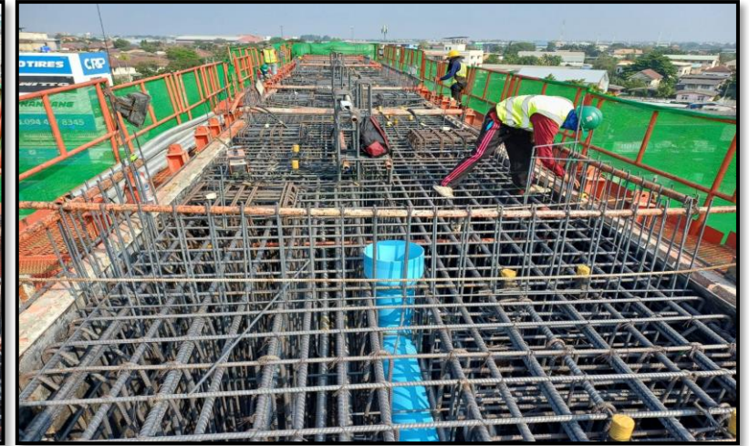
MLP01-29 งานผูกเหล็กเสริม Crossbeam Type IYI-2
