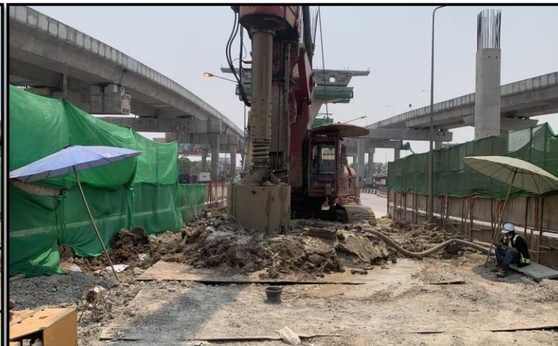
MLP03-01/3C งานเจาะ Bored Pile 1.80 m.
