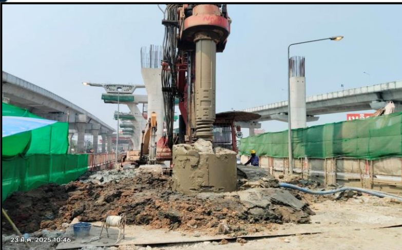
MLP03-01/3C งานเจาะ Bored Pile 1.80 m.
