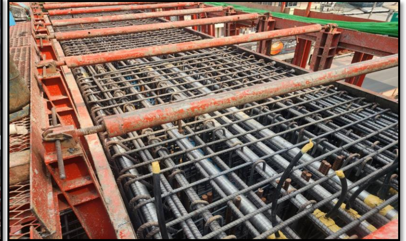
ROF2-09 งานผูกเหล็กเสริม Crosshead Type P-2
