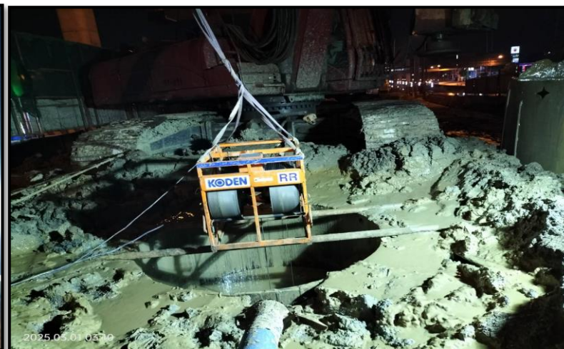
MLP03-15/3C งานเจาะ Bored Pile 1.80 m.
