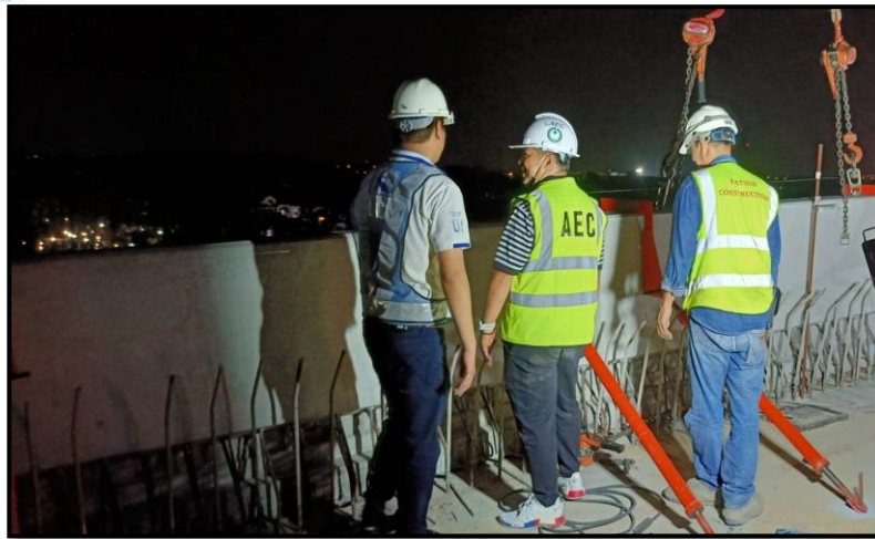
RON1-24 to RON1-25 งานติดตั้ง Parapet
