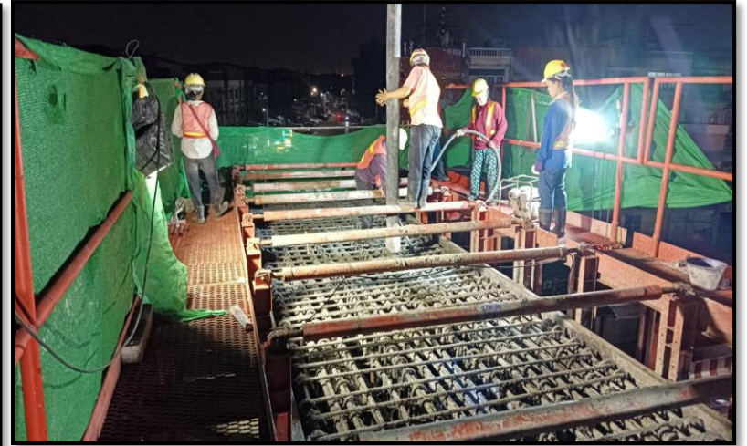
ROF2-09 งานเทคอนกรีต Crosshead Type P-2
