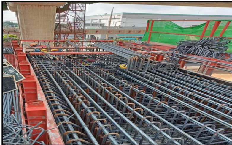
ROF2-08 งานผูกเหล็กเสริม Crosshead Type P-2
