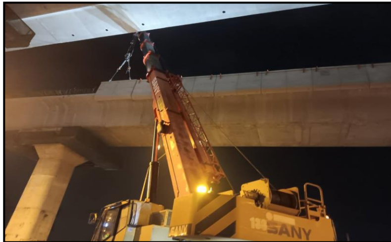
ROF1-04 to ROF1-05 งานติดตั้ง Parapet
