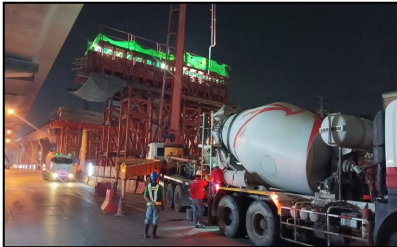
ROF2-09 งานเทคอนกรีต Crosshead Type P-2
