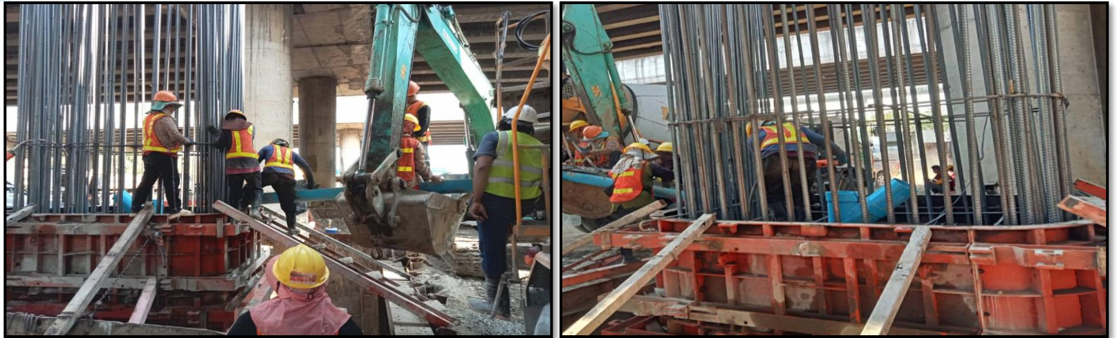
MLP03-09C งานเทคอนกรีต Column Type PT-44 (Modified) Step 1
