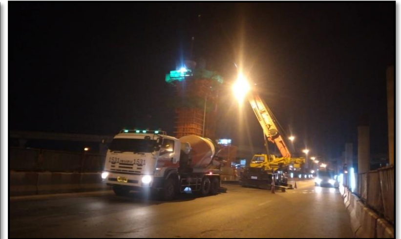
MLP03-04C งานเทคอนกรีต Column Pier Head Type PT-44A
