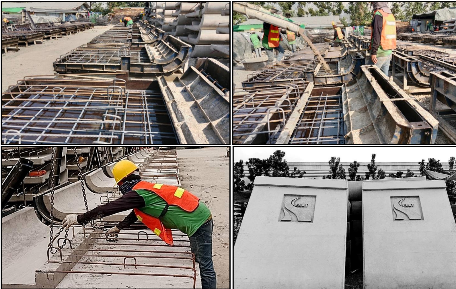
งานหล่อ Precast Parapet Zone 3
