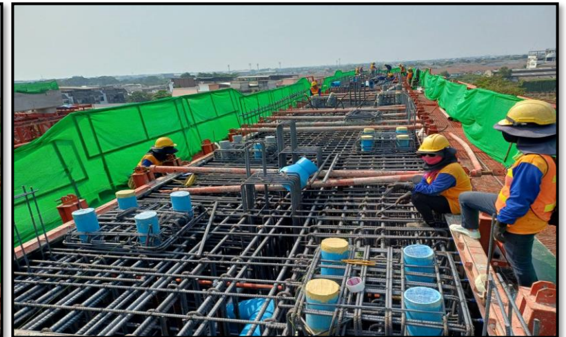
MLP02-20 งานผูกเหล็กเสริม Crossbeam Type IYI-4
