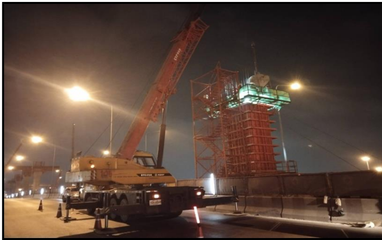
MLP03-07C งานเทคอนกรีต Column Type PT-44(Modified) Step 3-4
