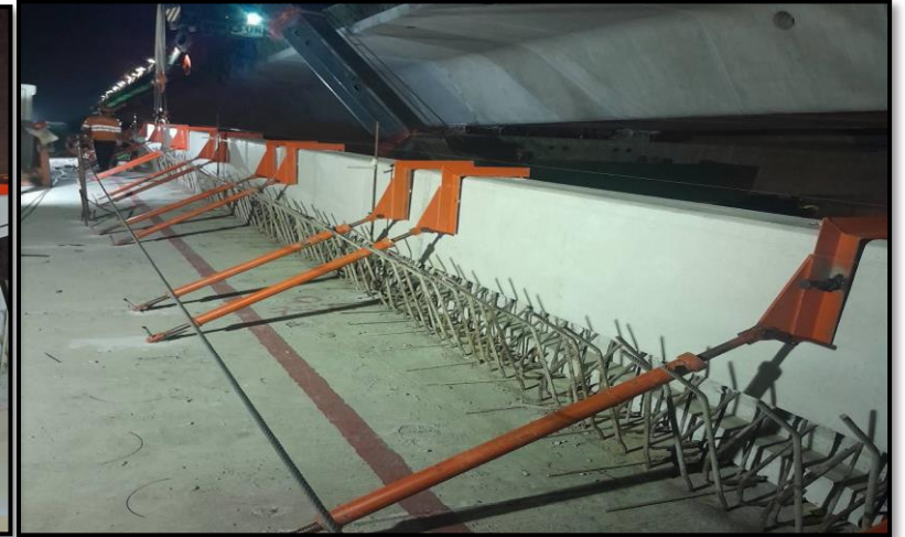
RON1-24 to RON1-25 งานติดตั้ง Parapet
