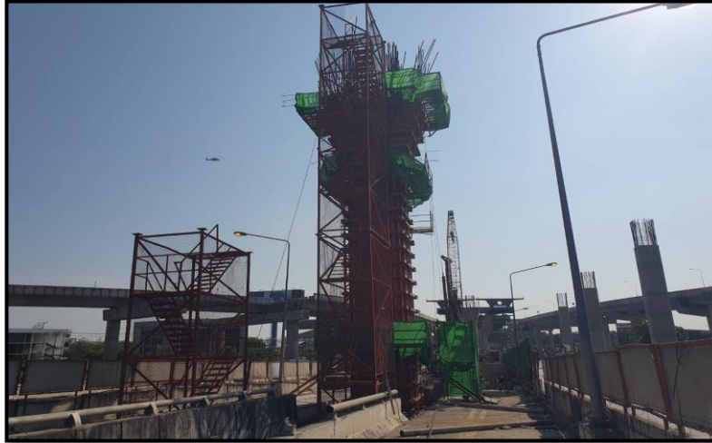
MLP03-03C งานผูกเหล็กเสริม Column Pier Head Type PT-44A
