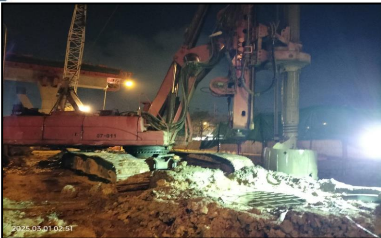
MLP03-15/3C งานเจาะ Bored Pile 1.80 m.
