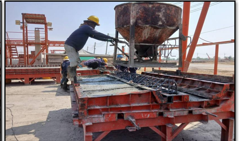
งานหล่อ Parapet Zone 1-2 ที่โรงหล่อสระบุรี
