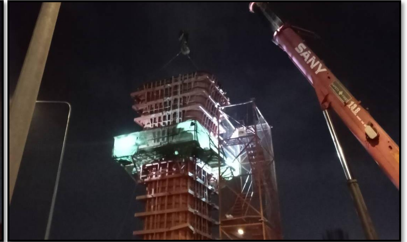
MLP03-07C งานติดตั้ง Formwork Column Pier Head Type PT-44(Modified)
