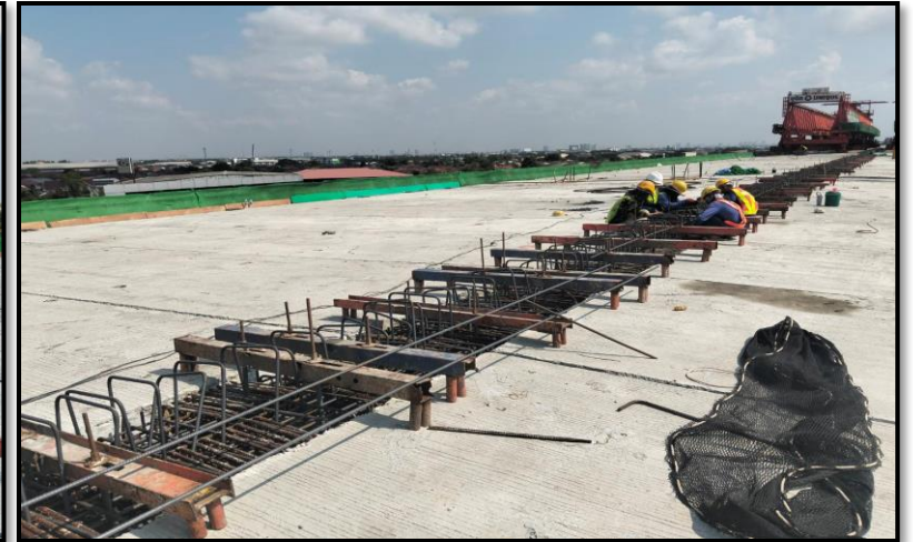
MLP01-10 to MLP01-12 งานผูกเหล็ก Connecting Slab
