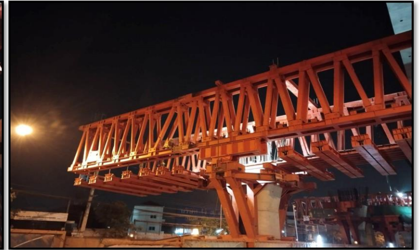
MLP01-08 งานติดตั้ง Formwork Lower Crossbeam Type PTT-1
