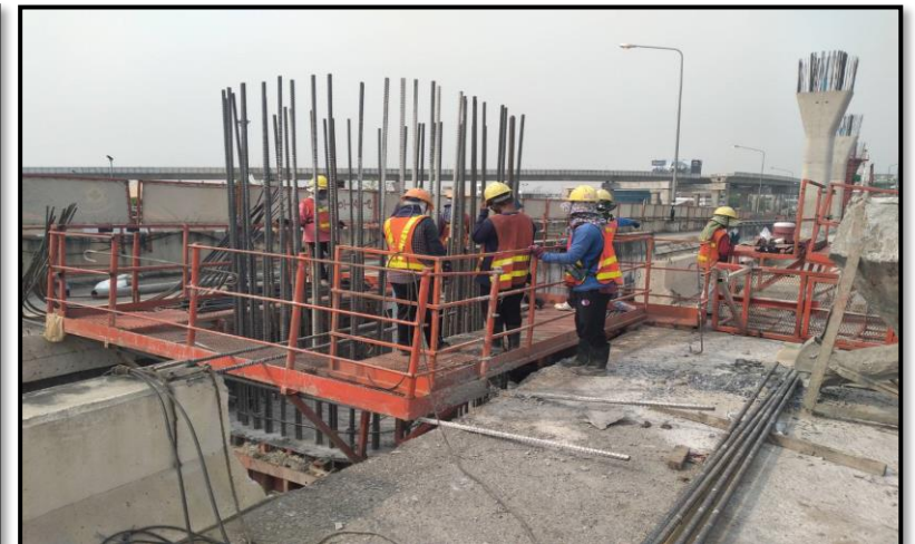
MLP03-07C งานผูกเหล็กเสริม Column Type PT-44 (Modified) Step 3-4
