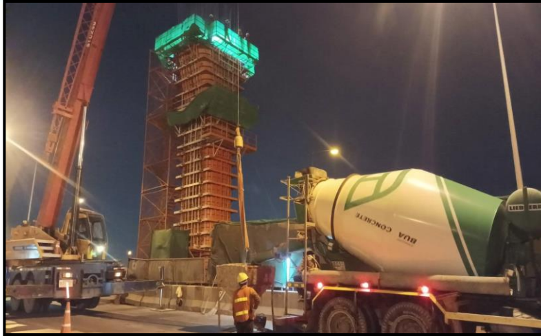
MLP03-03C งานเทคอนกรีต Column Pier Head Type PT-44A
