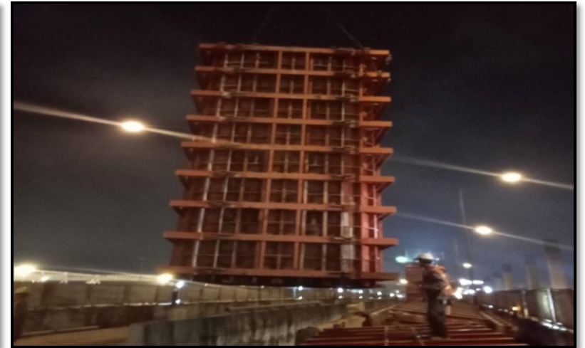
MLP03-09C งานติดตั้ง Formwork Column Type PT-44(Modified) Step 1-2
