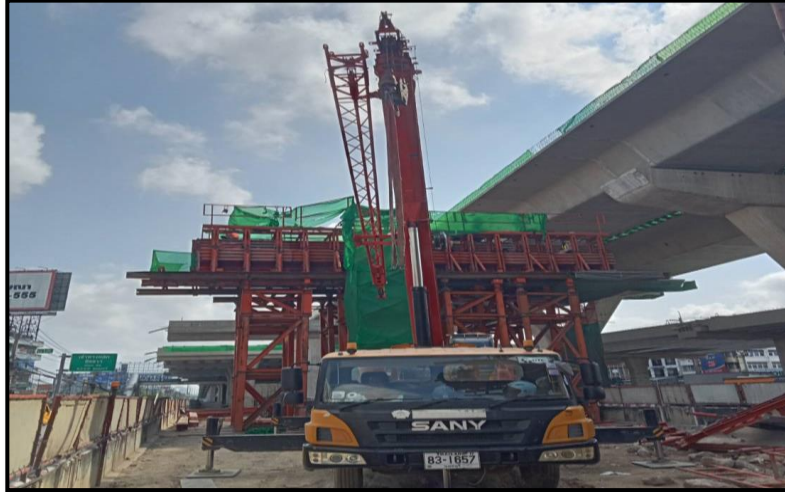
ROF2-09 งานผูกเหล็กเสริม Crosshead Type P-2
