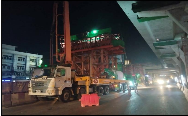
ROF2-08 งานเทคอนกรีต Crosshead Type P-2
