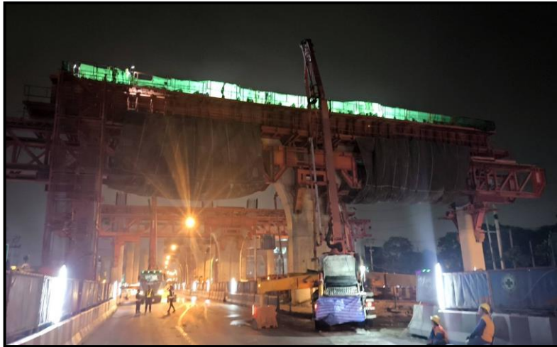
MLP01-19 งานเทคอนกรีต Crossbeam Type Y-1
