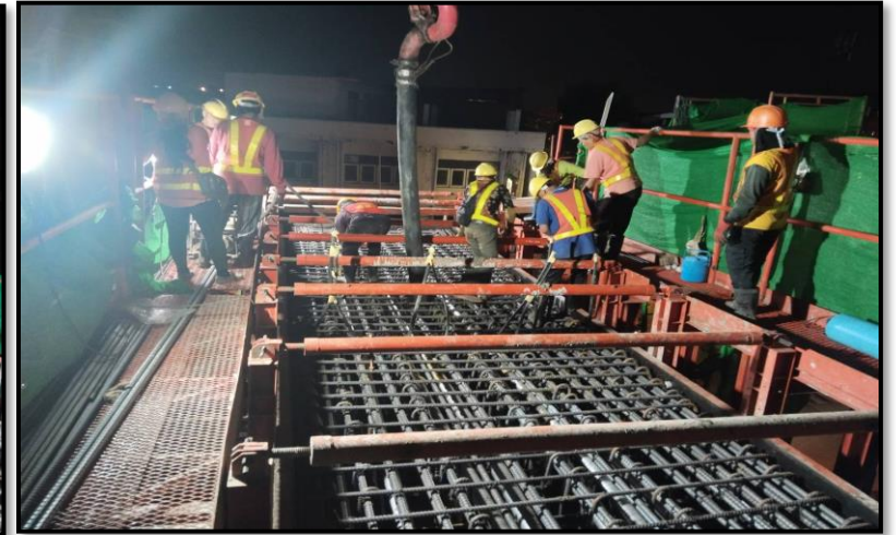
MLP03-26 งานเทคอนกรีต Crossbeam Type YI-2
