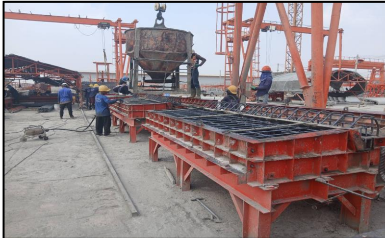
งานหล่อ Parapet Zone 1-2 ที่โรงหล่อสระบุรี
