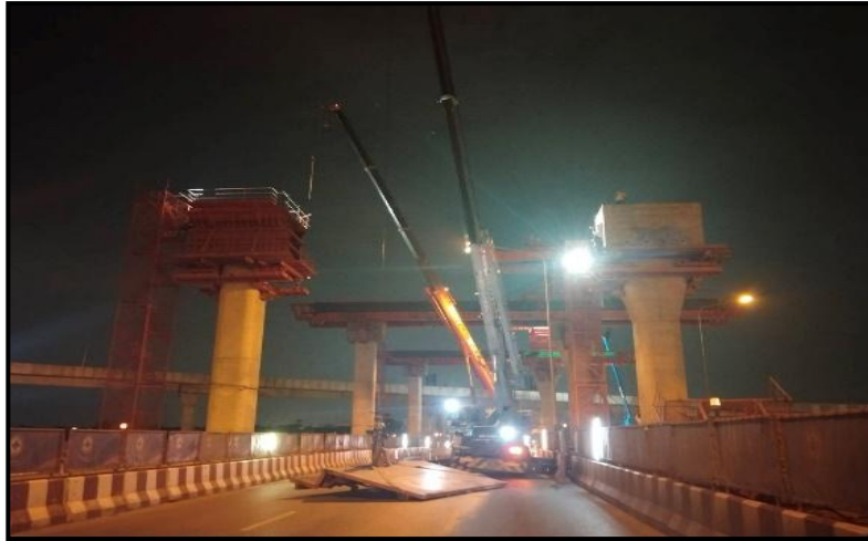
MLP03-10C งานติดตั้ง Formwork Crossbeam Interface Type PT-44 (Modified)
