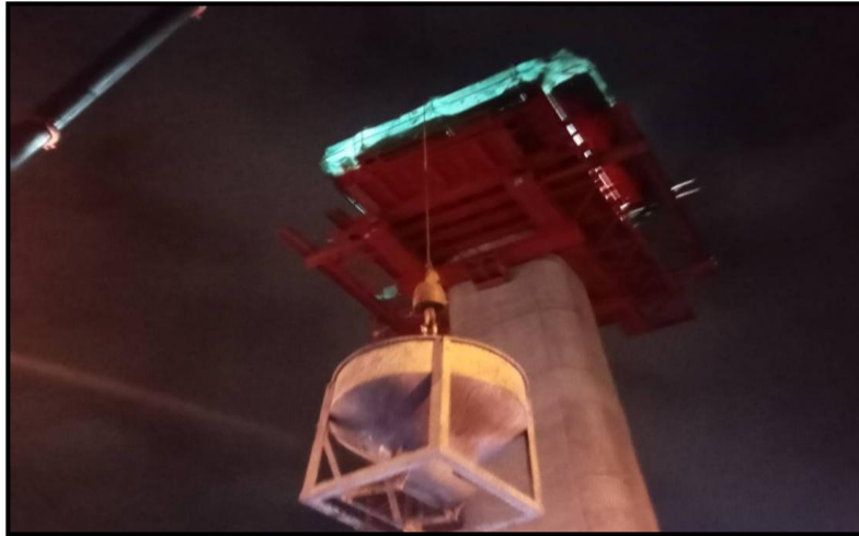
MLP03-14L งานเทคอนกรีต Crossbeam Interface Type PT-44 (Modified)
