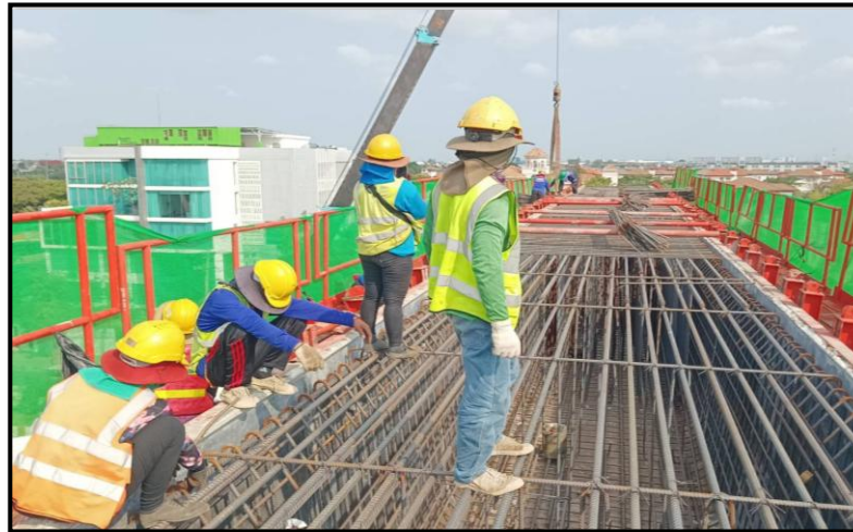
MLP03-28 งานผูกเหล็กเสริม Crossbeam Type IYI-4
