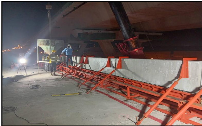
ROF1-06 to ROF1-07 งานเทคอนกรีต Infill Parapet
