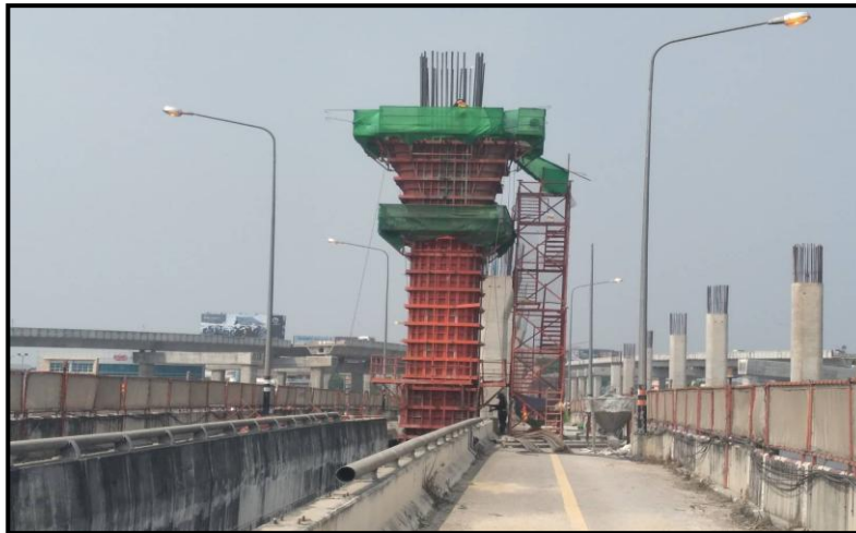
MLP03-07C งานผูกเหล็กเสริม Column Head Type PT-44 (Modified)
