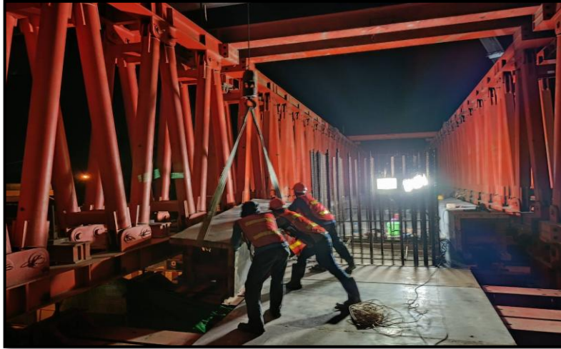
MLP01-08 งานติดตั้ง Formwork Lower Crossbeam Type PTT-1
