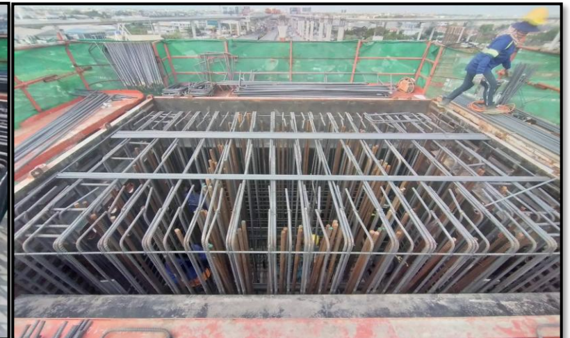
MLP03-10C งานผูกเหล็กเสริม Crossbeam Interface Type PT-44 (Modified)
