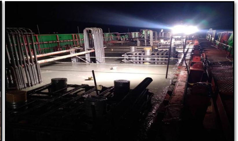
MLP01-29 งานเทคอนกรีต Crossbeam Type IYI -2
