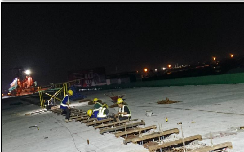
MLP04-06 to MLP04-13 งานผูกเหล็กเสริม Connecting Slab
