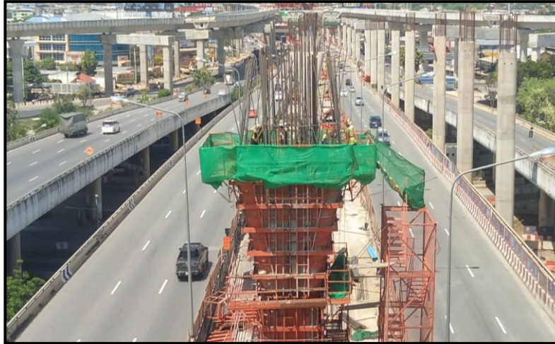
MLP03-09C งานผูกเหล็กเสริม Column Head Type PT-44 (Modified)
