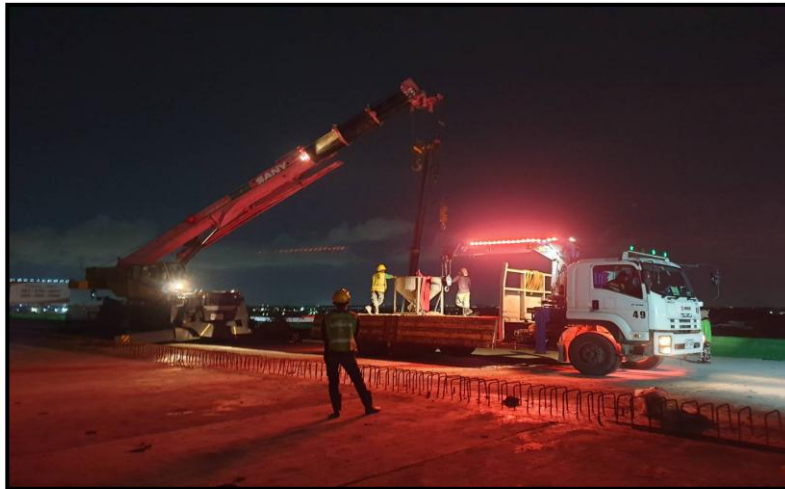
MLP01-15 to MLP01-16 งานเทคอนกรีต Connecting Slab
