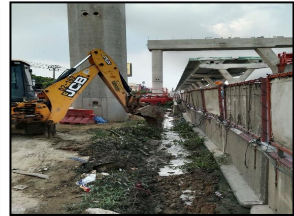
ดำเนินการขุดทำบ่อพักน้ำในเขตพื้นที่ก่อสร้าง
