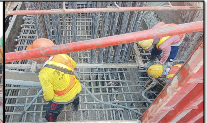
MLP03-06C งานเทคอนกรีต Footing
