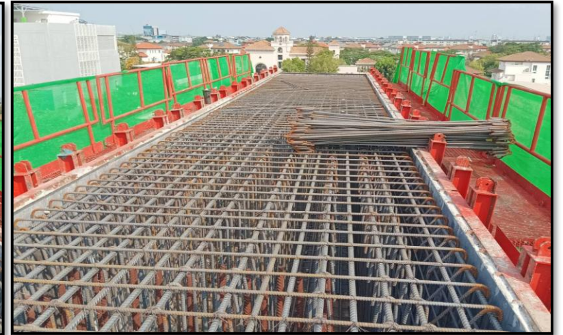
MLP03-28 งานผูกเหล็กเสริม Crossbeam Type IYI-4
