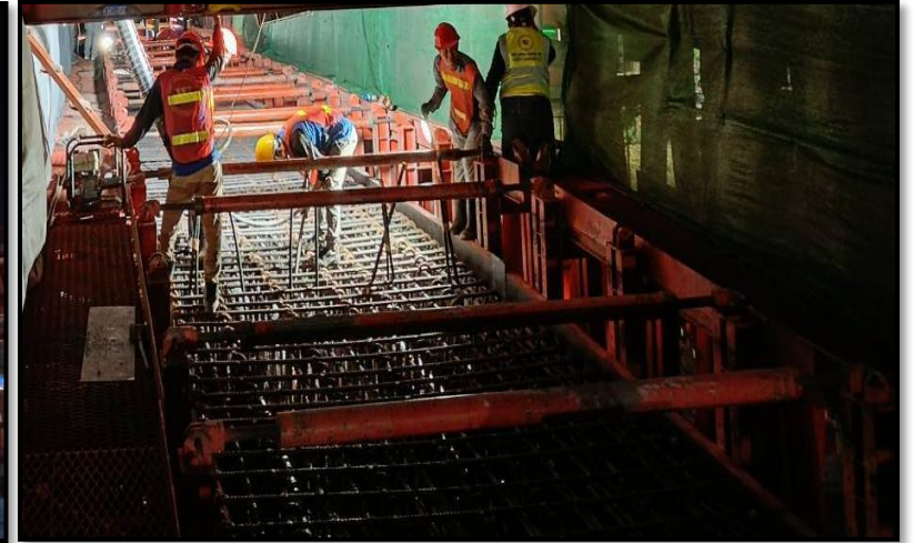
MLP01-06 งานเทคอนกรีต Lower Crossbeam Type PTT-1
