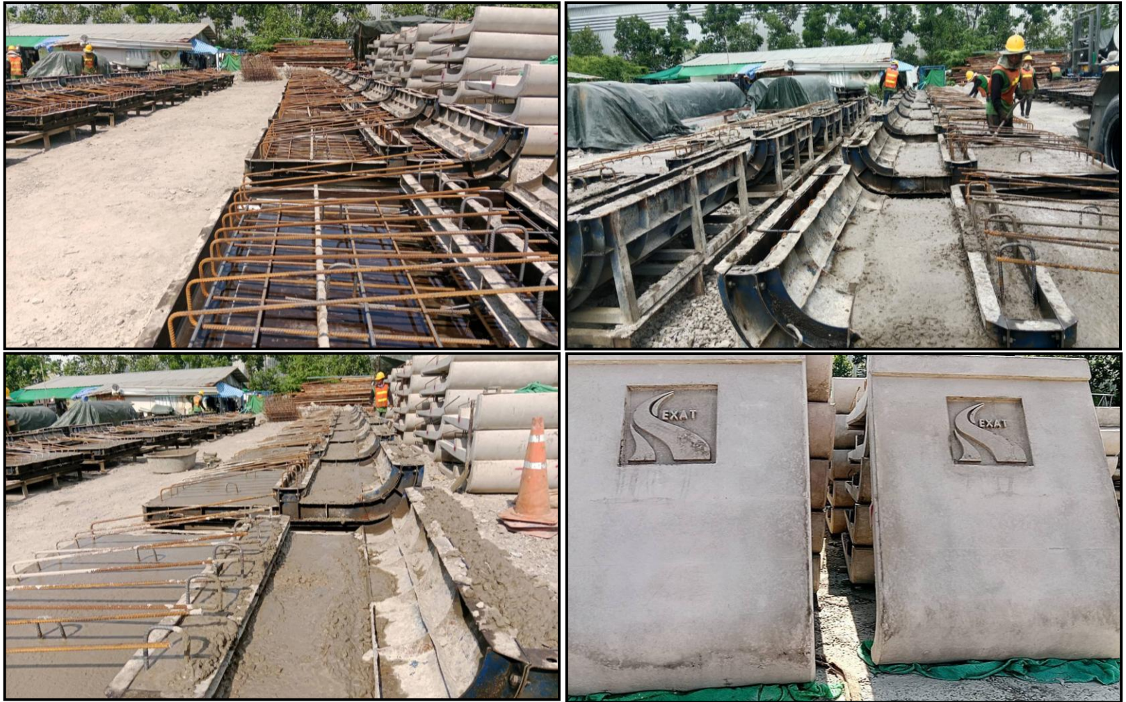
งานหล่อ Precast Parapet Zone 3
