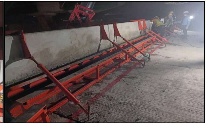
ROF1-06 to ROF1-07 งานเทคอนกรีต Infill Parapet
