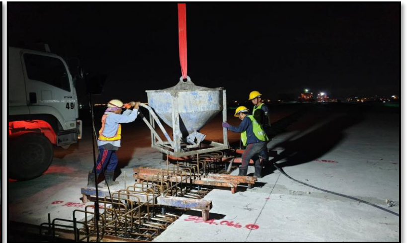
MLP01-15 to MLP01-16 งานเทคอนกรีต Connecting Slab
