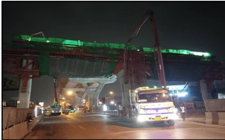
MLP01-29 งานเทคอนกรีต Crossbeam Type IYI -2
