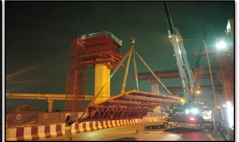
MLP03-10C งานติดตั้ง Formwork Crossbeam Interface Type PT-44 (Modified)
