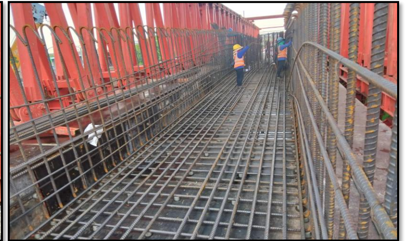
MLP01-08 งานผูกเหล็กเสริม Lower Crossbeam Type PTT-1
