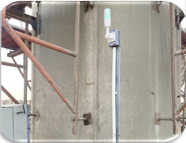
อุปกรณ์การตรวจติดตามพฤติกรรมโครงสร้างสะพาน บริเวณสะพานต่างระดับบางขุนเทียน
