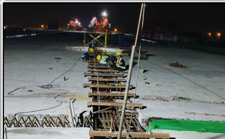
MLP04-06 to MLP04-13 งานผูกเหล็กเสริม Connecting Slab
