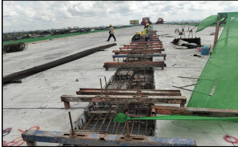
MLP01-15 to MLP01-16 งานผูกเหล็กเสริม Connecting Slab
