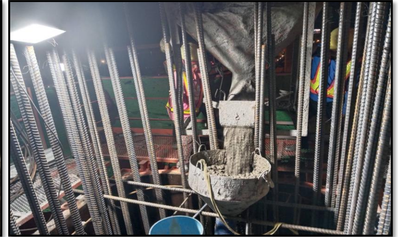
MLP03-08C งานเทคอนกรีต Column Type PT-44 (Modified) Step 4
