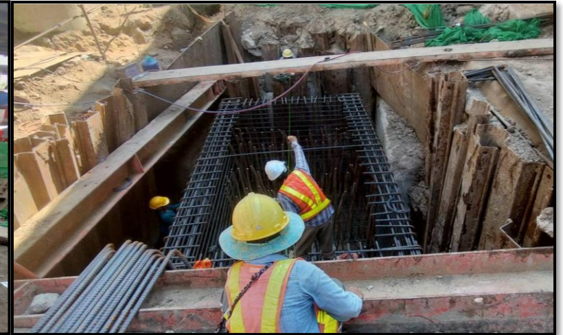
MLP03-06C งานผูกเหล็กเสริม Footing
