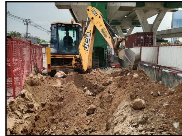
ดำเนินการขุดทำบ่อพักน้ำในเขตพื้นที่ก่อสร้าง
