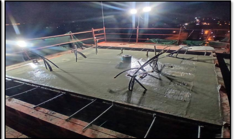
MLP03-14L งานเทคอนกรีต Crossbeam Interface Type PT-44 (Modified)
