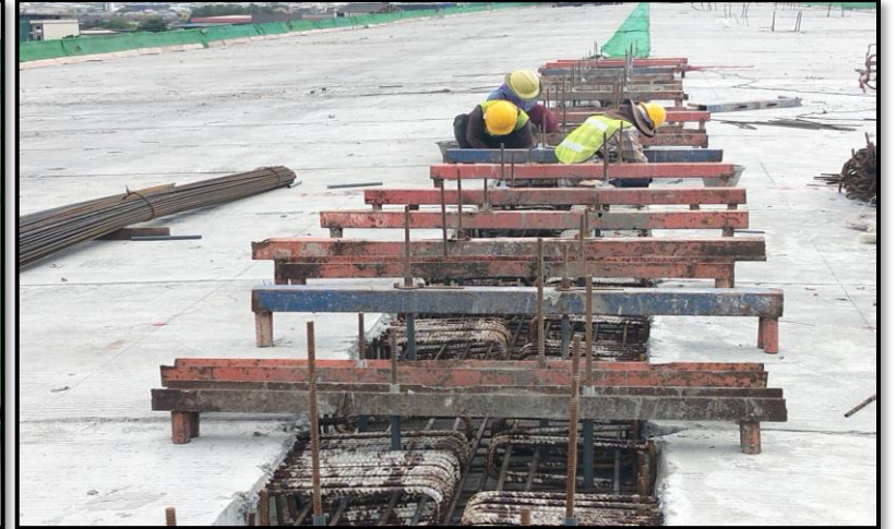
MLP01-15 to MLP01-16 งานผูกเหล็กเสริม Connecting Slab
