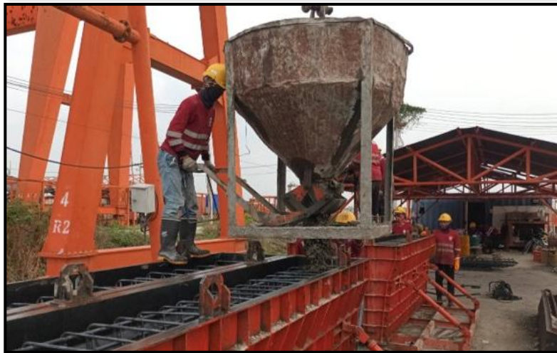
งานหล่อ Precast Central Barrier ที่โรงหล่อสระบุรี
