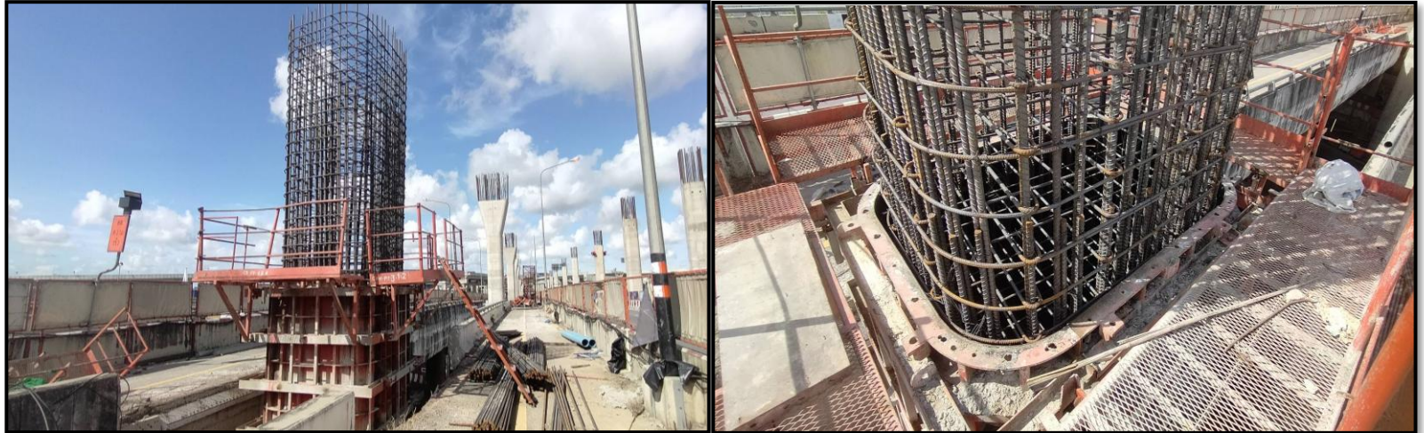
MLP03-08C งานผูกเหล็กเสริม Column Type PT-44 (Modified) Step 3-4
