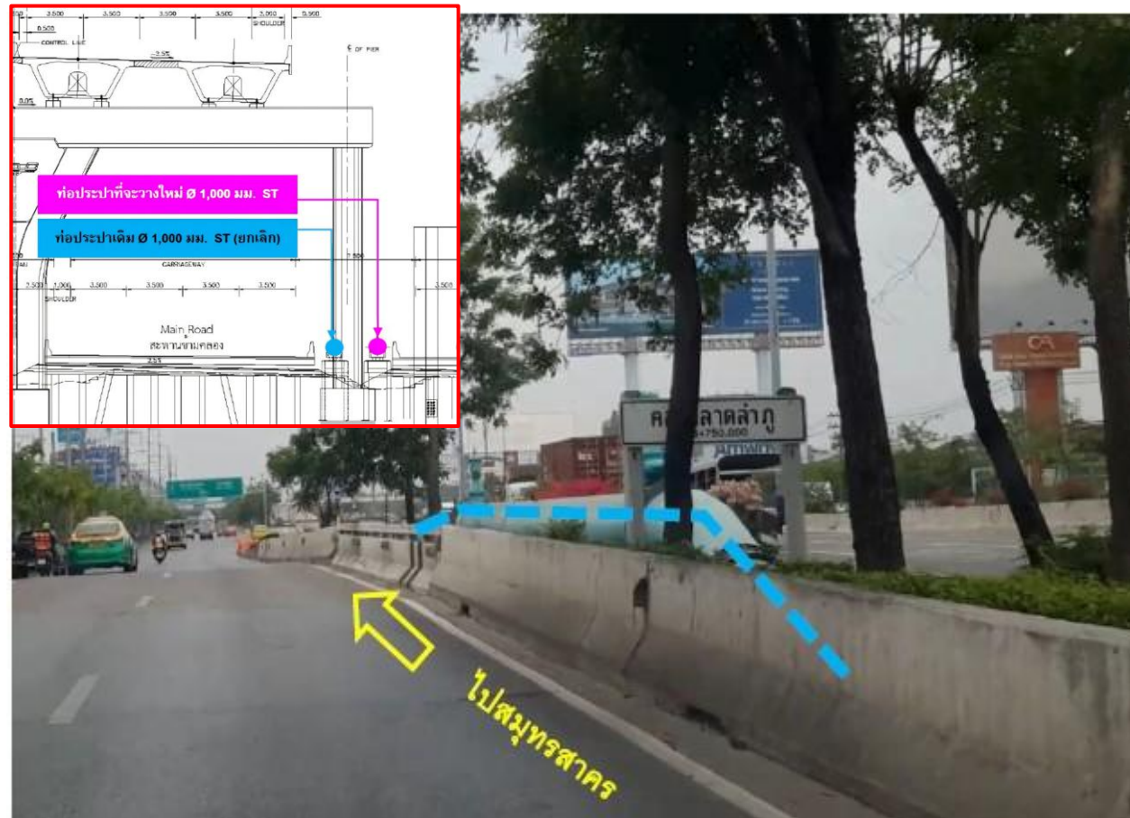
4 อุปสรรคท่อประปา 1,000 mm บริเวณคลองลาดลำภูของ กปน. กีดขวางงานก่อสร้างฐานราก Pier RON2-26 MLP04-05 และ MLP04-06
