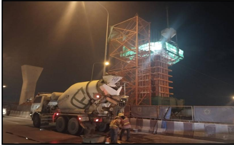
MLP03-08C งานเทคอนกรีต Column Type PT-44 (Modified) Step 4
