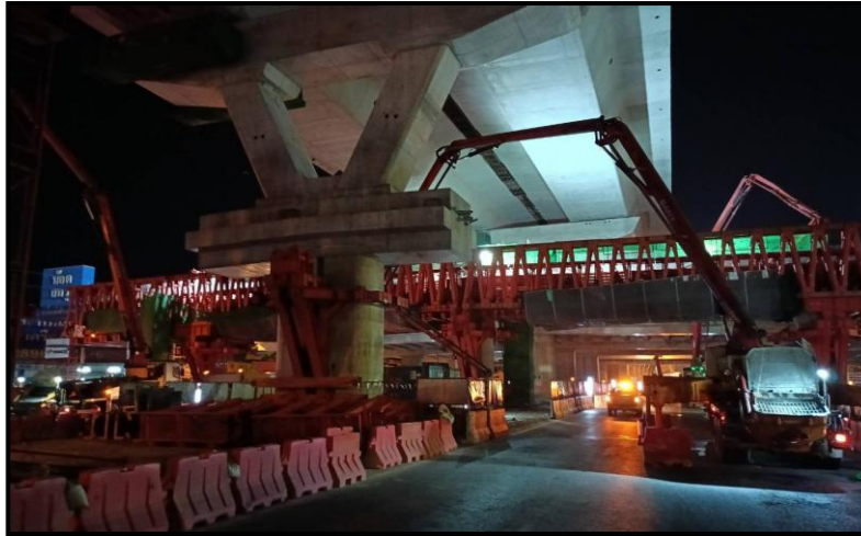
MLP01-06 งานเทคอนกรีต Lower Crossbeam Type PTT-1
