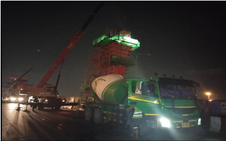
MLP03-07C งานเทคอนกรีต Column Head Type PT-44 (Modified)
