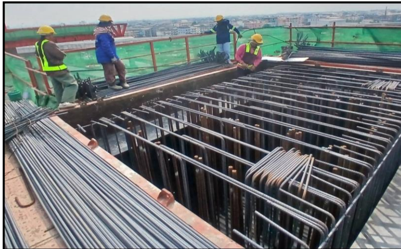
MLP03-10C งานผูกเหล็กเสริม Crossbeam Interface Type PT-44 (Modified)
