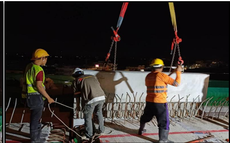
MLP01-22 to MLP01-23 งานติดตั้ง Parapet
