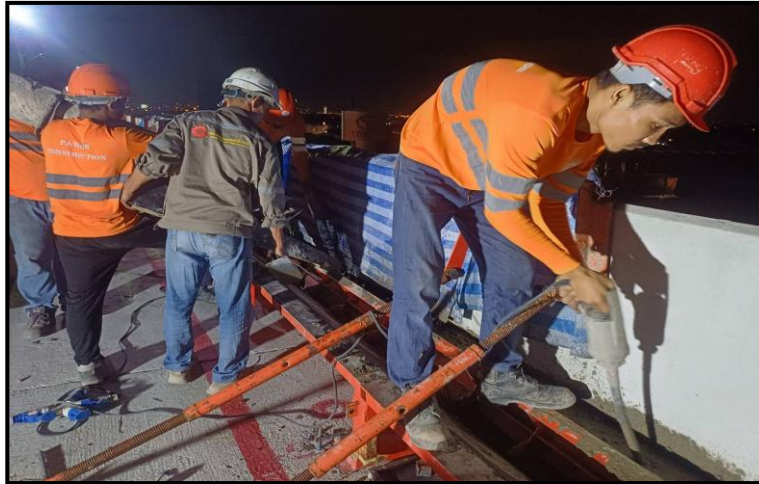
MLP01-09 to MLP01-11 งานเทคอนกรีต Infill Parapet
