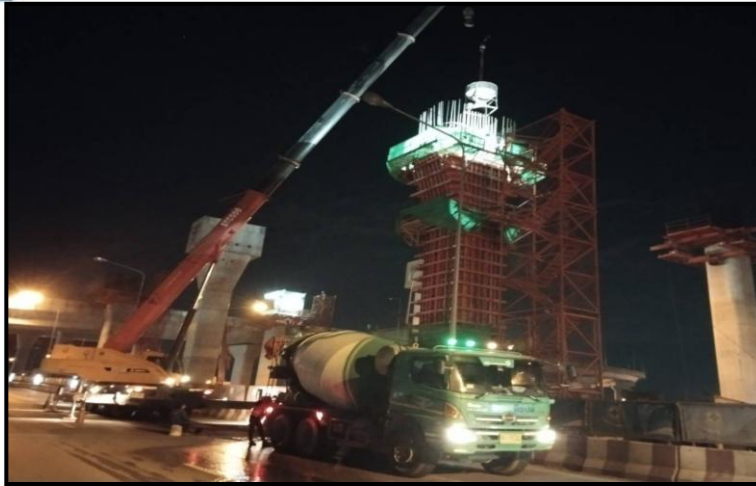
MLP03-15C งานเทคอนกรีต Column Head Type PT-44A
