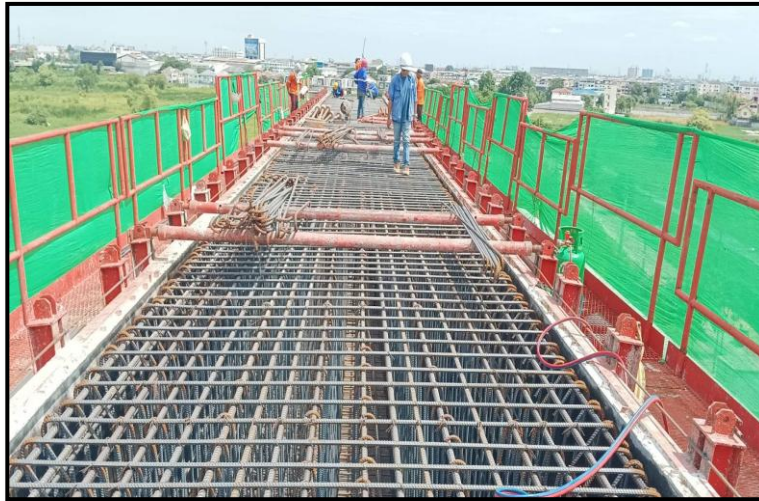
MLP03-21 งานผูกเหล็กเสริม Crossbeam Type IYI-3
