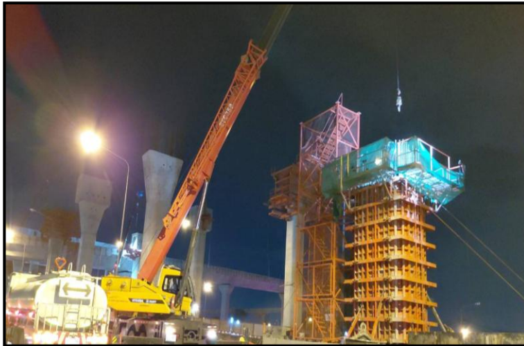
MLP03-16C งานเทคอนกรีต Column Type PT-44A Step 1-2
