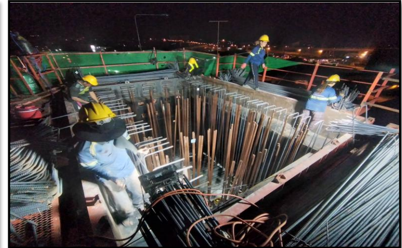
MLP03-13C งานผูกเหล็กเสริม Crossbeam Interface Type PT-44 (Modified)
