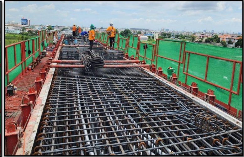
MLP03-21 งานผูกเหล็กเสริม Crossbeam Type IYI-3
