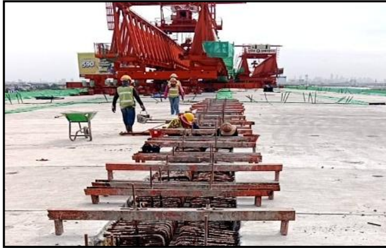
MLP01-24 to MLP01-25 งานผูกเหล็กเสริม Connecting Slab
