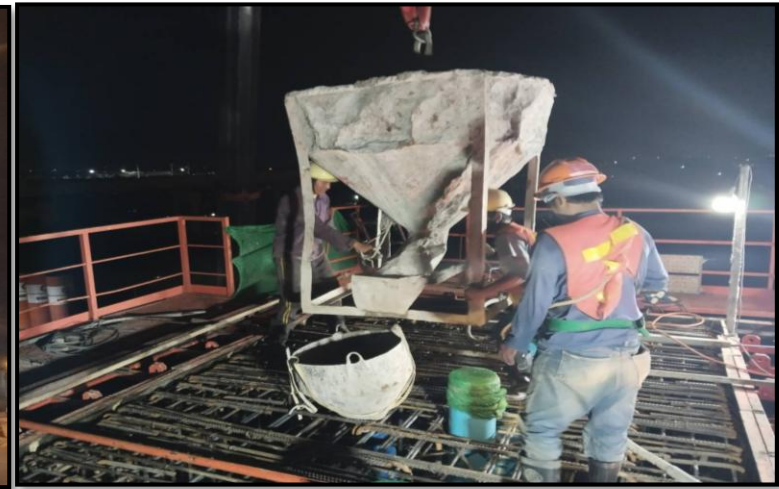
MLP03-05C งานเทคอนกรีต Crossbeam Interface Type PT-44 (Modified)
