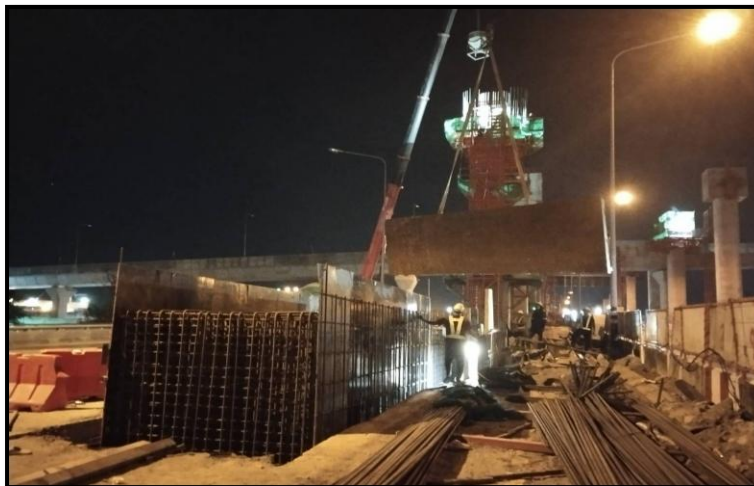
MLP03-16C งานติดตั้ง Formwork Footing
