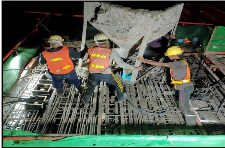
MLP03-05L งานเทคอนกรีต Crossbeam Interface Type PT-44 (Modified)
