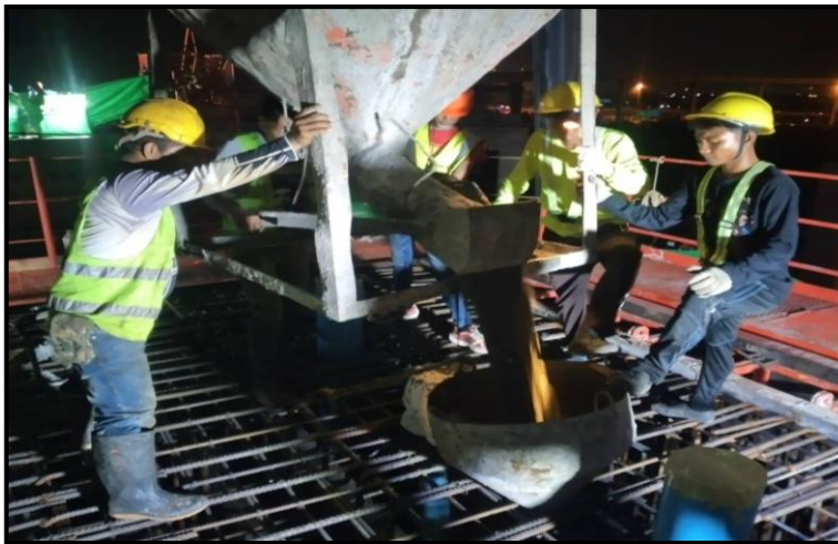
MLP02-27C งานเทคอนกรีต Crossbeam Interface Type PT-44A
