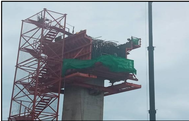
MLP03-05L งานผูกเหล็กเสริม Crossbeam Interface Type PT-44 (Modified)
