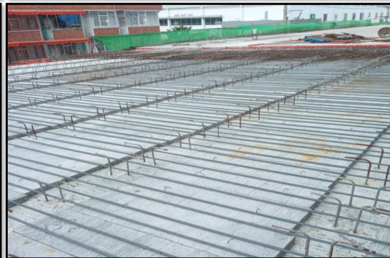
MLP04-15 to RON2-18 งานผูกเหล็กเสริม Deck Slab
