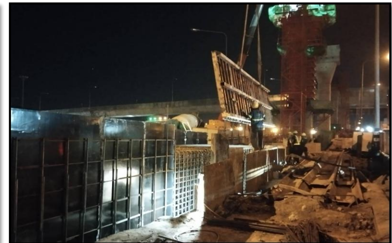
MLP03-16C งานติดตั้ง Formwork Footing
