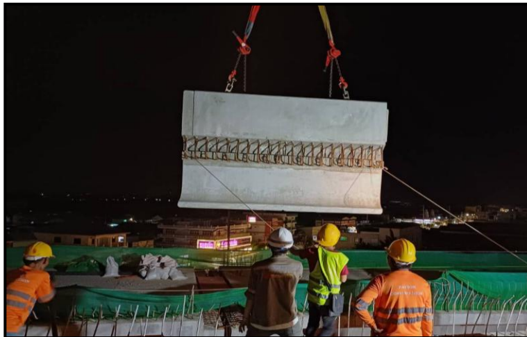
MLP01-22 to MLP01-23 งานติดตั้ง Parapet
