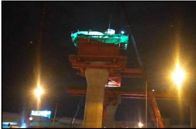
MLP03-04C งานเทคอนกรีต Crossbeam Interface Type PT-44A
