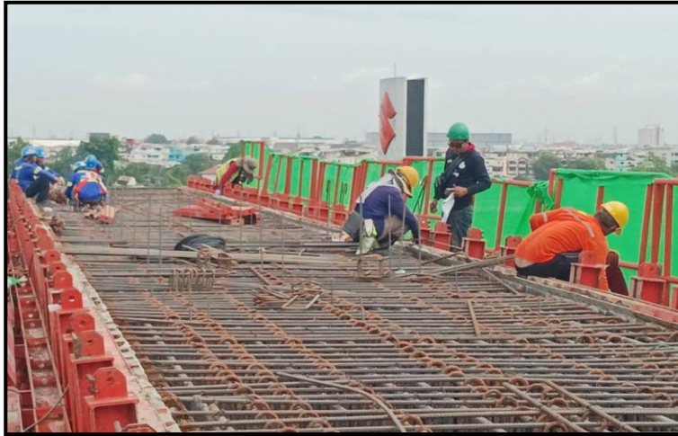
MLP03-23 งานผูกเหล็กเสริม Crossbeam Type IYI-4
