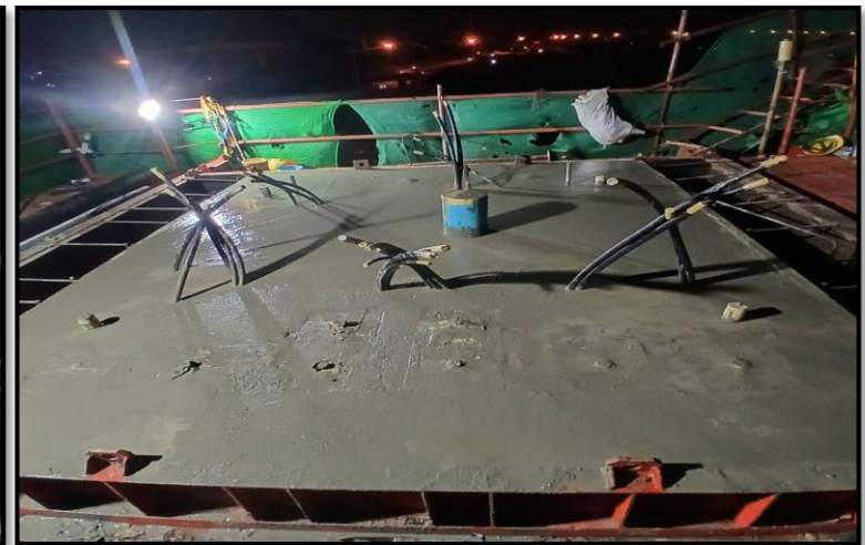
MLP03-13L งานเทคอนกรีต Crossbeam Interface Type PT-44 (Modified)
