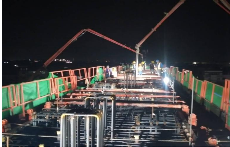
MLP03-22 งานเทคอนกรีต Crossbeam Type IYI-3
