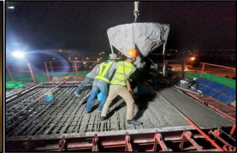
MLP03-04C งานเทคอนกรีต Crossbeam Interface Type PT-44A
