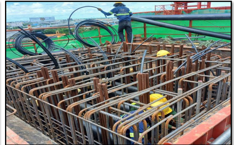
MLP03-13L งานผูกเหล็กเสริม Crossbeam Interface Type PT-44 (Modified)
