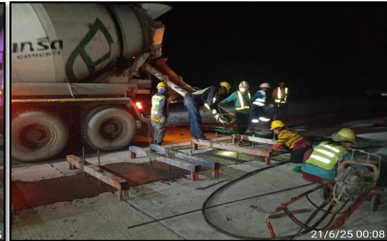
MLP01-24 to MLP01-25 งานเทคอนกรีต Connecting Slab
