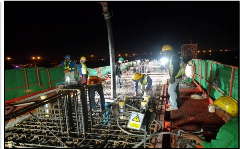
MLP03-20 งานเทคอนกรีต Crossbeam Type YI-2
