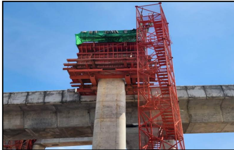
MLP03-13L งานผูกเหล็กเสริม Crossbeam Interface Type PT-44 (Modified)
