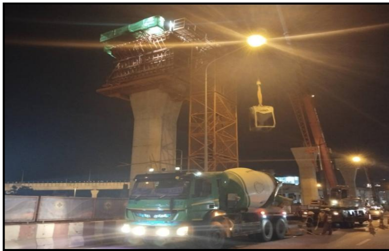
MLP03-05C งานเทคอนกรีต Crossbeam Interface Type PT-44 (Modified)
