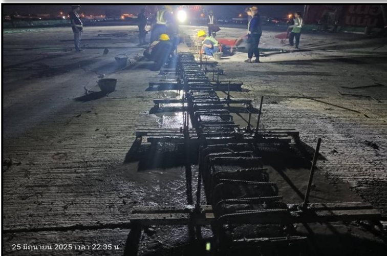
MLP04-04 to MLP04-06 งานเทคอนกรีต Connecting Slab
