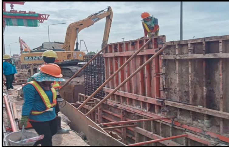
MLP03-01C งานติดตั้ง Formwork Footing
