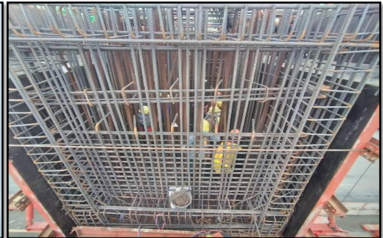
MLP03-05L งานผูกเหล็กเสริม Crossbeam Interface Type PT-44 (Modified)
