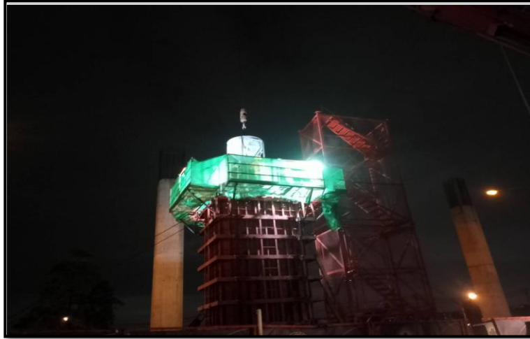
MLP03-15C งานเทคอนกรีต Column Type PT-44A Step 1
