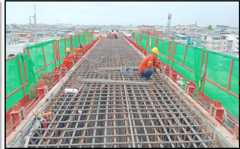
MLP03-23 งานผูกเหล็กเสริม Crossbeam Type IYI-4
