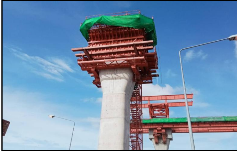
MLP03-13C งานผูกเหล็กเสริม Crossbeam Interface Type PT-44 (Modified)
