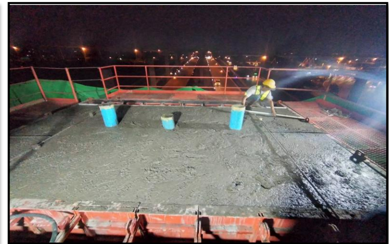
MLP02-27C งานเทคอนกรีต Crossbeam Interface Type PT-44A
