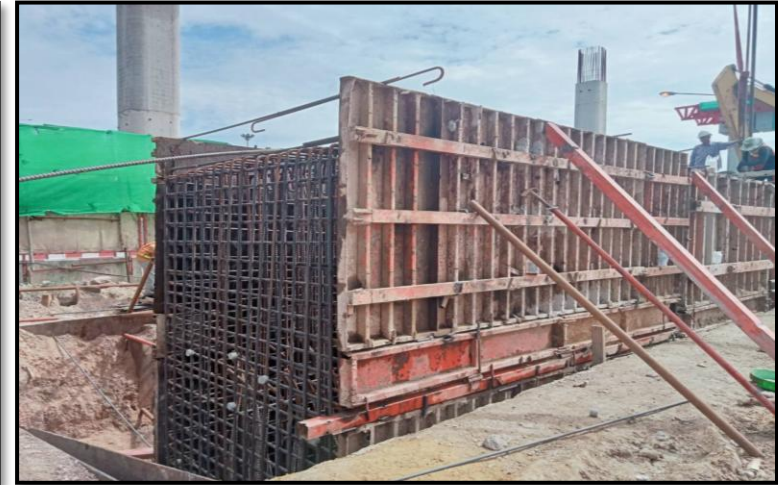
MLP03-01C งานติดตั้ง Formwork Footing
