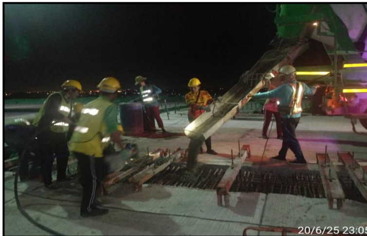
MLP01-24 to MLP01-25 งานเทคอนกรีต Connecting Slab
