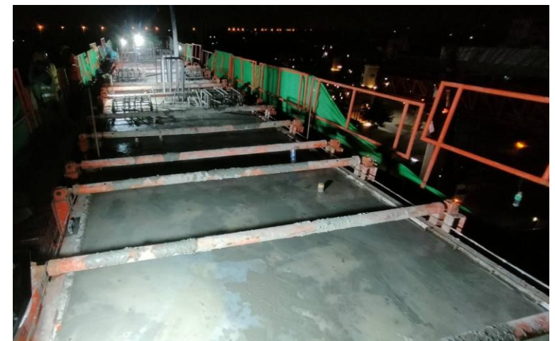
MLP03-23 งานเทคอนกรีต Crossbeam Type IYI-4
