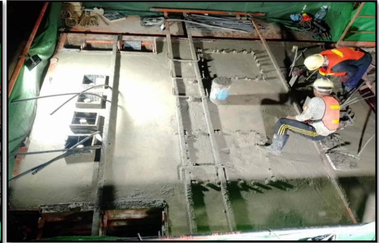
MLP03-05L งานเทคอนกรีต Crossbeam Interface Type PT-44 (Modified)
