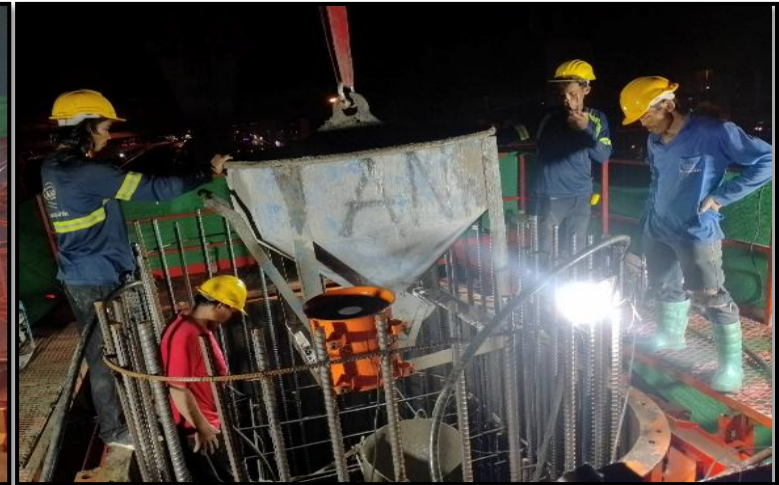
MLP03-15C งานเทคอนกรีต Column Type PT-44A Step 2-3
