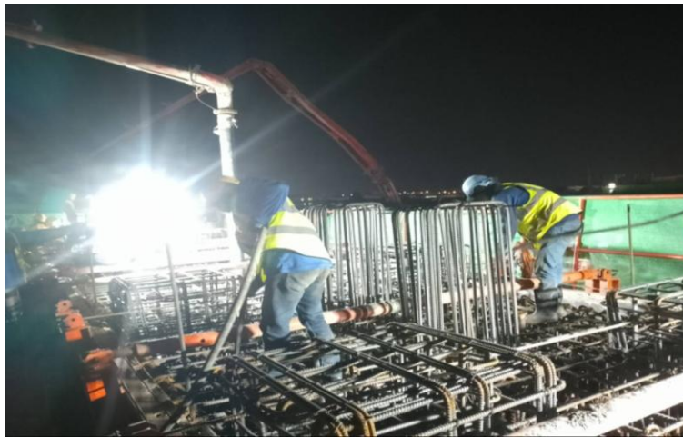
MLP03-23 งานเทคอนกรีต Crossbeam Type IYI-4
