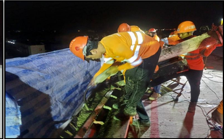
MLP01-09 to MLP01-11 งานเทคอนกรีต Infill Parapet
