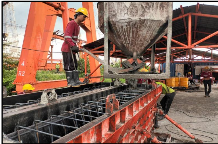
งานหล่อ Precast Central Barrier Zone 1-2 ที่โรงหล่อสระบุรี
