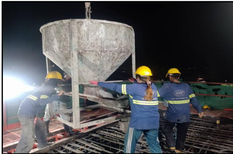
MLP03-15C งานเทคอนกรีต Crossbeam Interface Type PT-44A
