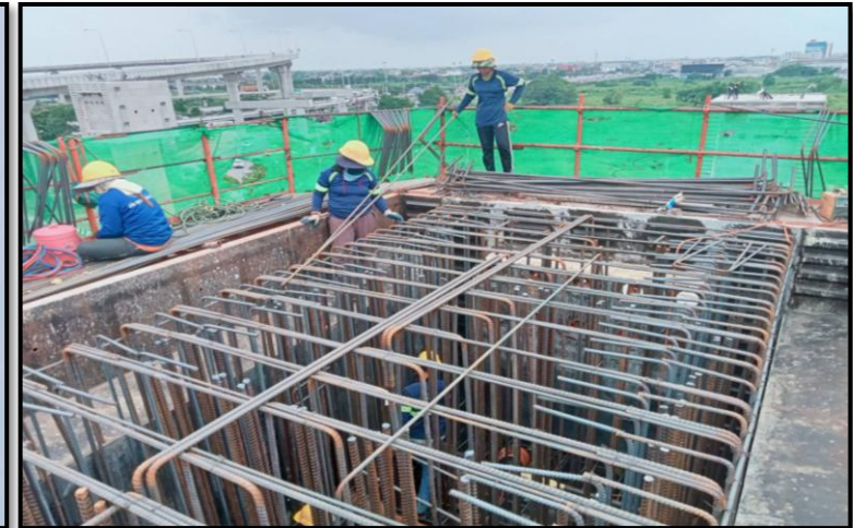
MLP03-16C งานผูกเหล็กเสริม Crossbeam Interface Type PT-44A
