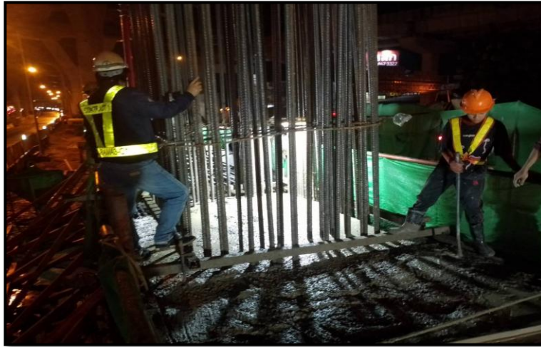
MLP03-01C งานเทคอนกรีต Footing
