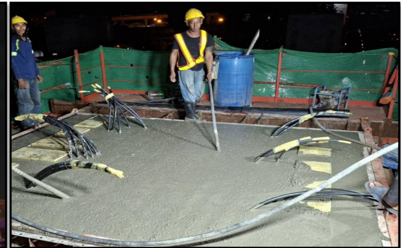
MLP03-16L งานเทคอนกรีต Crossbeam Interface Type PT-44A
