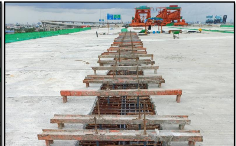
MLP02-17 to MLP02-19 งานผูกเหล็กเสริม Connecting Slab
