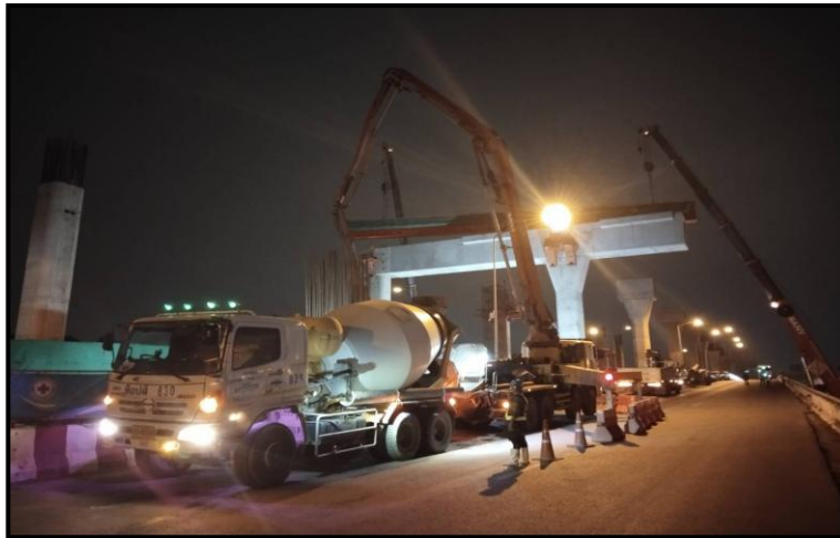
MLP03-02C งานเทคอนกรีต Footing
