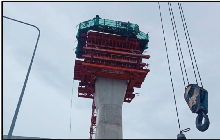
MLP03-16C งานผูกเหล็กเสริม Crossbeam Interface Type PT-44A
