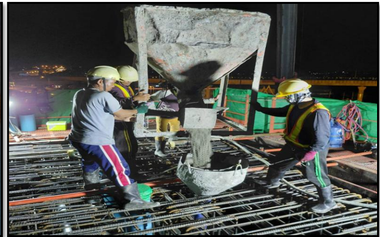
MLP03-06C งานเทคอนกรีต Crossbeam Interface Type PT-44 (Modified)
