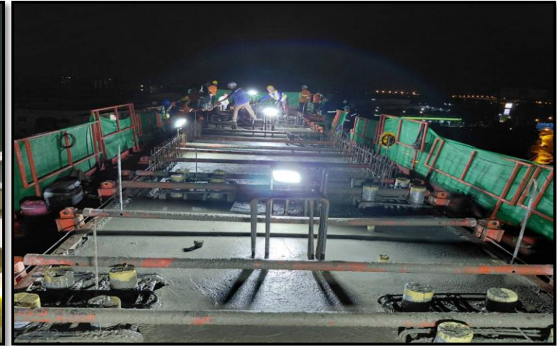
MLP03-18 งานเทคอนกรีต Crossbeam Type YI-2
