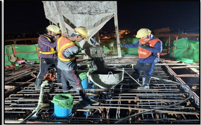
MLP03-07C งานเทคอนกรีต Crossbeam Interface Type PT-44 (Modified)
