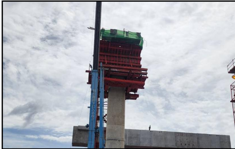
MLP03-16L งานผูกเหล็กเสริม Crossbeam Interface Type PT-44A
