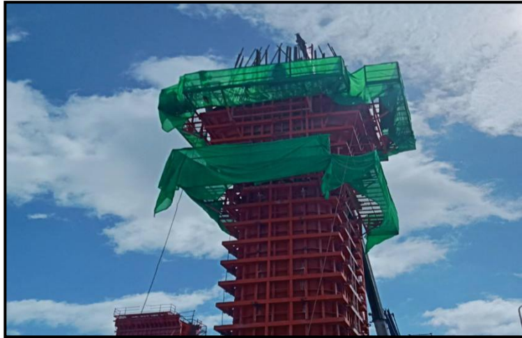
MLP03-01C งานผูกเหล็กเสริม Column Head Type PT-44A
