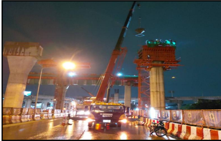
MLP03-04L งานเทคอนกรีต Crossbeam Interface Type PT-44A
