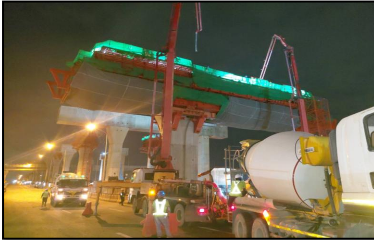
MLP03-18 งานเทคอนกรีต Crossbeam Type YI-2
