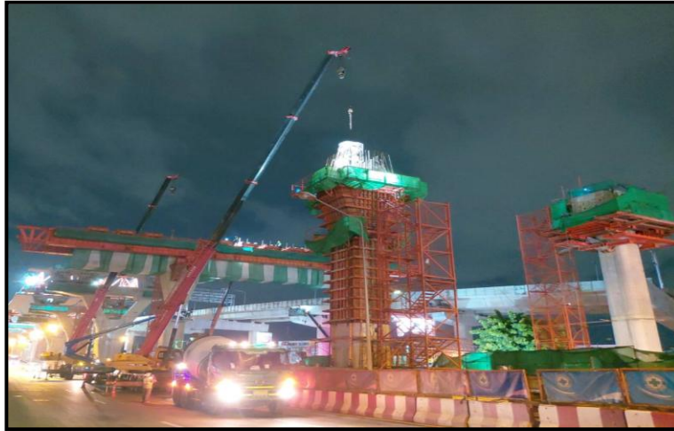
MLP03-01C งานเทคอนกรีต Column Head Type PT-44A
