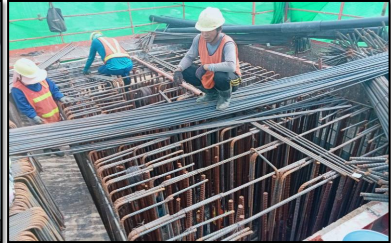
MLP03-07C งานผูกเหล็กเสริม Crossbeam Interface Type PT-44 (Modified)
