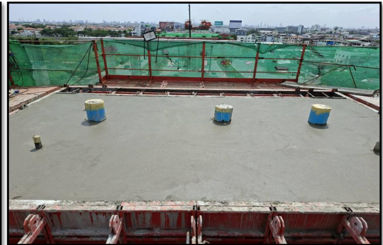
MLP03-15C งานเทคอนกรีต Crossbeam Interface Type PT-44A
