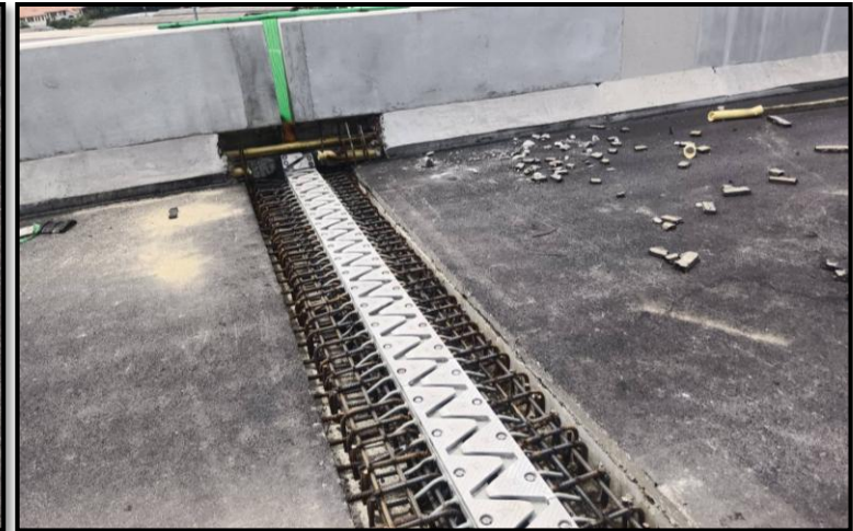
งาน Expansion Joint MLP01-01 to MLP01-09
