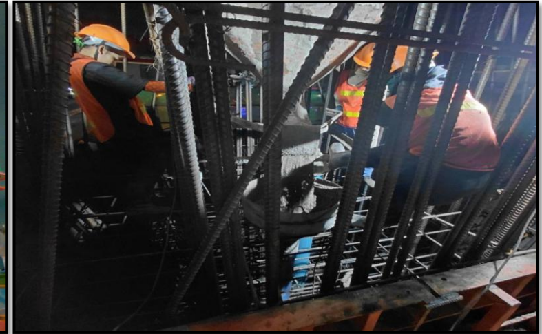
MLP03-01C งานเทคอนกรีต Column Head Type PT-44A
