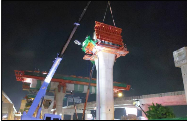
MLP03-01C งานติดตั้ง Form work Crossbeam Interface Type PT-44A
