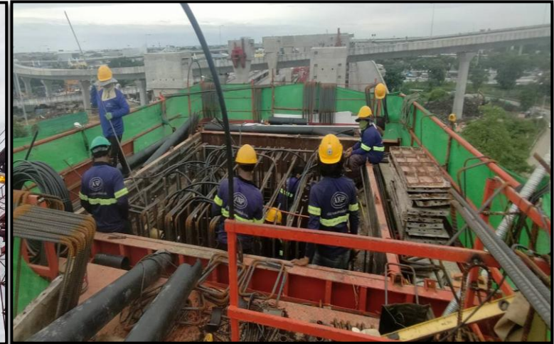
MLP03-16L งานผูกเหล็กเสริม Crossbeam Interface Type PT-44A
