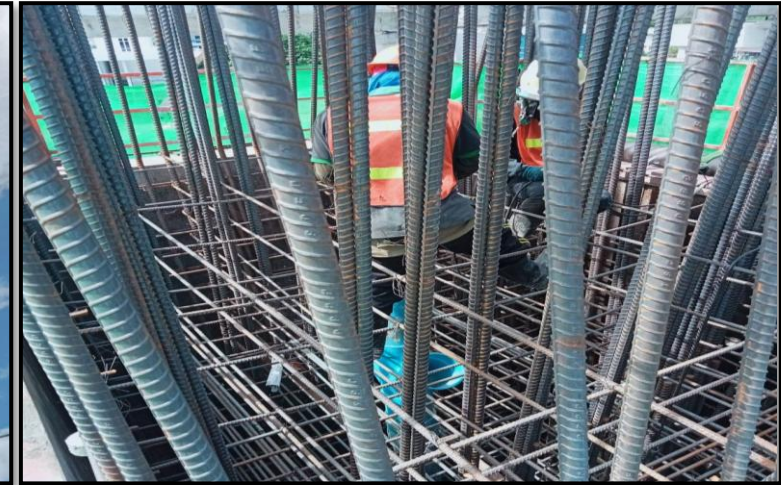
MLP03-01C งานผูกเหล็กเสริม Column Head Type PT-44A
