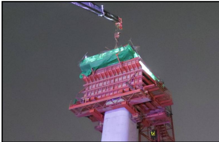
MLP03-02L งานผูกเหล็กเสริม Crossbeam Interface Type PT-44A
