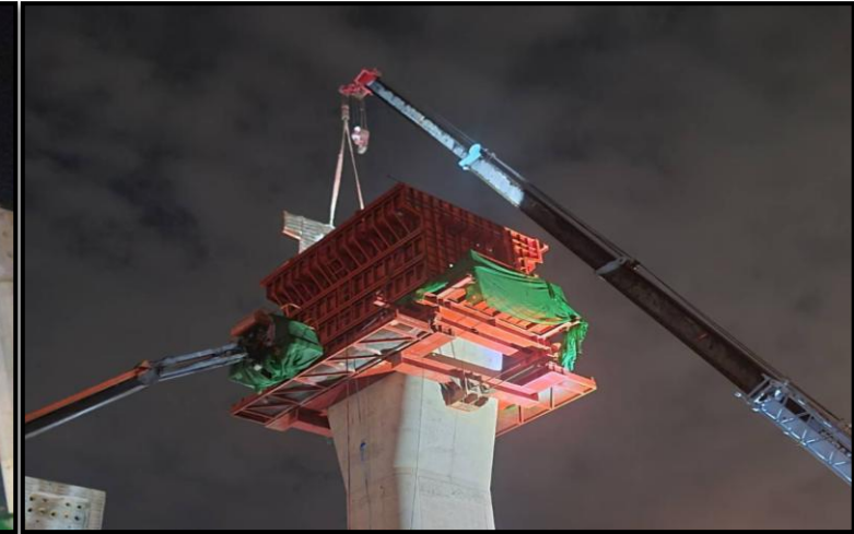
MLP03-01C งานติดตั้ง Form work Crossbeam Interface Type PT-44A
