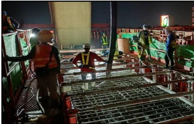
MLP01-07 งานเทคอนกรีต Lower Crossbeam Type YT-1
