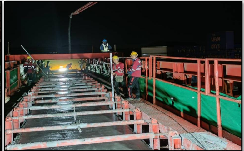
MLP01-07 งานเทคอนกรีต Lower Crossbeam Type YT-1
