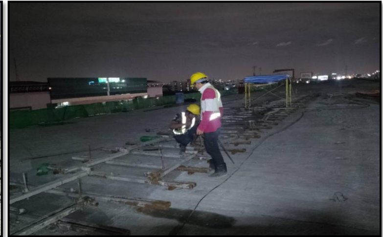
MLP04-03 to MLP04-04 งานผูกเหล็กเสริม Connecting Slab
