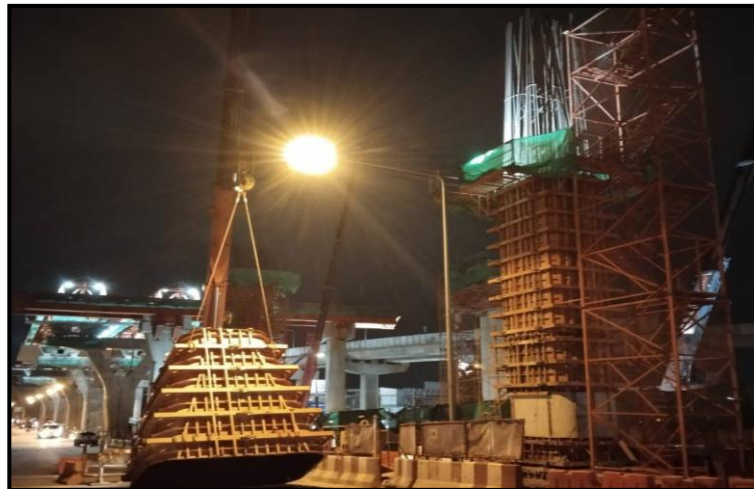
MLP03-02C งานติดตั้ง Form work Column Head Type PT-44A
