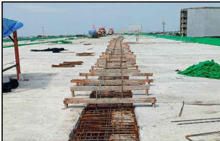
MLP02-17 to MLP02-19 งานผูกเหล็กเสริม Connecting Slab
