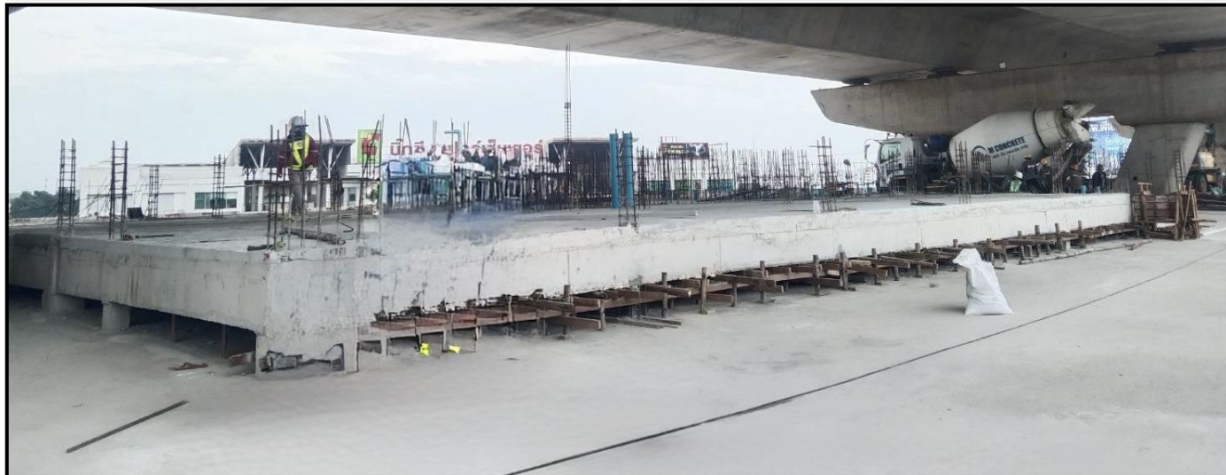
งานก่อสร้างอาคาร Toll Surveillance Building (Ramp 2)
