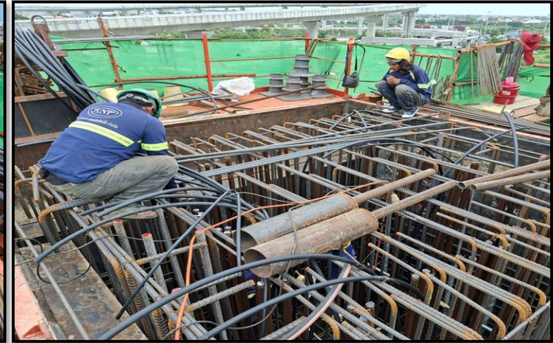
MLP03-15L งานผูกเหล็กเสริม Crossbeam Interface Type PT-44A
