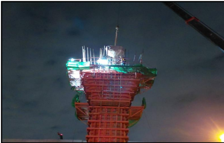
MLP03-02C งานเทคอนกรีต Column Head Type PT-44A
