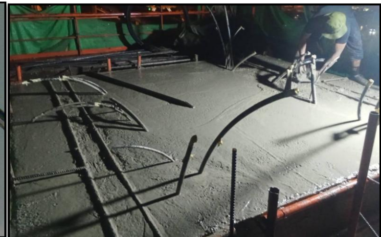
MLP03-01L งานเทคอนกรีต Crossbeam Interface Type PT-44A
