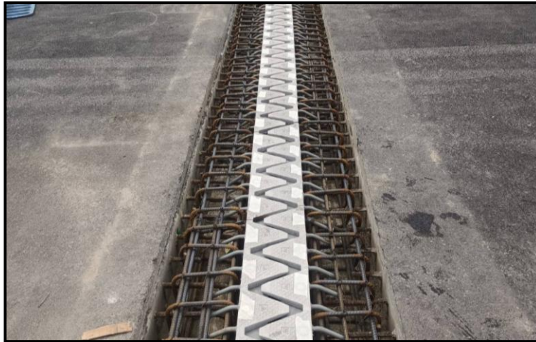
งาน Expansion Joint MLP01-01 to MLP01-09
