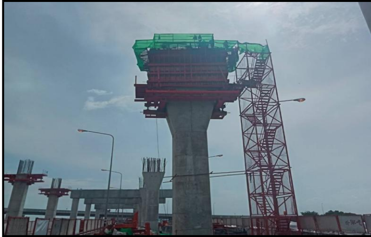
MLP03-07C งานผูกเหล็กเสริม Crossbeam Interface Type PT-44 (Modified)
