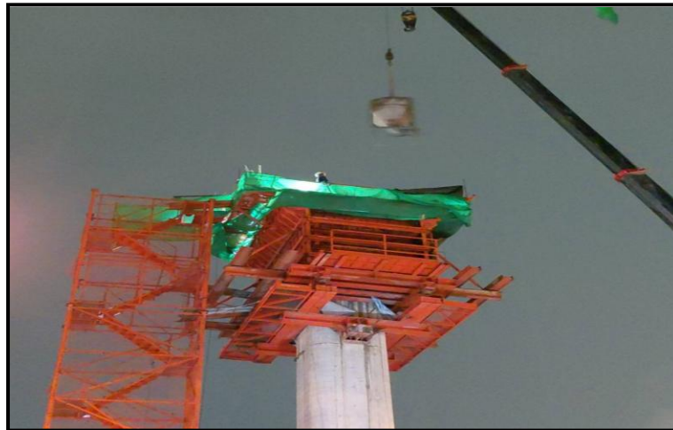
MLP03-01L งานเทคอนกรีต Crossbeam Interface Type PT-44A
