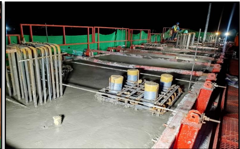
MLP03-19 งานเทคอนกรีต Crossbeam Type YI-2
