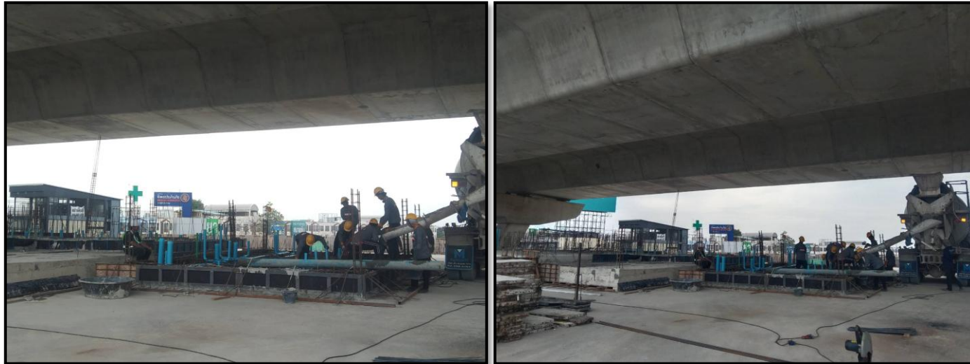
งานก่อสร้างอาคาร Public Toilet (Ramp2)
