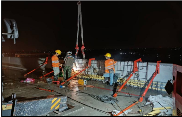
MLP01-22L to MLP01-23L งานยกติดตั้ง Parapet
