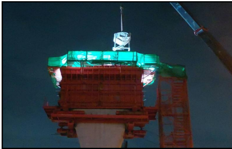
MLP03-06C งานเทคอนกรีต Crossbeam Interface Type PT-44 (Modified)
