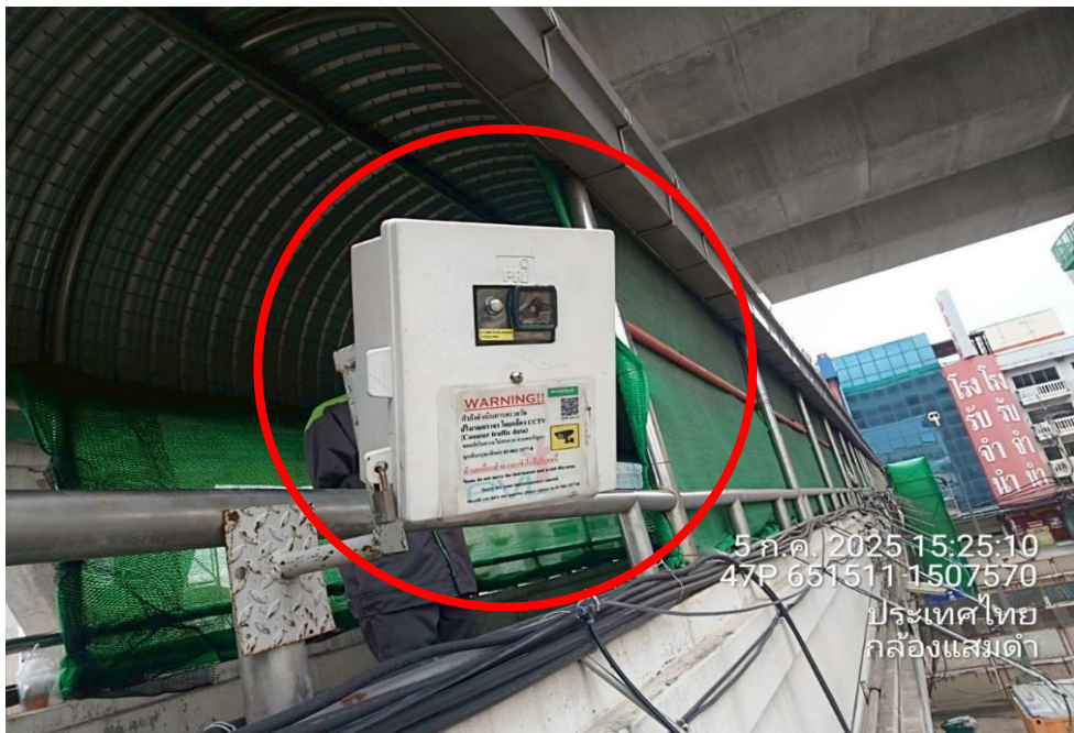
จุดที่ 1 ถนนพระรามที่ 2 บริเวณซอย 82 กม.11+250
