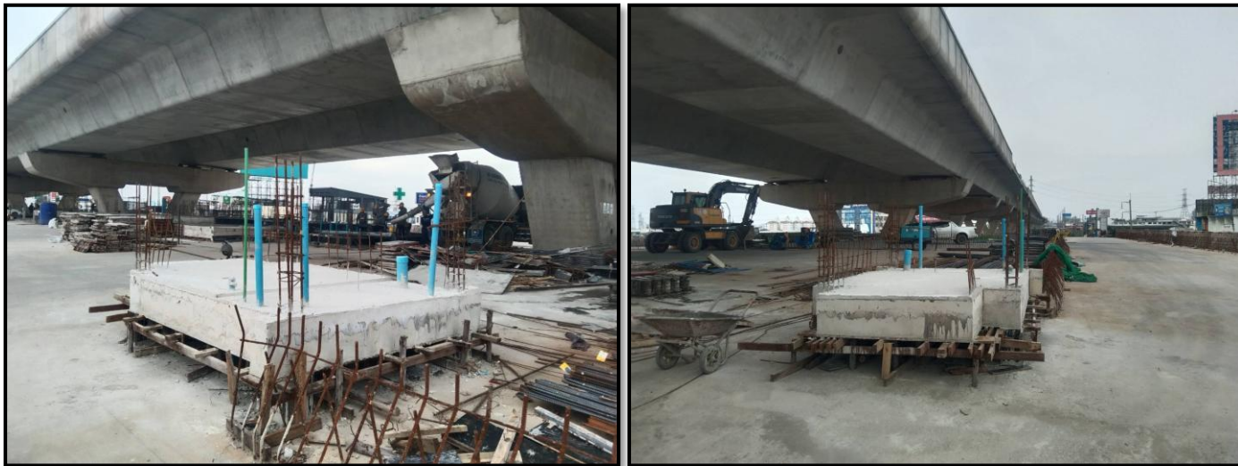
งานก่อสร้างอาคาร Guardhouse (Ramp2)
