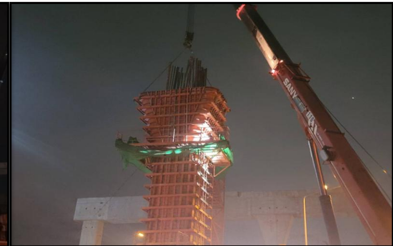
MLP03-02C งานติดตั้ง Form work Column Head Type PT-44A
