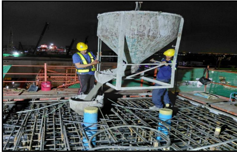
MLP03-16C งานเทคอนกรีต Crossbeam Interface Type PT-44A
