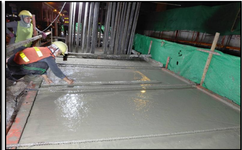
MLP03-02C งานเทคอนกรีต Footing
