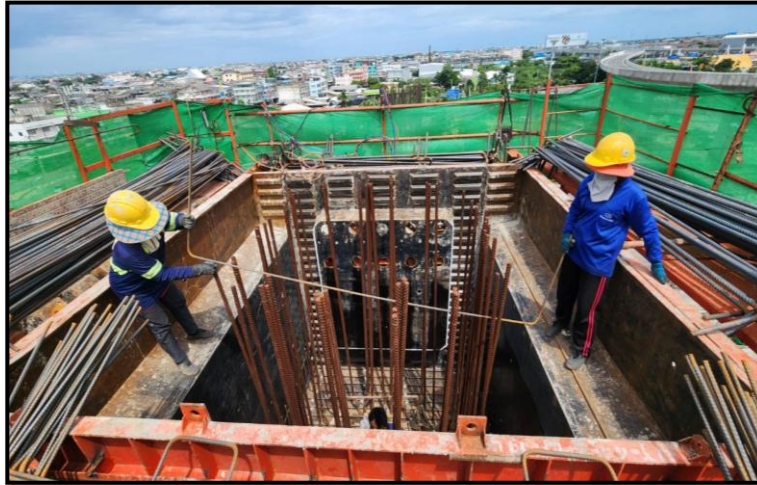
MLP03-15L งานผูกเหล็กเสริม Crossbeam Interface Type PT-44A
