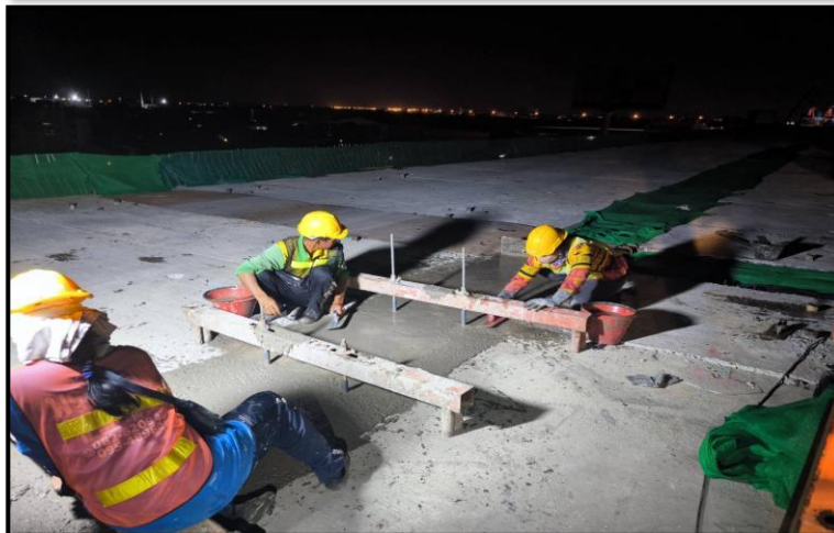
MLP01-27 to MLP01-38 งานเทคอนกรีต Connecting Slab
