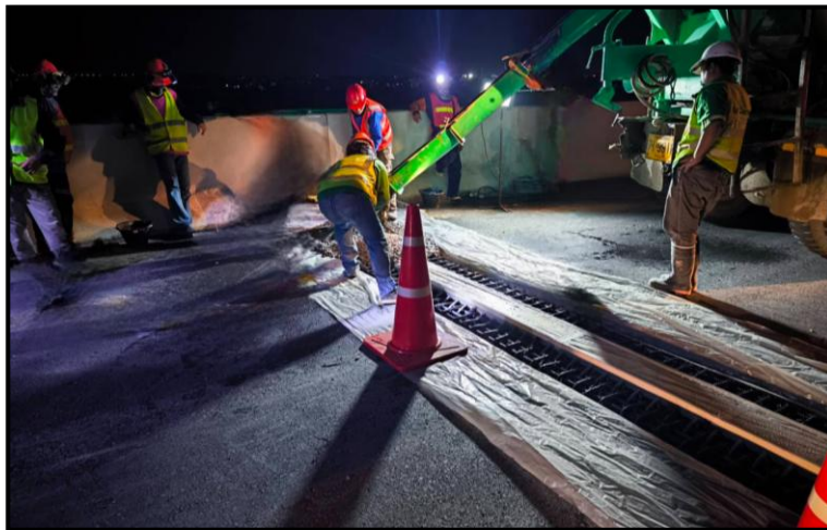
งาน Expansion Joint MLP01-15 to MLP01-19
