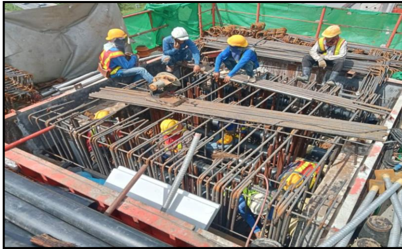
MLP03-08L งานผูกเหล็กเสริม Crossbeam Interface Type PT-44 (Modified)
