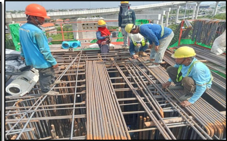
MLP03-01C งานผูกเหล็กเสริม Crossbeam Interface Type PT-44A
