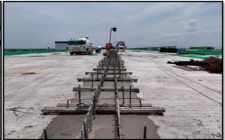
MLP04-02 to MLP04-03 งานเทคอนกรีต Connecting Slab
