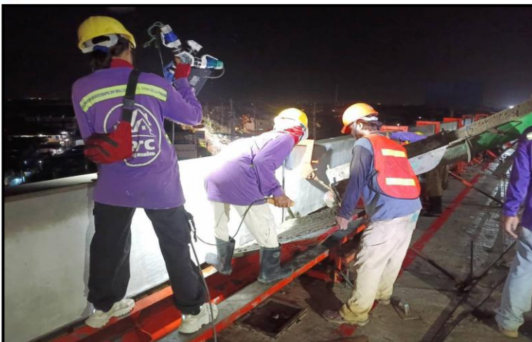
MLP01-24 to MLP01-25 งานเทคอนกรีต Infill Parapet
