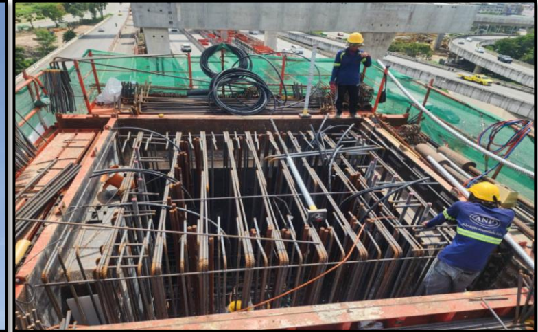
MLP03-09L งานผูกเหล็กเสริม Crossbeam Interface Type PT-44 (Modified)
