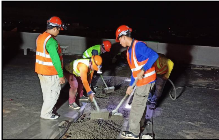
งาน Expansion Joint MLP01-01 to MLP01-09
