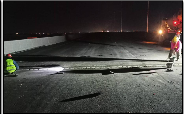
งาน Expansion Joint MLP01-01 to MLP01-09
