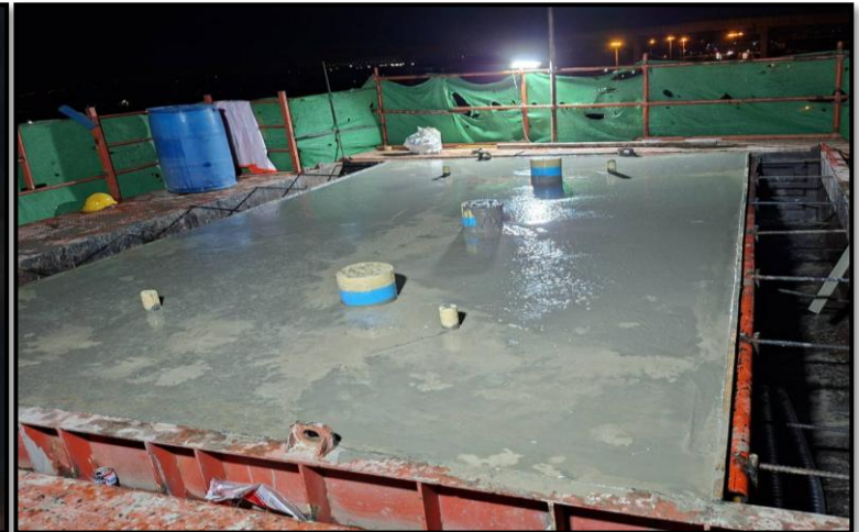
MLP03-09C งานเทคอนกรีต Crossbeam Interface PT-44 (Modified)
