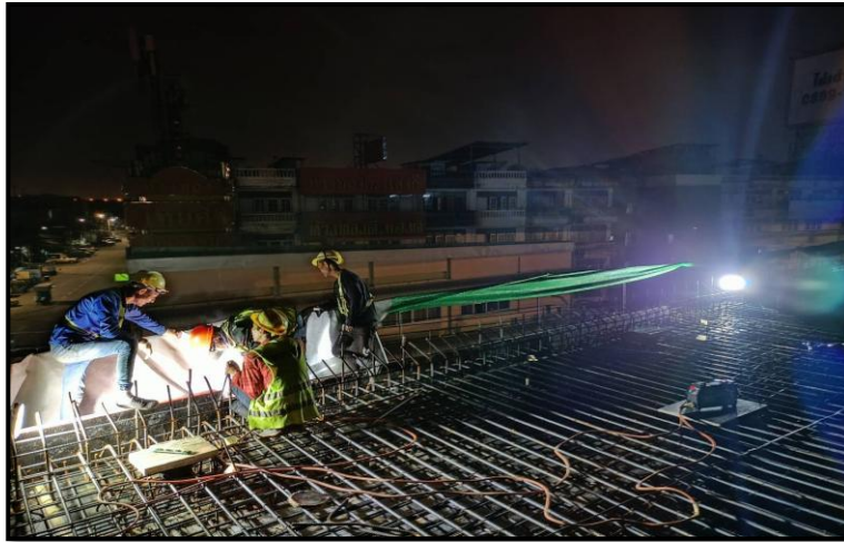
ROF2-04 to ROF2-05 งานเข้าแบบพื้น Deck Slab
