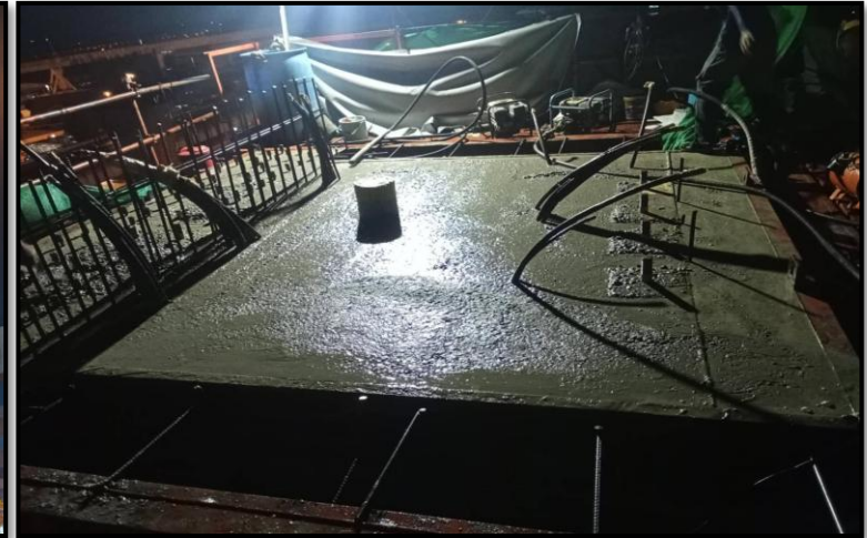
MLP03-09L งานเทคอนกรีต Crossbeam Interface Type PT-44 (Modified)
