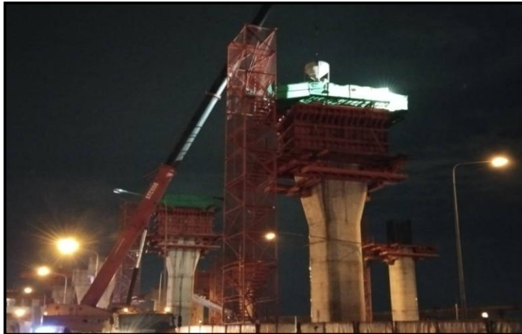
MLP03-09C งานเทคอนกรีต Crossbeam Interface PT-44 (Modified)
