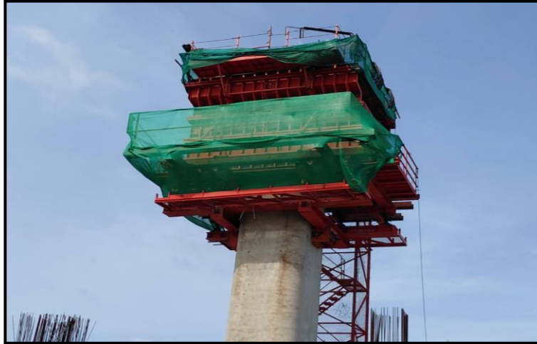
MLP03-09L งานผูกเหล็กเสริม Crossbeam Interface Type PT-44 (Modified)
