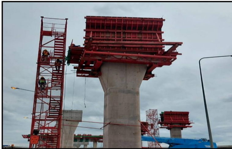
MLP03-08C งานผูกเหล็กเสริม Crossbeam Interface PT-44 (Modified)
