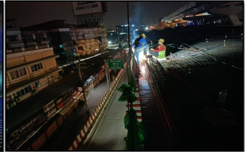
ROF2-04 to ROF2-05 งานเข้าแบบพื้น Deck Slab
