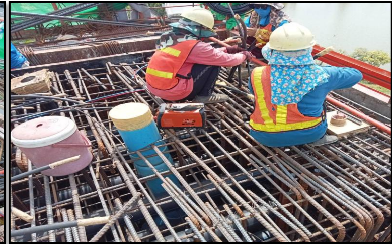
MLP03-07L งานผูกเหล็กเสริม Crossbeam Interface PT-44 (Modified)
