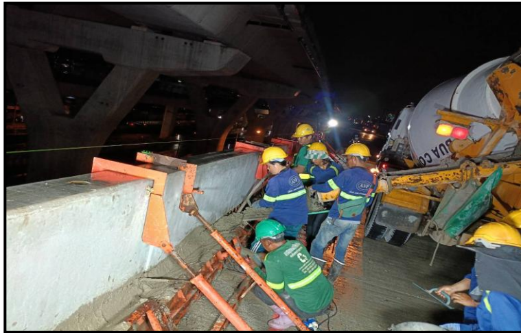
RON2-22 to RON2-23 งานเทคอนกรีต Infill Parapet
