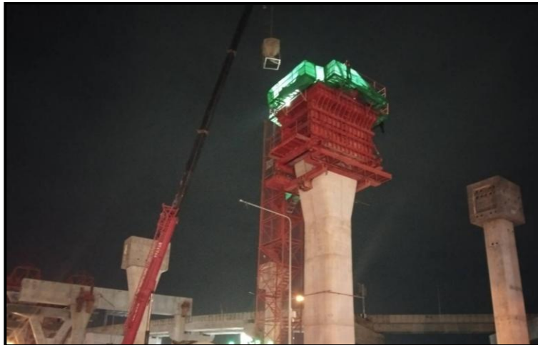
MLP03-02C งานเทคอนกรีต Crossbeam Interface PT-44A
