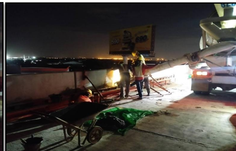
ROF1-04 to ROF1-05 งานเทคอนกรีต Infill Parapet
