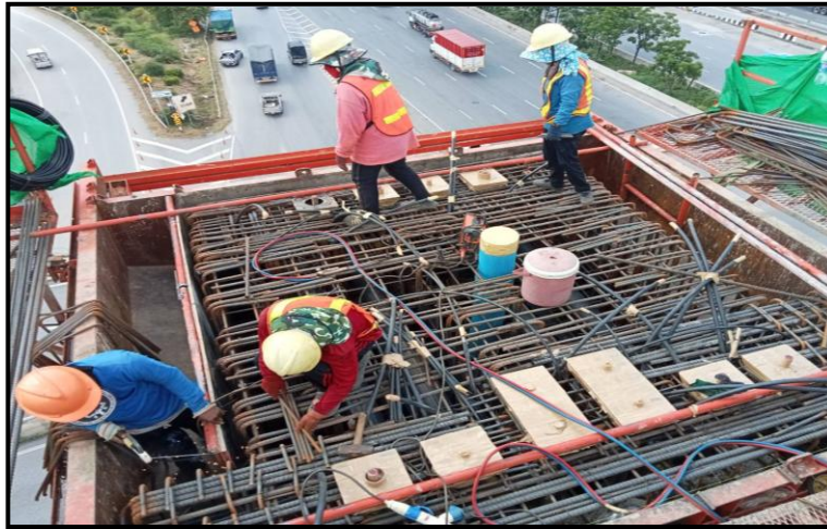
MLP03-07L งานผูกเหล็กเสริม Crossbeam Interface PT-44 (Modified)
