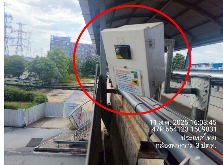
จุดที่ 2 ถนนพระรามที่ 2 บริเวณหน้าโครงการ Origins Rama 2 กม.7+737
