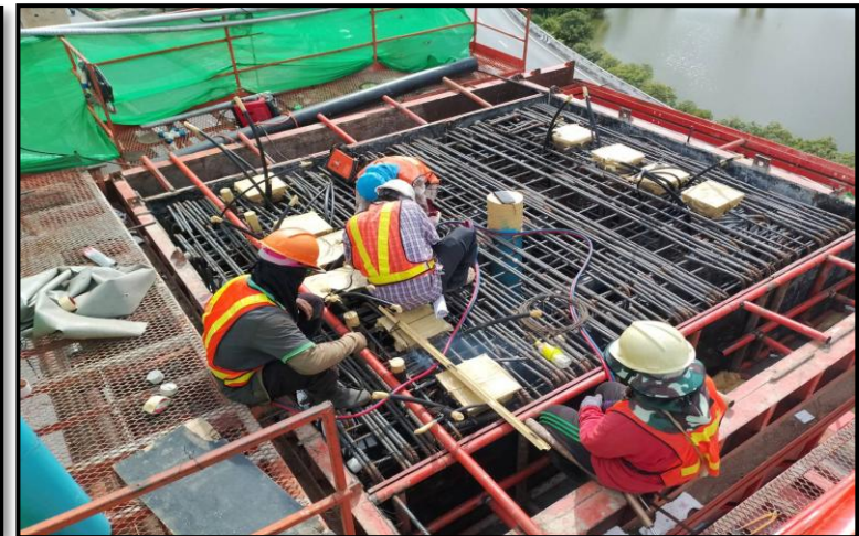
MLP03-06L งานผูกเหล็กเสริม Crossbeam Interface Type PT-44 (Modified)
