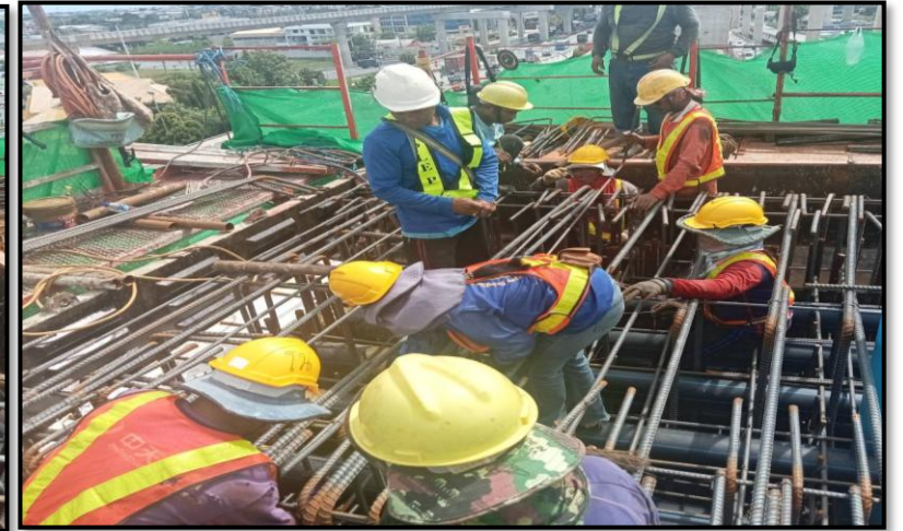
MLP03-08C งานผูกเหล็กเสริม Crossbeam Interface Type PT-44 (Modified)
