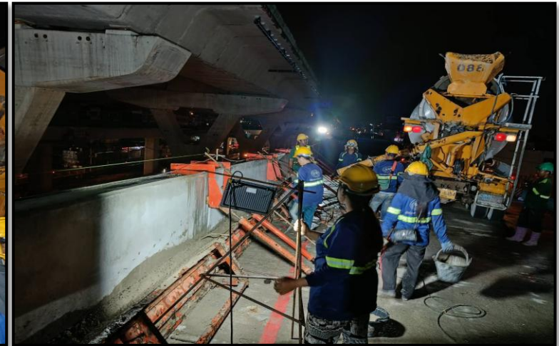
RON2-22 to RON2-23 งานเทคอนกรีต Infill Parapet
