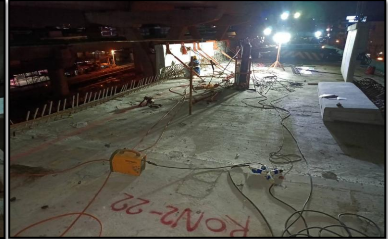
RON2-22 to RON2-23 งานติดตั้ง Parapet
