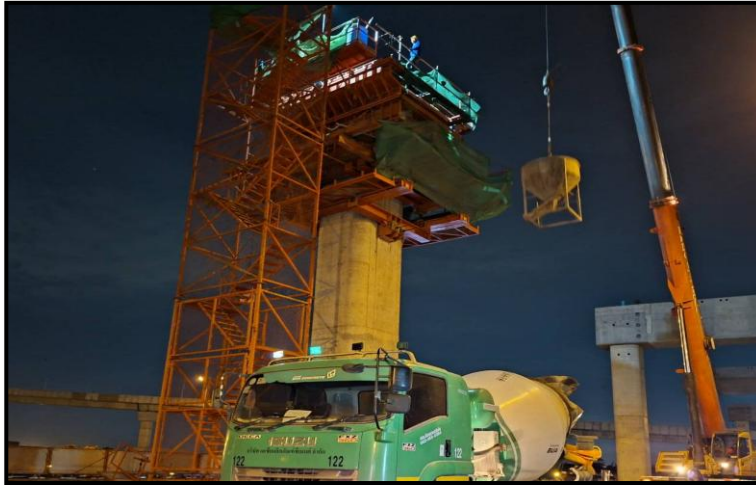
MLP03-09L งานเทคอนกรีต Crossbeam Interface Type PT-44 (Modified)
