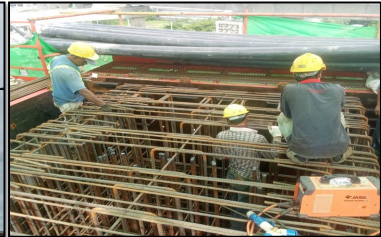
MLP03-08C งานผูกเหล็กเสริม Crossbeam Interface PT-44 (Modified)
