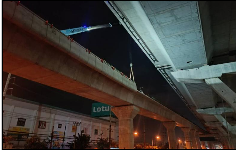
RON2-22 to RON2-23 งานติดตั้ง Parapet
