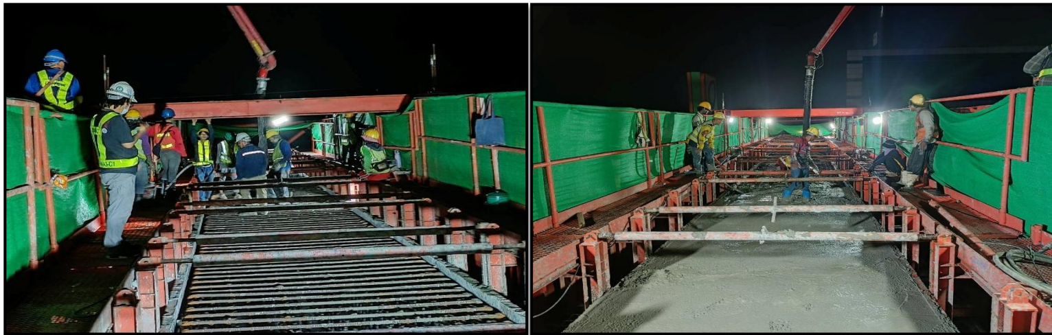
MLP01-09 งานเทคอนกรีต Lower Crossbeam Type YT-1
