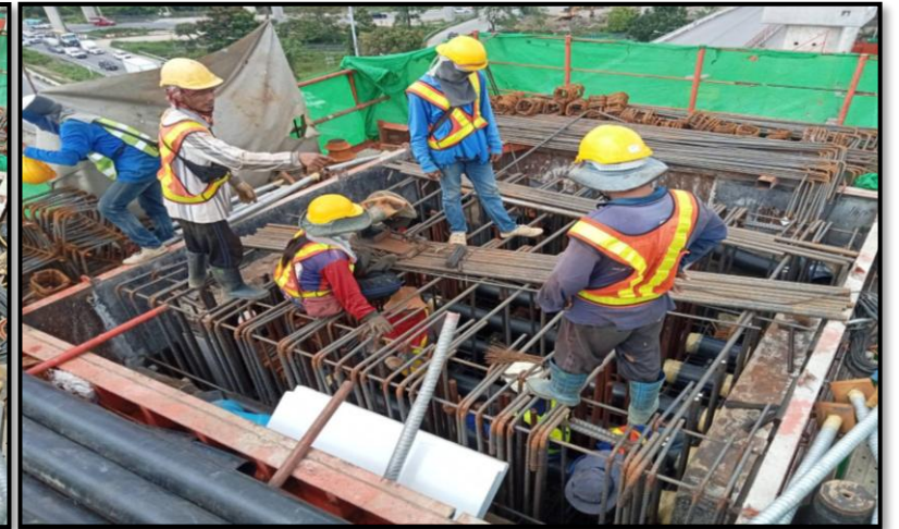
MLP03-08L งานผูกเหล็กเสริม Crossbeam Interface Type PT-44 (Modified)
