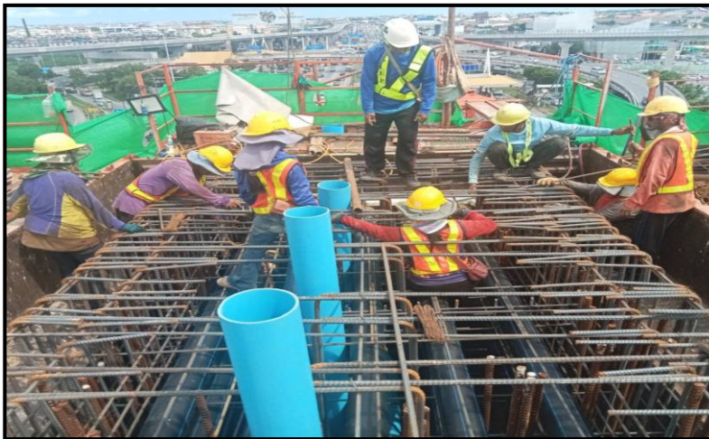
MLP03-08C งานผูกเหล็กเสริม Crossbeam Interface Type PT-44 (Modified)
