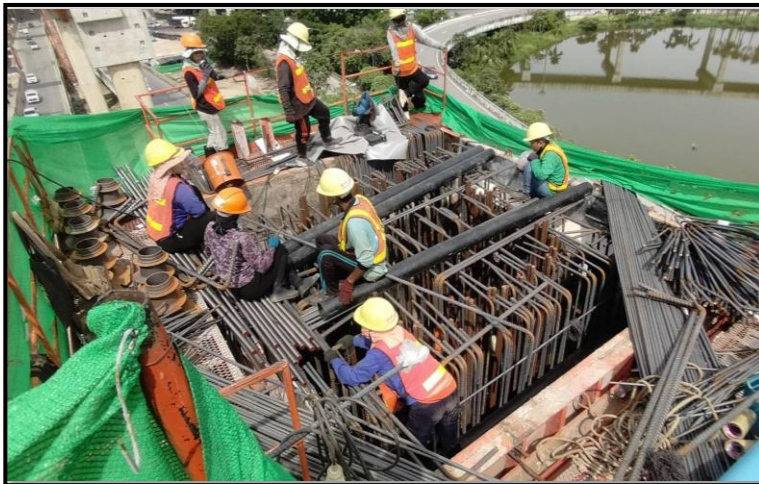
MLP03-06L งานผูกเหล็กเสริม Crossbeam Interface Type PT-44 (Modified)
