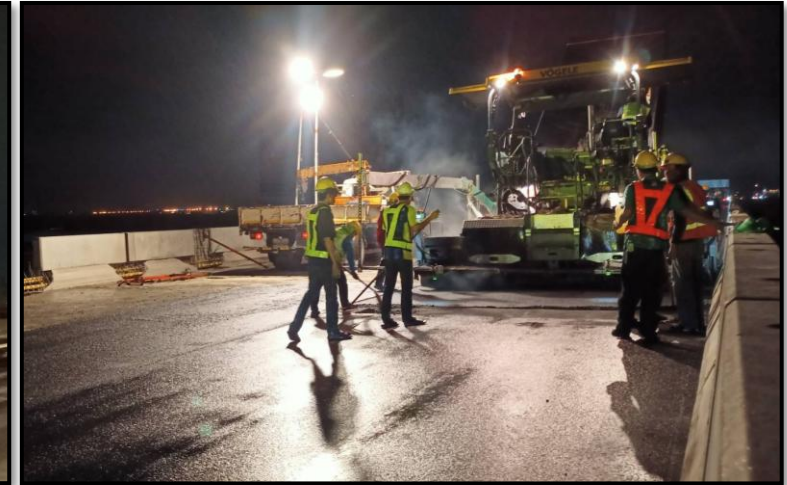
งาน Asphaltic Concrete Pavement MLP02-09 to MLP02-20
