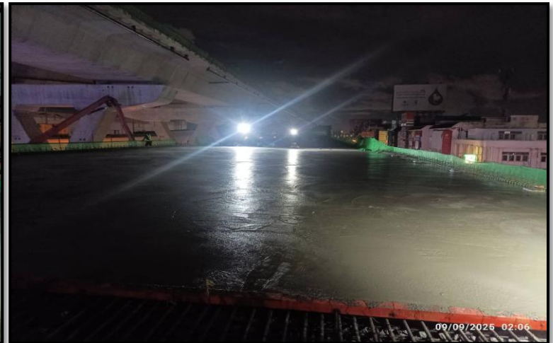
ROF2-09 to ROF2-10 งานเทคอนกรีตDeck Slab
