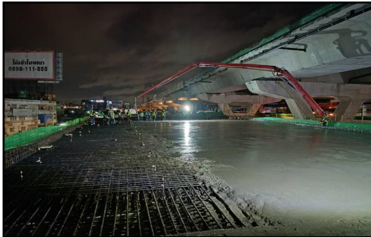
ROF2-09 to ROF2-10 งานเทคอนกรีตDeck Slab
