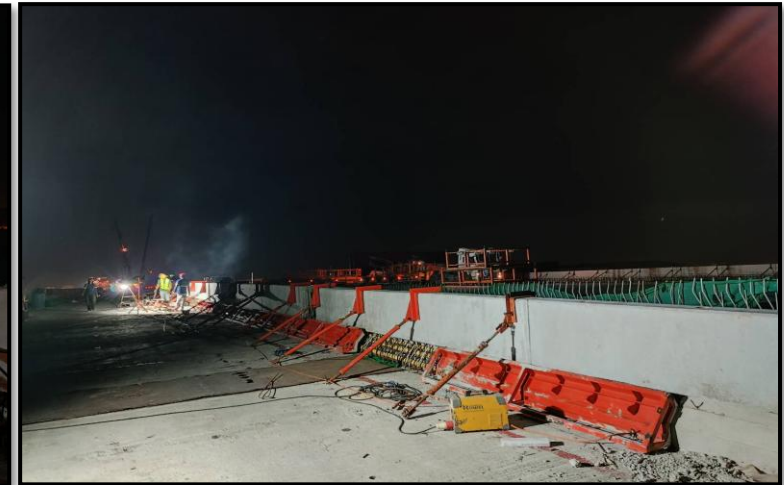
MLP03-27 to MLP03-28 งานติดตั้ง Parapet
