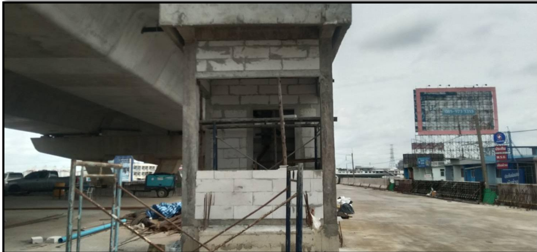
งานก่อสร้างอาคาร Guardhouse (Ramp2)
