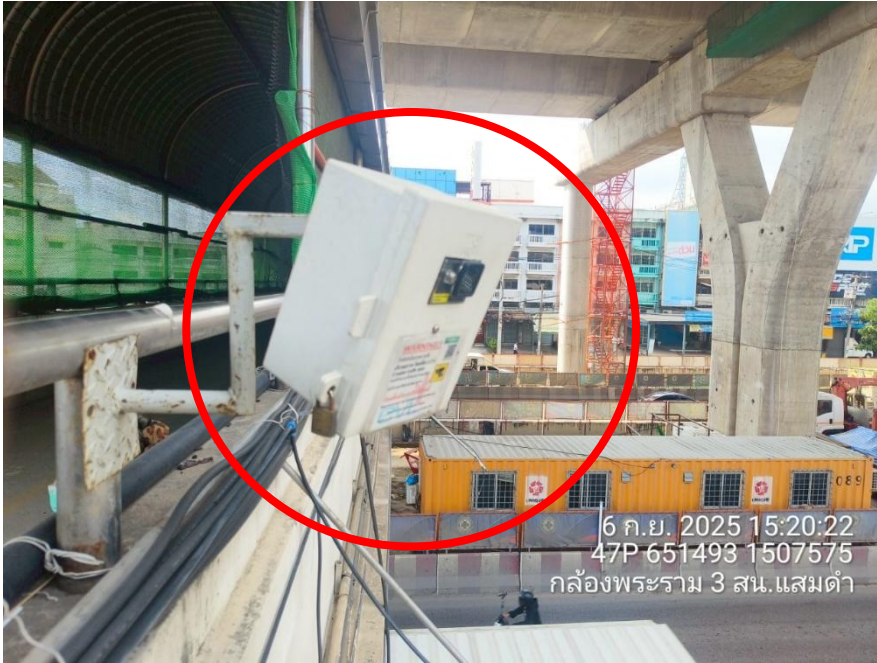
จุดที่ 1 ถนนพระรามที่ 2 บริเวณซอย 82 กม.11+250
