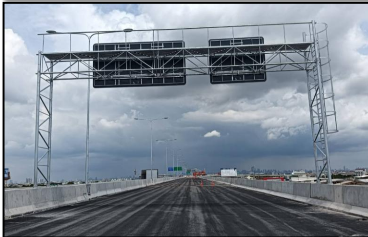
งานติดตั้ง Overhead Traffic Signs MLP01-25 to MLP02-19
