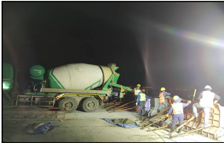
ROF1-04 to ROF1-05 Infill Concrete Precast Edge Parapet
