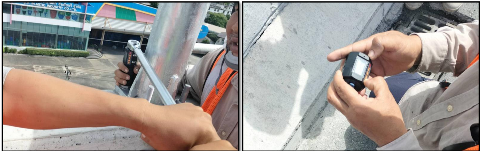
งานทดสอบ Torque ของโครงป้ายและงานป้าย MLP01-25 to MLP02-19
