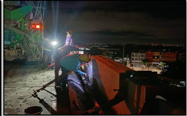
ROF1-03 to ROF1-04 Infill Concrete Precast Edge Parapet
