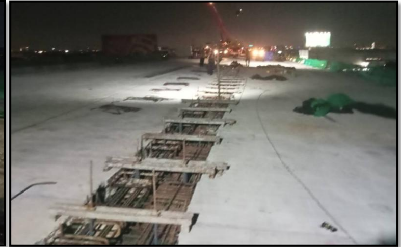
MLP03-26R to MLP04-01R งานผูกเหล็กเสริม Connecting Slab
