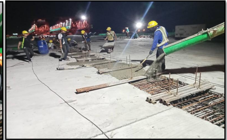
MLP03-26R to MLP03-27R งานเทคอนกรีต Connecting Slab
