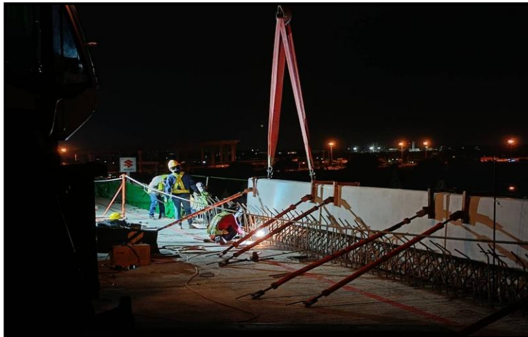
MLP03-27 to MLP03-28 งานติดตั้ง Parapet
