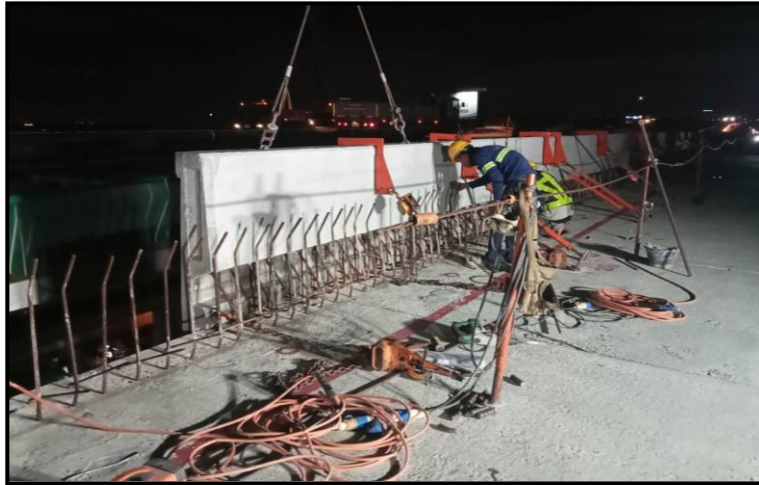
RON2-26R to RON2-27R งานติดตั้ง Parapet
