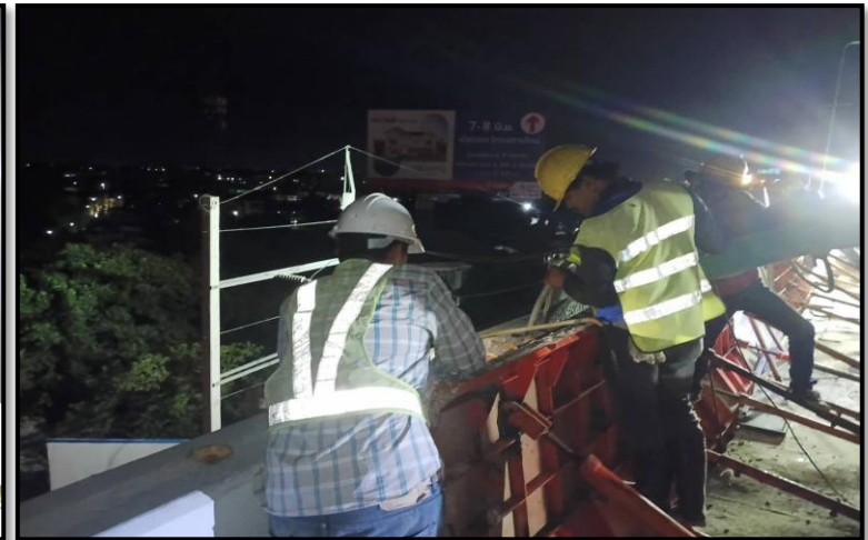
ROF1-04 to ROF1-05 Infill Concrete Precast Edge Parapet
