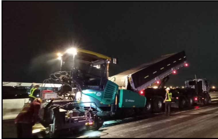
งาน Asphaltic Concrete Pavement MLP02-09 to MLP02-20
