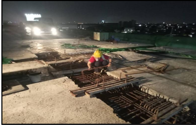
MLP03-26R to MLP04-01R งานผูกเหล็กเสริม Connecting Slab
