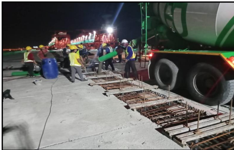
MLP03-26R to MLP03-27R งานเทคอนกรีต Connecting Slab
