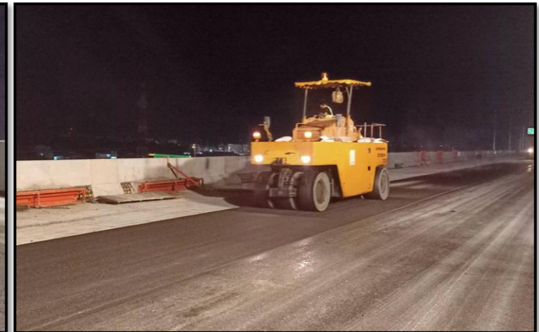
งาน Compacting Concrete Pavement MLP02-09 to MLP02-20
