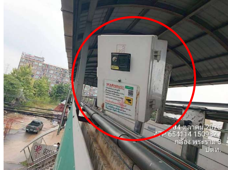
จุดที่ 1 ถนนพระรามที่ 2 บริเวณหน้าโครงการ Origins Rama2 กม.7+737
