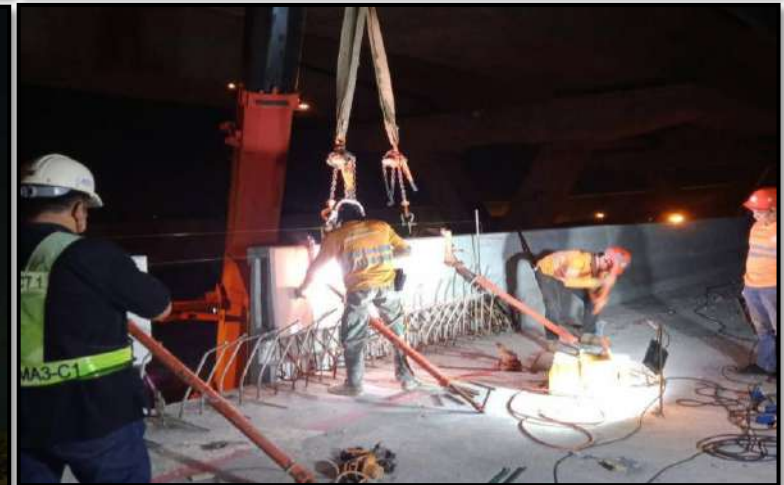
ROF1-08 to ROF1-09 Install Precast Edge Parapet
