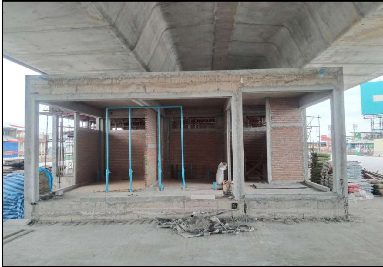
งานก่อสร้างอาคาร Public Toilet (Ramp2)
