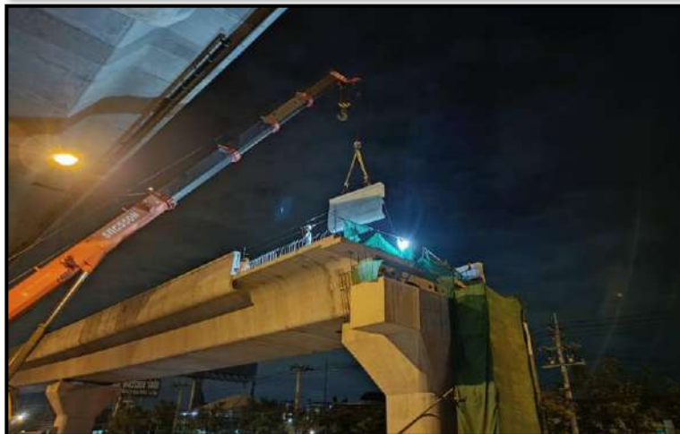
ROF1-08 to ROF1-09 Install Precast Edge Parapet
