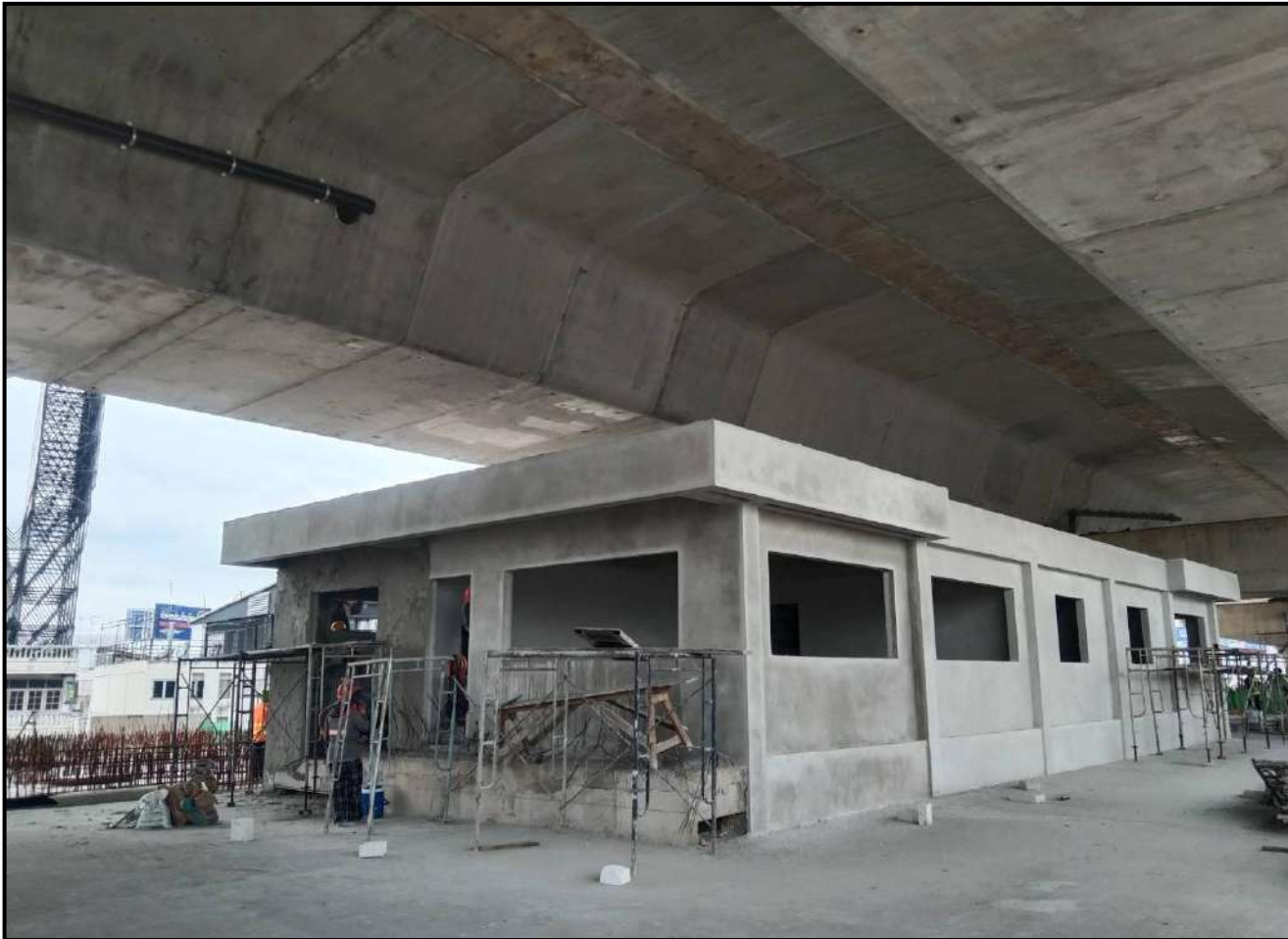
งานก่อสร้างอาคาร Rescue Substation Building (Ramp 2)
