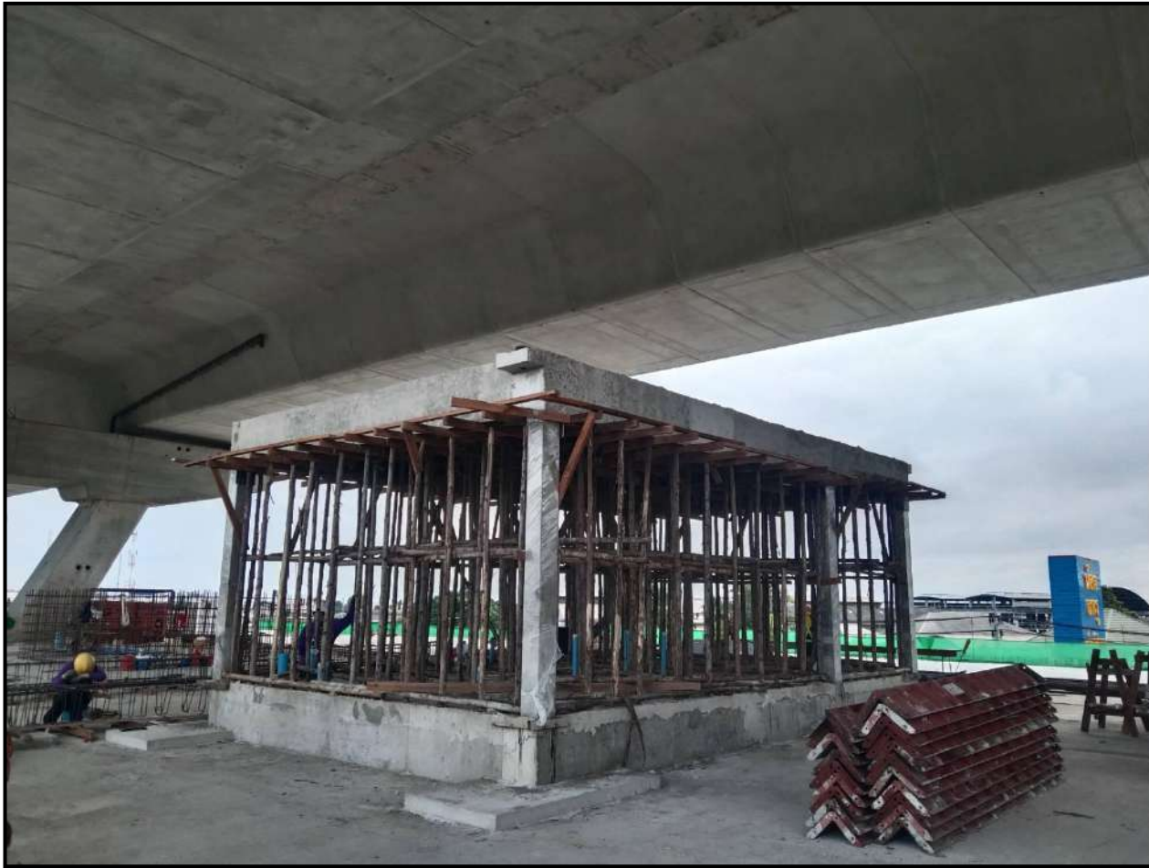
งานก่อสร้างอาคาร Public Toilet (Ramp 1)
