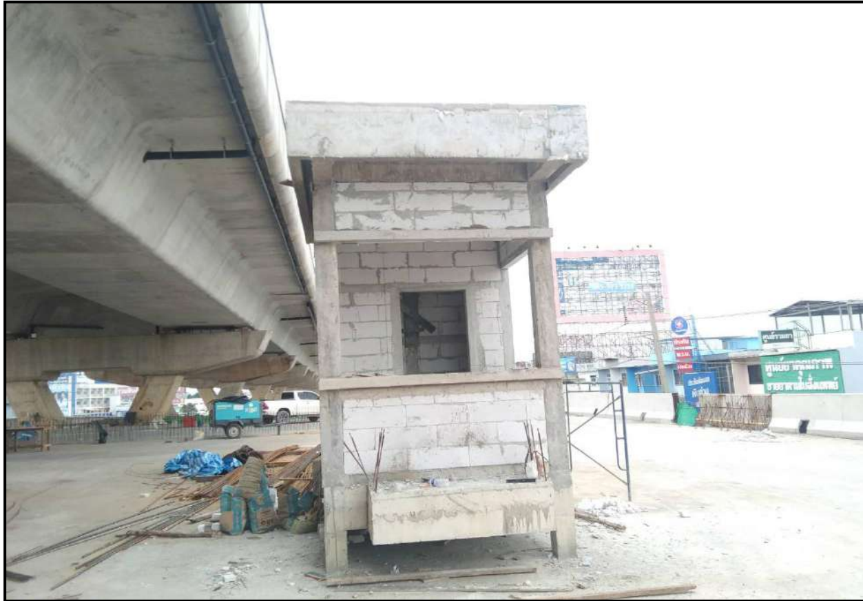
งานก่อสร้างอาคาร Guardhouse (Ramp2)
