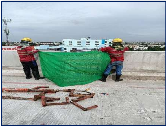
ดำเนินการติดตั้งตาข่ายป้องกันวัสดุตกหล่น
