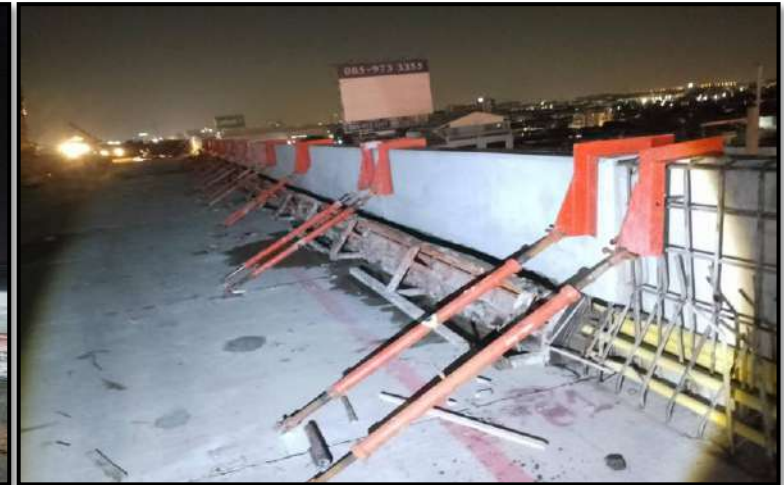
MLP03-23 to MLP03-24 งานเทคอนกรีต Infill Parapet
