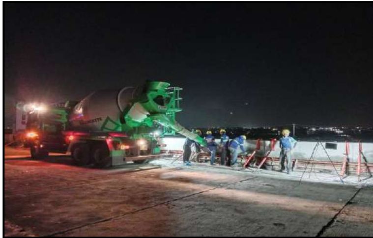
MLP03-23 to MLP03-24 งานเทคอนกรีต Infill Parapet
