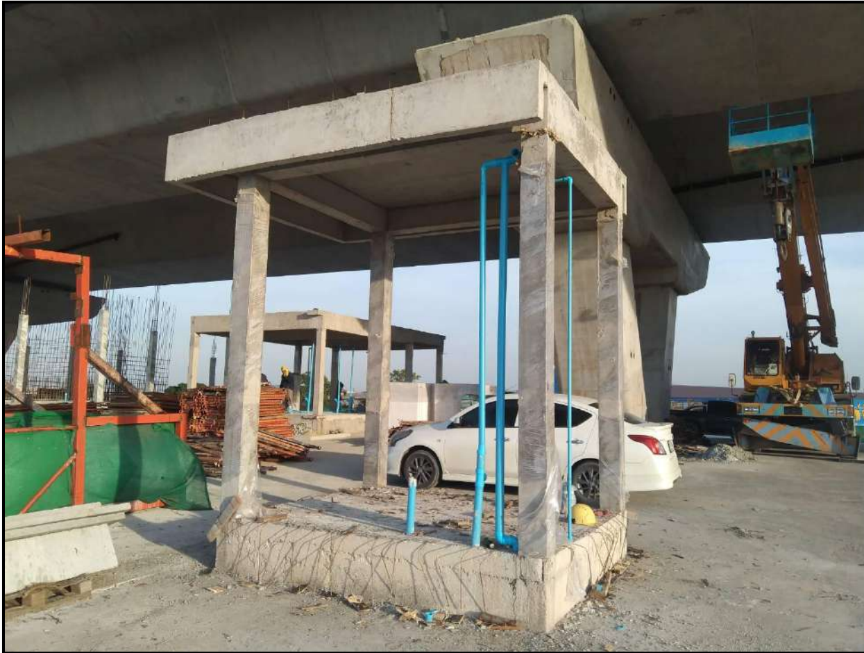
งานก่อสร้างอาคาร Guardhouse (Ramp 1)
