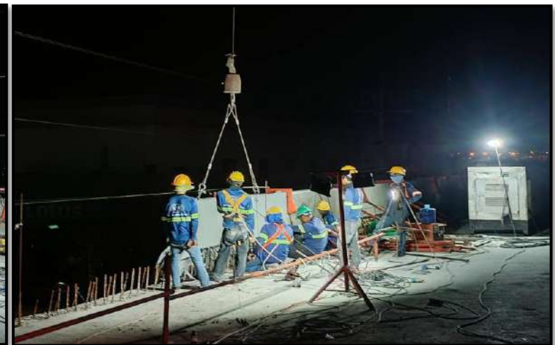
RON2-20 to RON2-21 งานยกติดตั้ง Parapet
