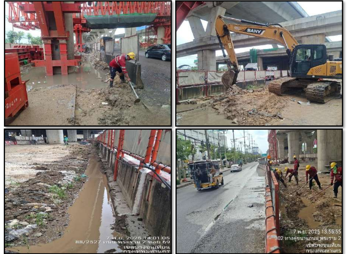
ดำเนินการขุดทำร่องน้ำในบริเวณพื้นที่ก่อสร้าง
