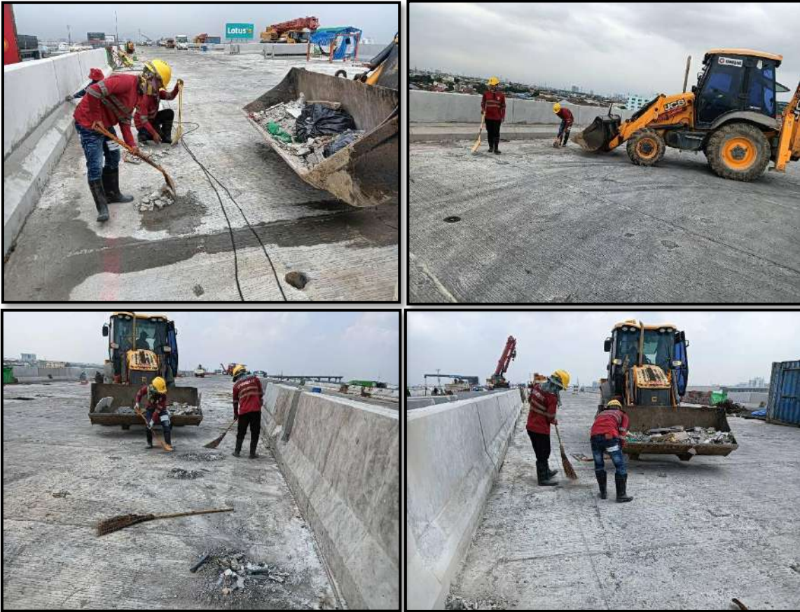
ดำเนินการทำความสะอาดพื้นที่ก่อสร้างด้านบน
