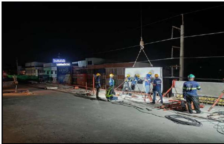
RON2-20 to RON2-21 งานยกติดตั้ง Parapet
