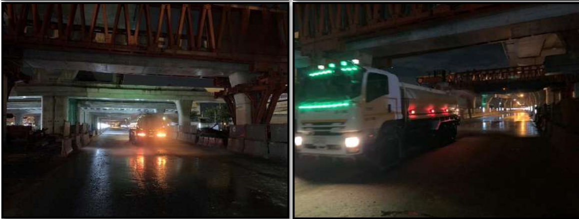
ดำเนินการสเปรย์ล้างทำความสะอาดถนนหลังเลิกงาน
