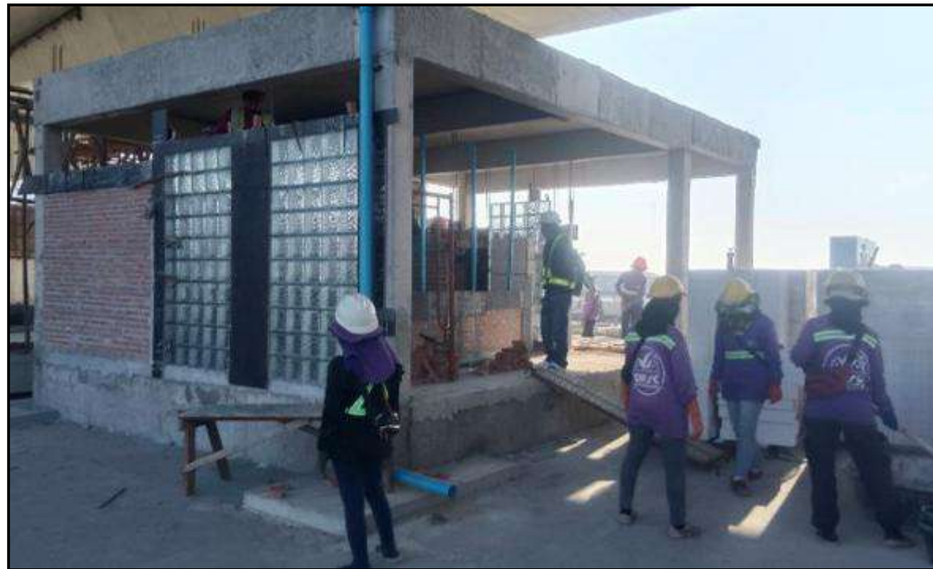
งานก่อสร้างอาคาร Public Toilet (Ramp 1)
