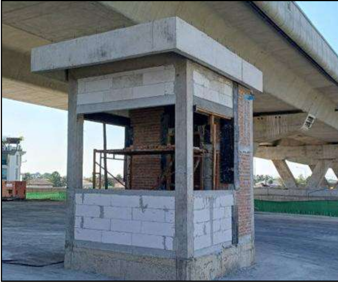
งานก่อสร้างอาคาร Guardhouse (Ramp 1)
