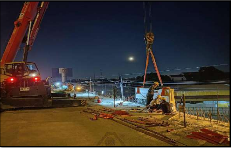
MLP01-07 to MLP01-08 Insall Precast Edge Parapet
