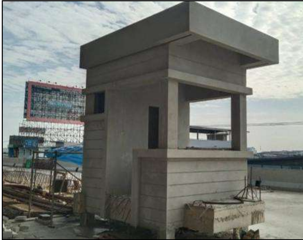
งานก่อสร้างอาคาร Guardhouse (Ramp2)
