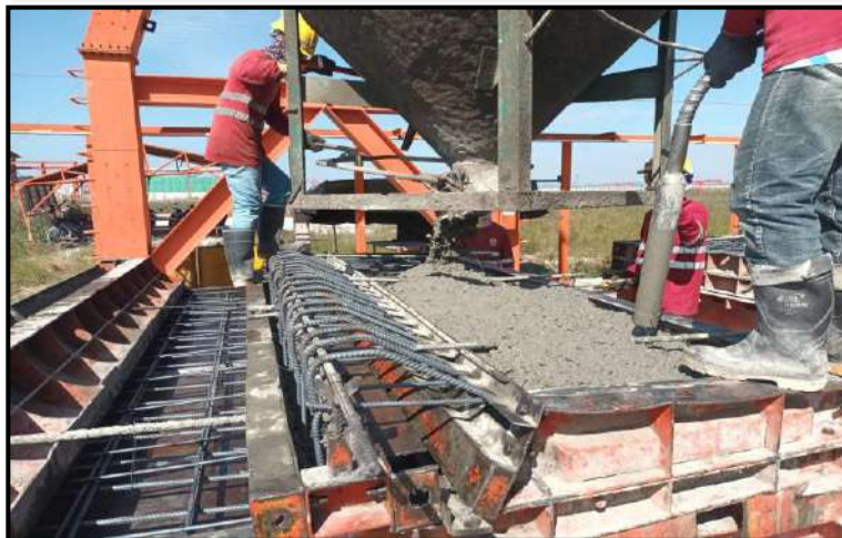
Install Reinforcement and Pouring Concrete Parapet Zone 1-2 ที่โรงหล่อสระบุรี
