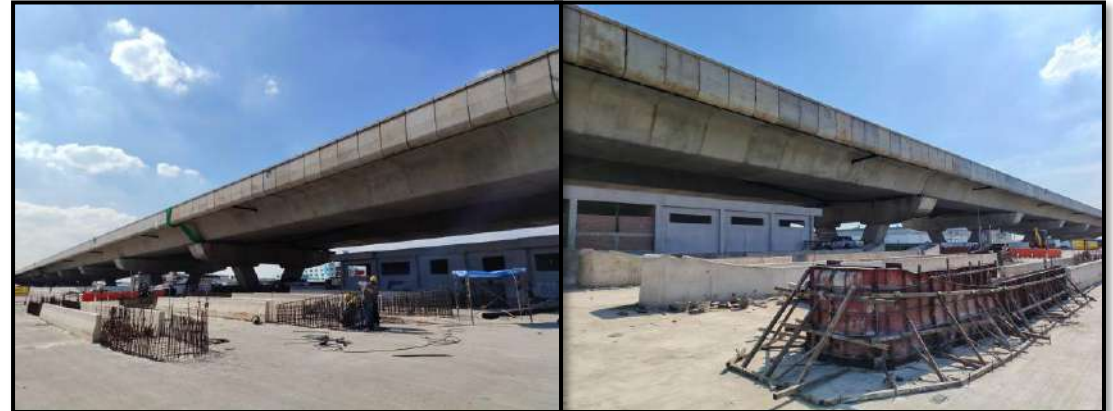
Toll Canopy - ด้านบางขุนเทียน
