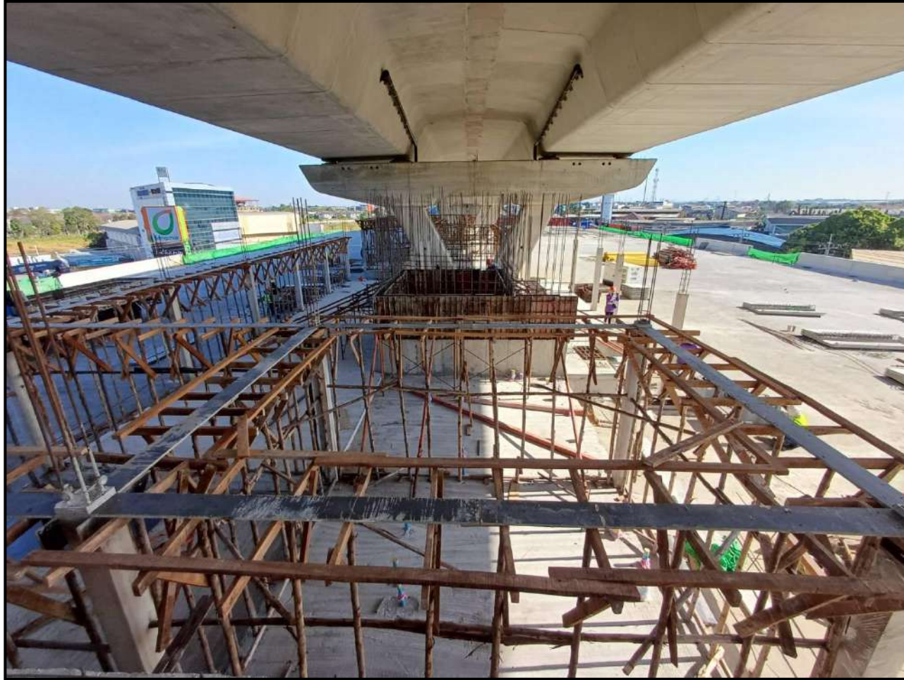
งานก่อสร้างอาคาร Toll Surveillance Building (Ramp 1)
