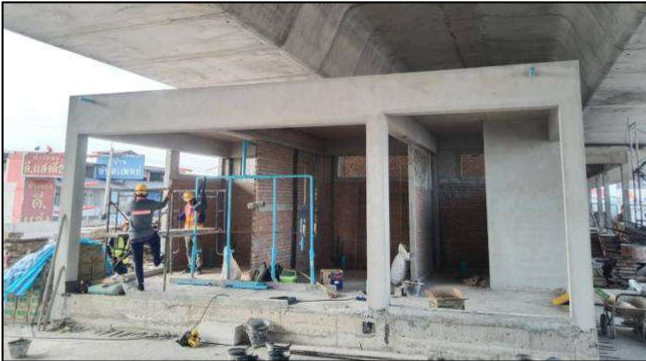
งานก่อสร้างอาคาร Public Toilet (Ramp2)
