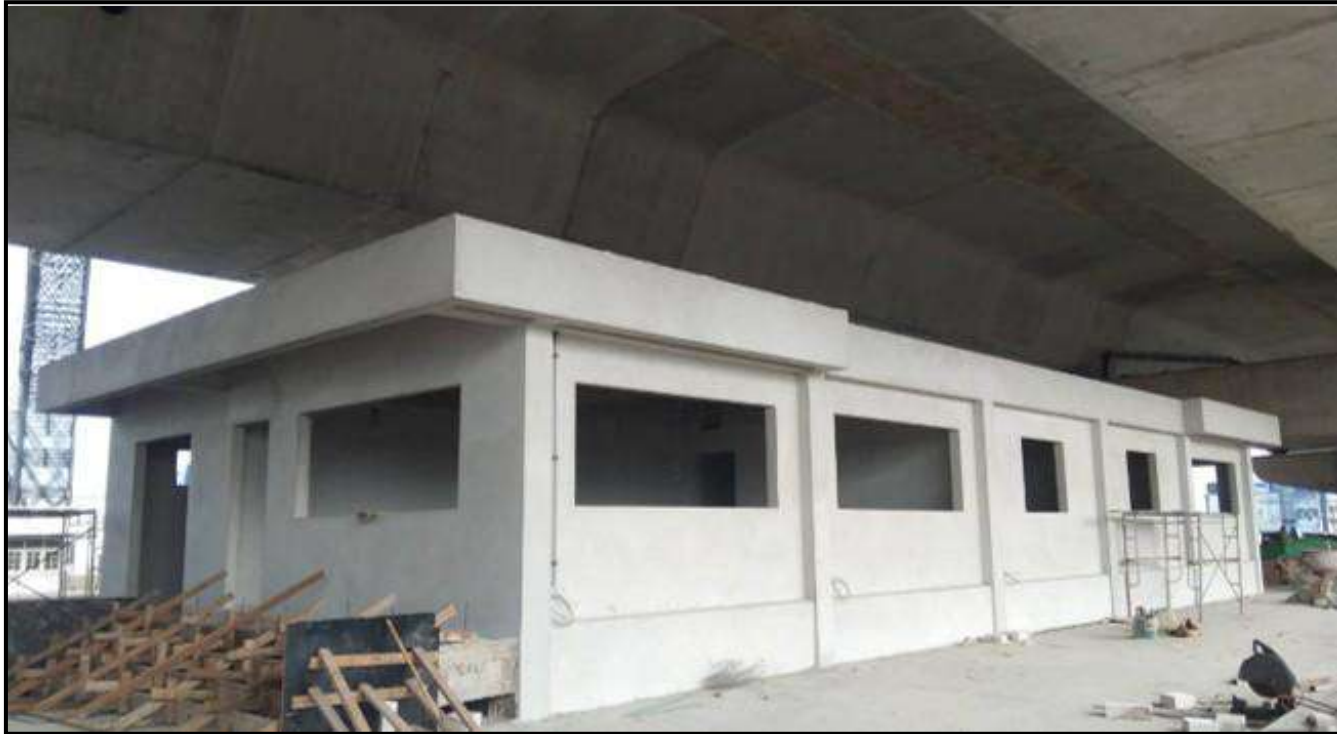
งานก่อสร้างอาคาร Rescue Substation Building (Ramp 2)
