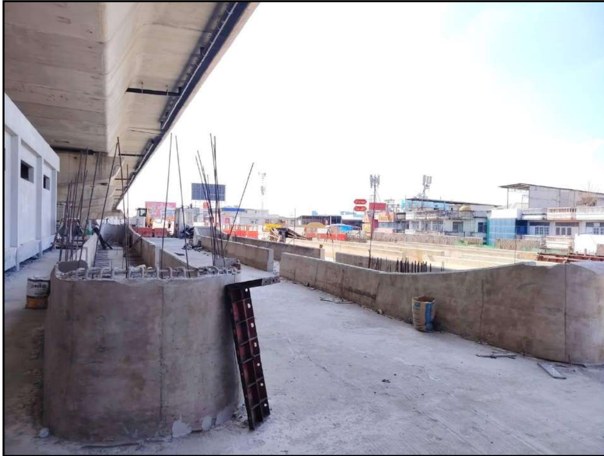
งานก่อสร้าง Toll Canopy - ด้านบางขุนเทียน
