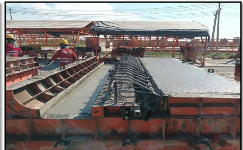
Install Reinforcement and Pouring Concrete Parapet Zone 1-2 ที่โรงหล่อสระบุรี
