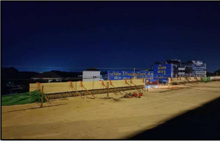
MLP01-07 to MLP01-08 Insall Precast Edge Parapet
