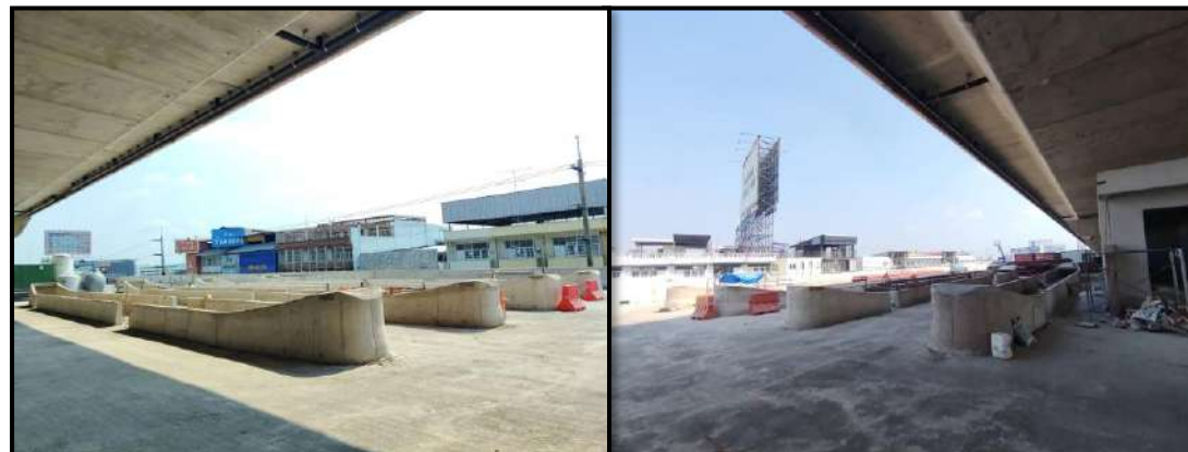
Toll Canopy - ด่านบางขุนเทียน
