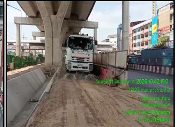
ดำเนินการฉีดพรมน้ำในเขตพื้นที่ก่อสร้าง
