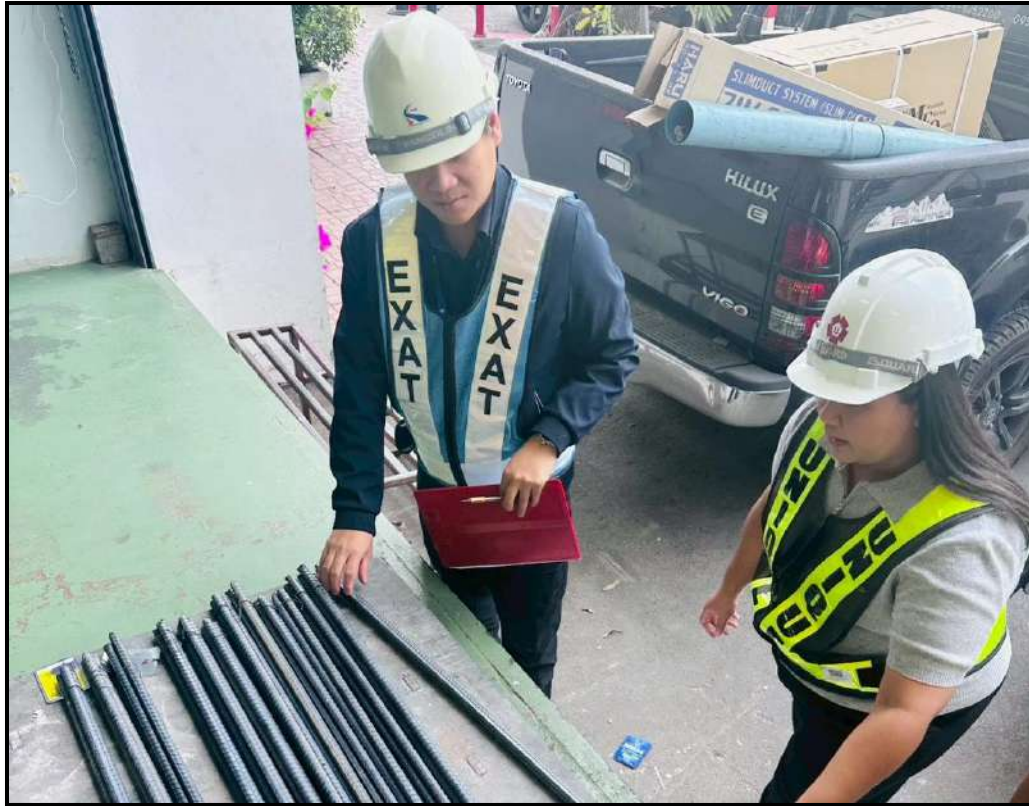
วันที่ 05/03/2569 Inspection & Testing Reinforcement Steel Bars (Control Test) Zone 1,2 Test By KMUTNB.
