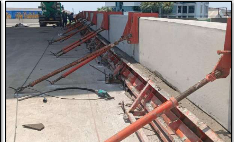
MLP01-04C Infill Concrete Precast Edge Parapet
