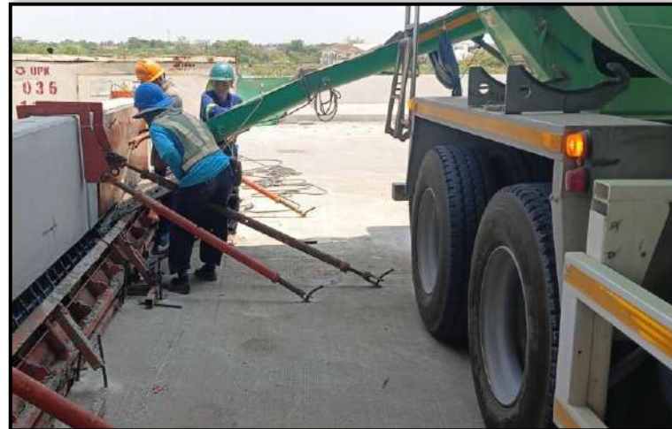
MLP01-04C Infill Concrete Precast Edge Parapet
