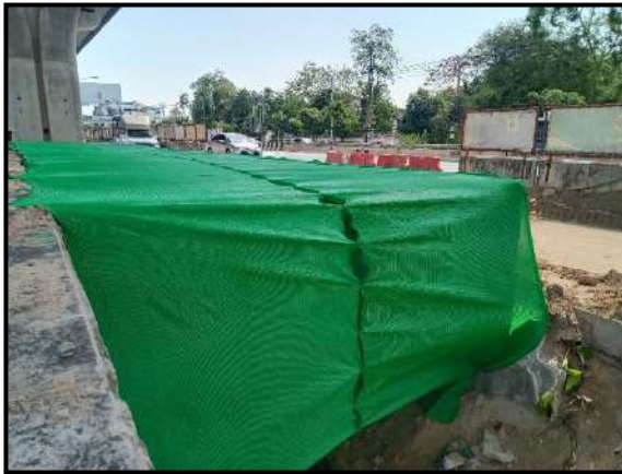
ดำเนินการปิดคลุมคลองสาธารณะในพื้นที่ก่อสร้าง
