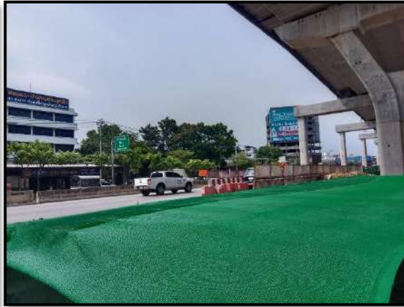
ดำเนินการปิดคลุมคลองสาธารณะในพื้นที่ก่อสร้าง
