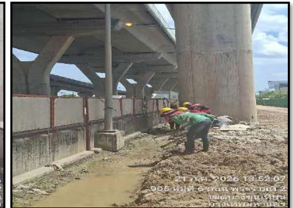
ดำเนินการขุดทำร่องน้ำในบริเวณพื้นที่ก่อสร้าง
