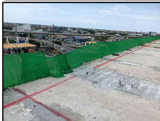
ดำเนินการติดตั้งตาข่ายป้องกันวัสดุตกหล่น
