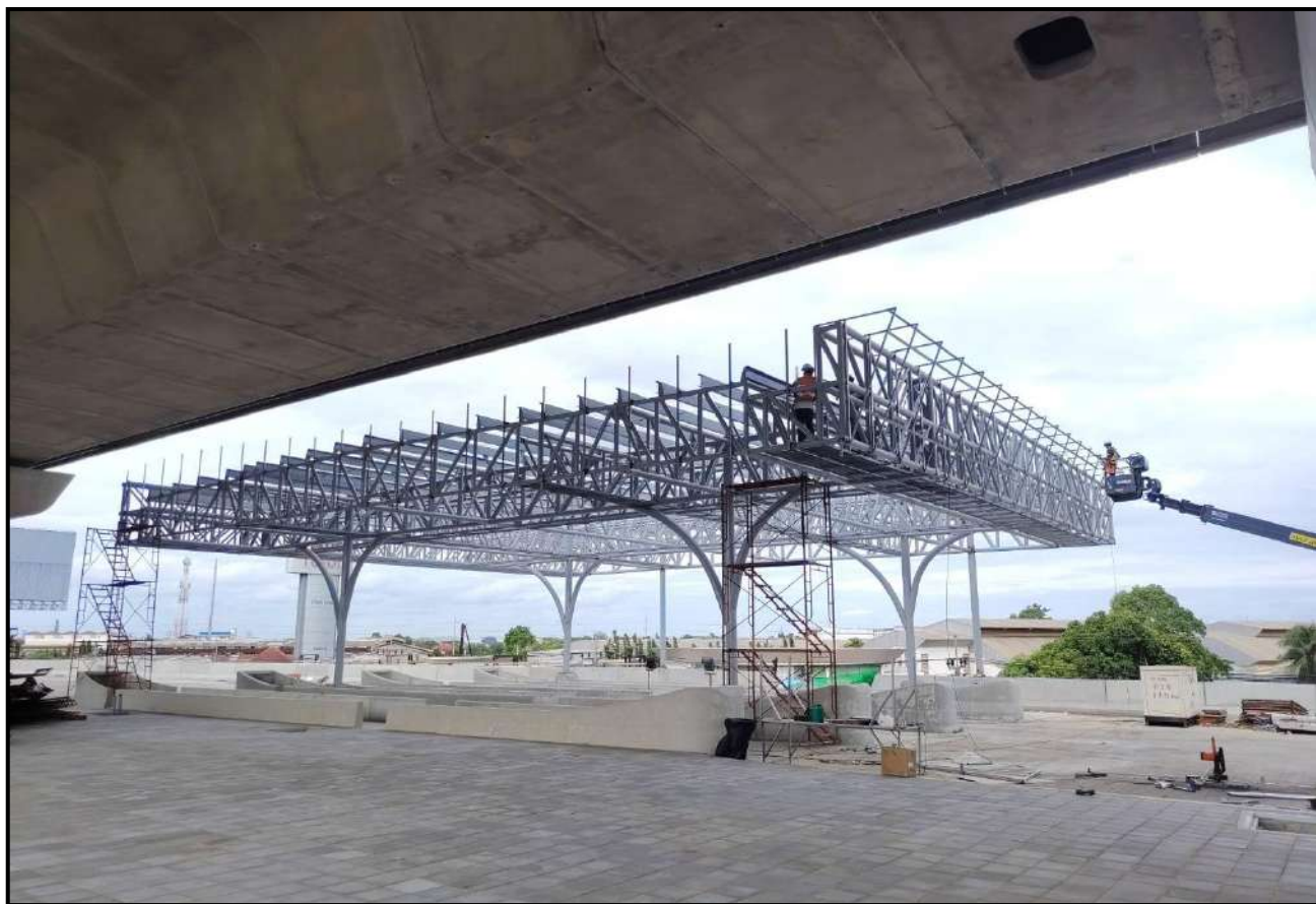
งานก่อสร้าง Toll Canopy - ด้านบางกระดี
